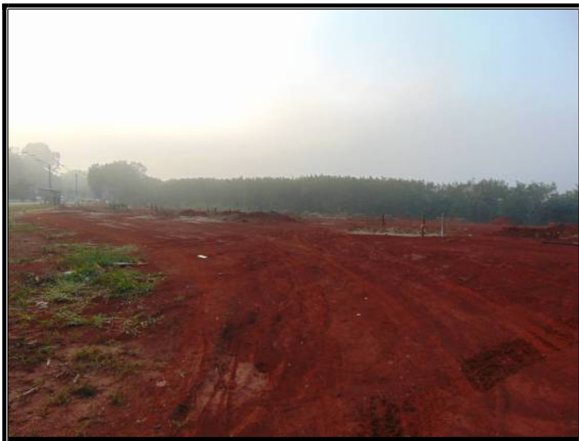
OUTRA VISTA DA GLEBA E DOS SERVIÇOS PRELIMINARES EXECUTADOS NA GLEBA.
