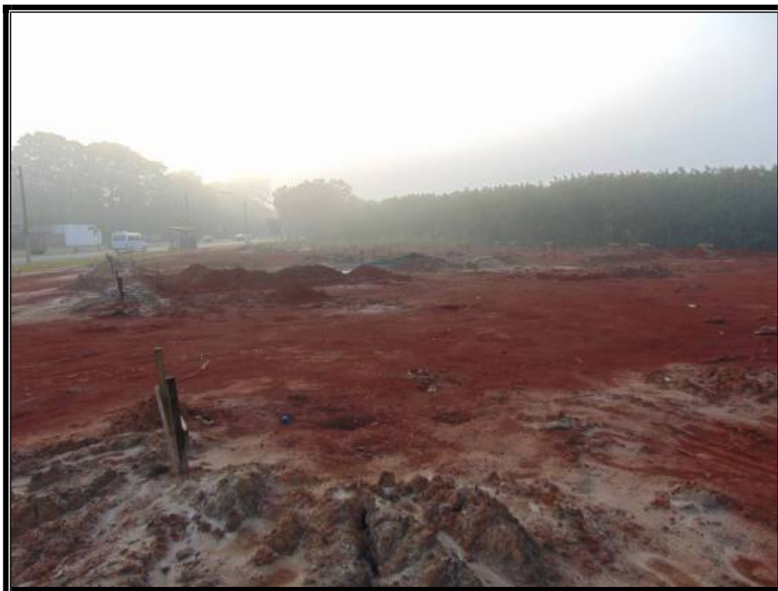
VISTA GERAL DE OUTRA FRAÇÃO DA GLEBA E DOS SERVIÇOS EXECUTADOS.
