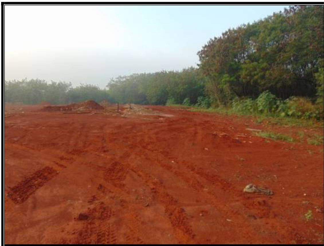
VISTA GERAL DA GLEBA, DESTACANDO-SE O INÍCIO DOS SERVIÇOS PRELIMINARES PARA A IMPLANTAÇÃO DOS LOTES.
