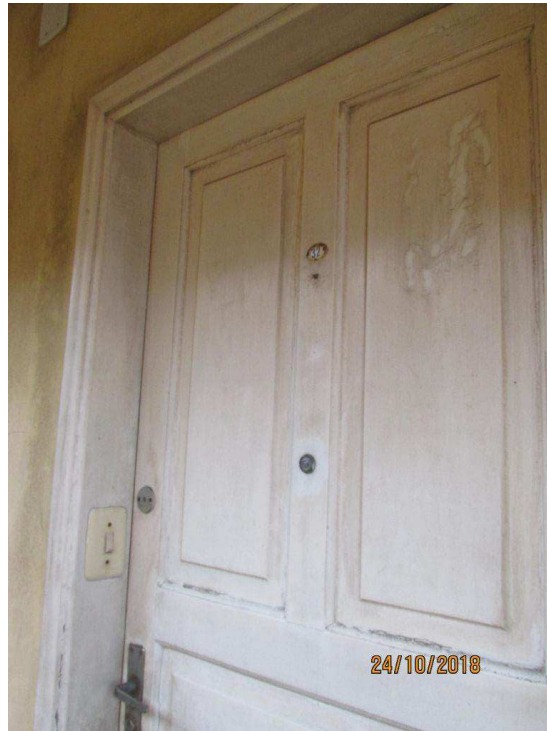
Foto 6 - Porta de entrada do imóvel avaliando
