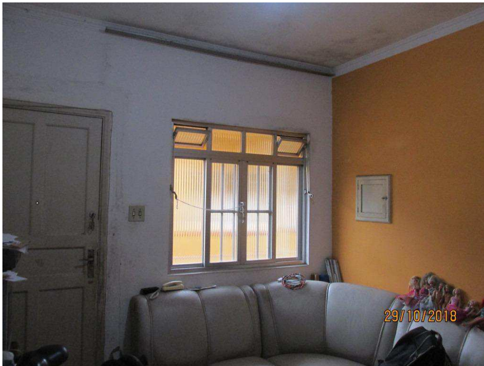
Foto 8 - Vista geral da sala; manchas no teto e paredes.
