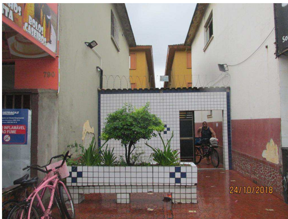
Foto 24 - Detalhe do muro e portão de acesso pela Av. Antônio Emmerick
