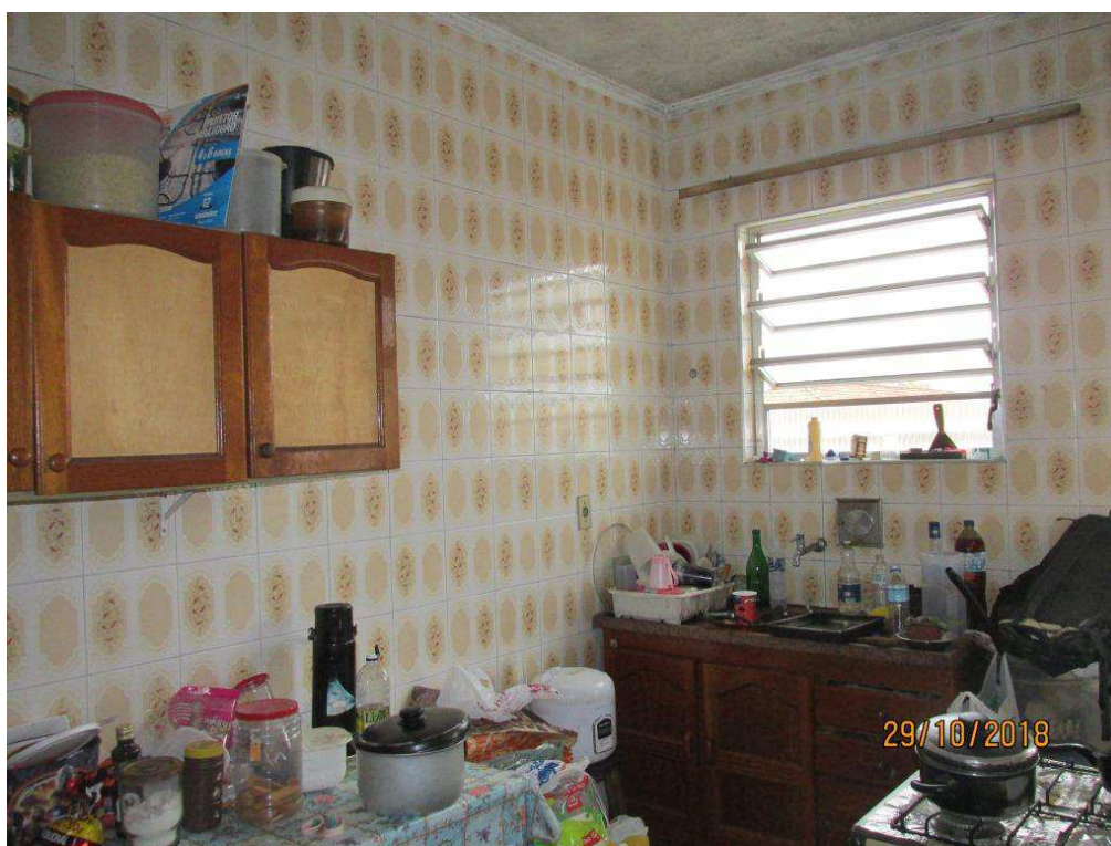
Foto 15 - Vista da cozinha; gabinete sob pia; manchas no teto; armários não vinculados ao imóvel e não computados na avaliação.
