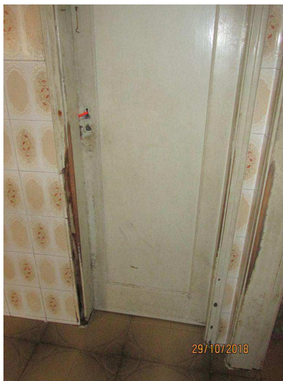
Foto 14 - Hall interno; portas e batentes em geral em mau estado
