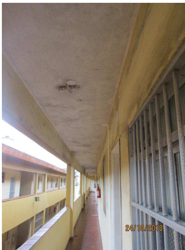
Foto 3 - Idem foto acima; observamos o mau estado de conservação das áreas comuns.
