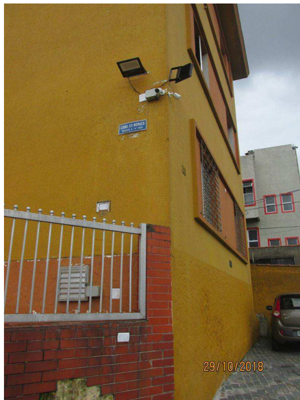
Foto 31 - Detalhe da parte frontal do Bloco "A"
