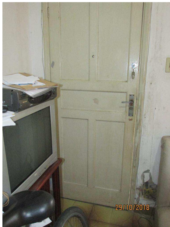
Foto 7 - Detalhe da porta de entrada do imóvel na sala
