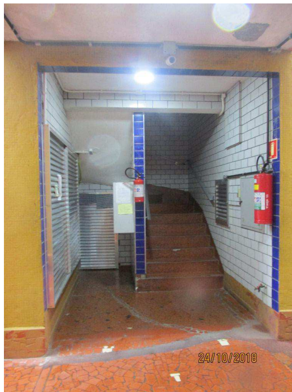
Foto 5 - Hall e escadaria de acesso ao imóvel
