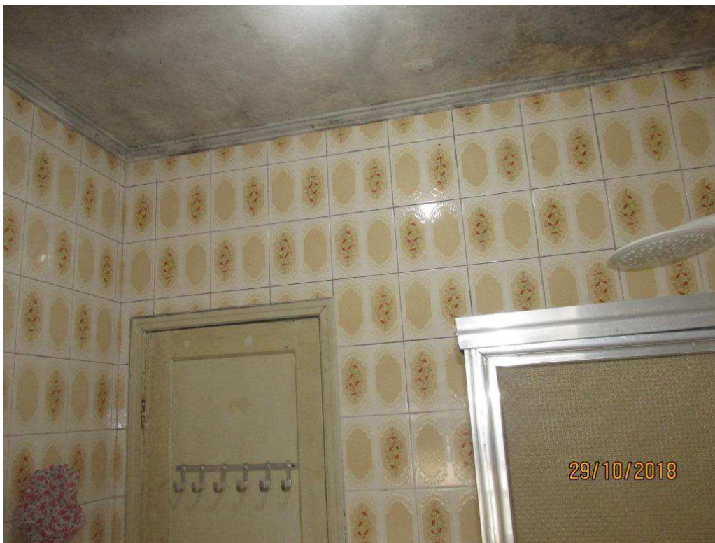
Foto 19 - Banheiro tem os mesmos detalhes; box do chuveiro em alumínio
