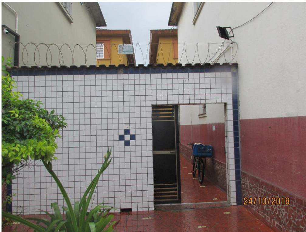
Foto 23 - Muro e portão de acesso para pessoas pela Av. Antônio Emmerick
