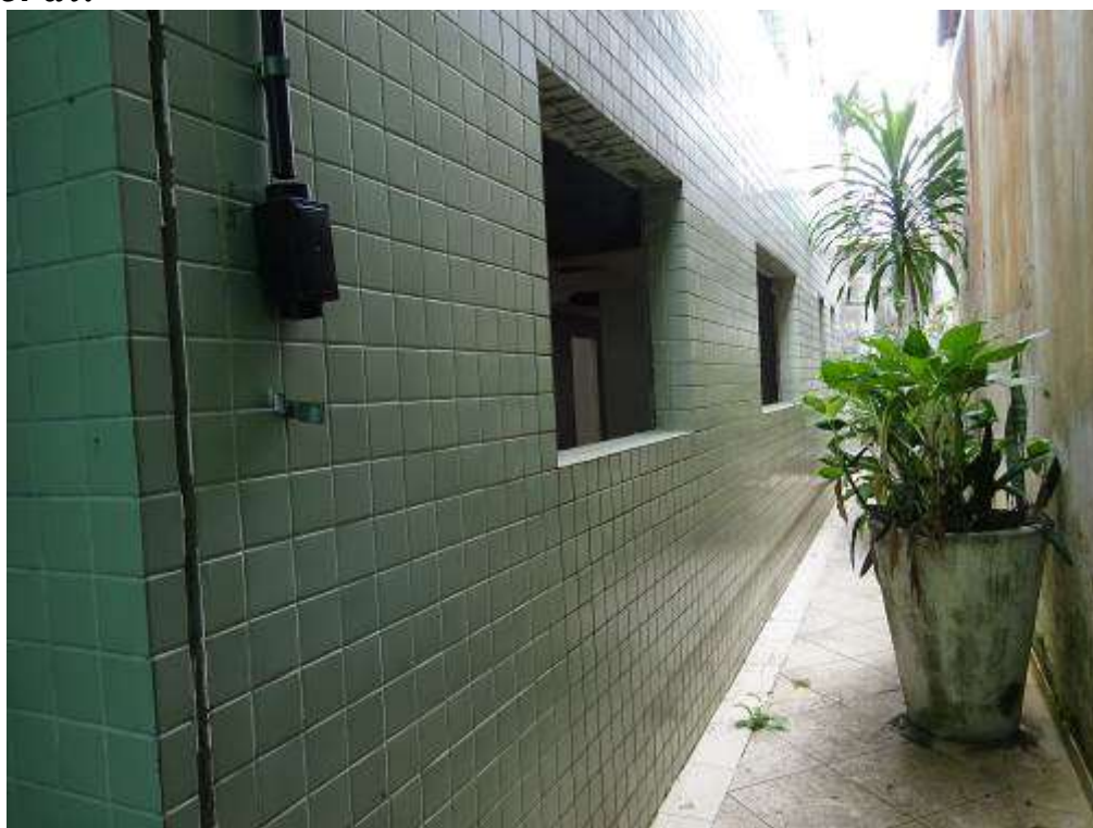
FOTO 03: Pavimento Térreo: Vista da área de recuo lateral.
