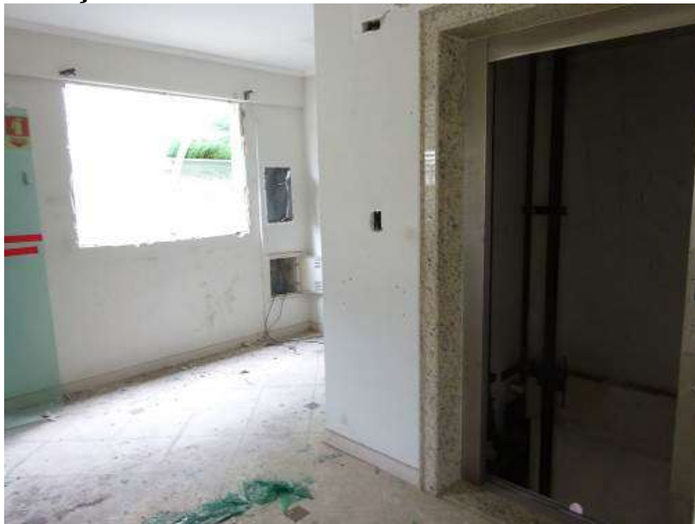
FOTO 06: Pavimento Mezanino: Vista de hall de distribuição.
