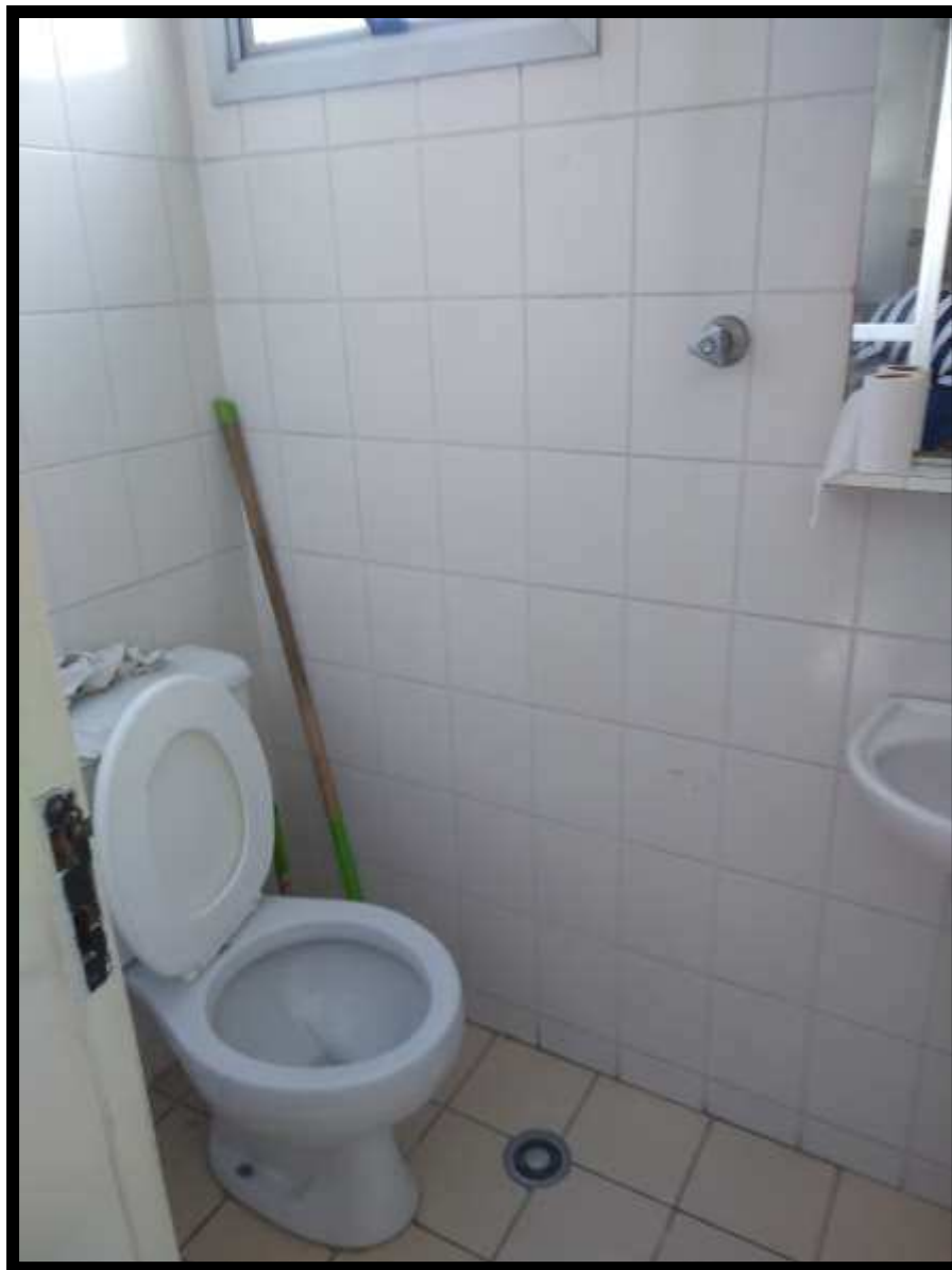
VISTA DO BANHEIRO DE EMPREGADA
