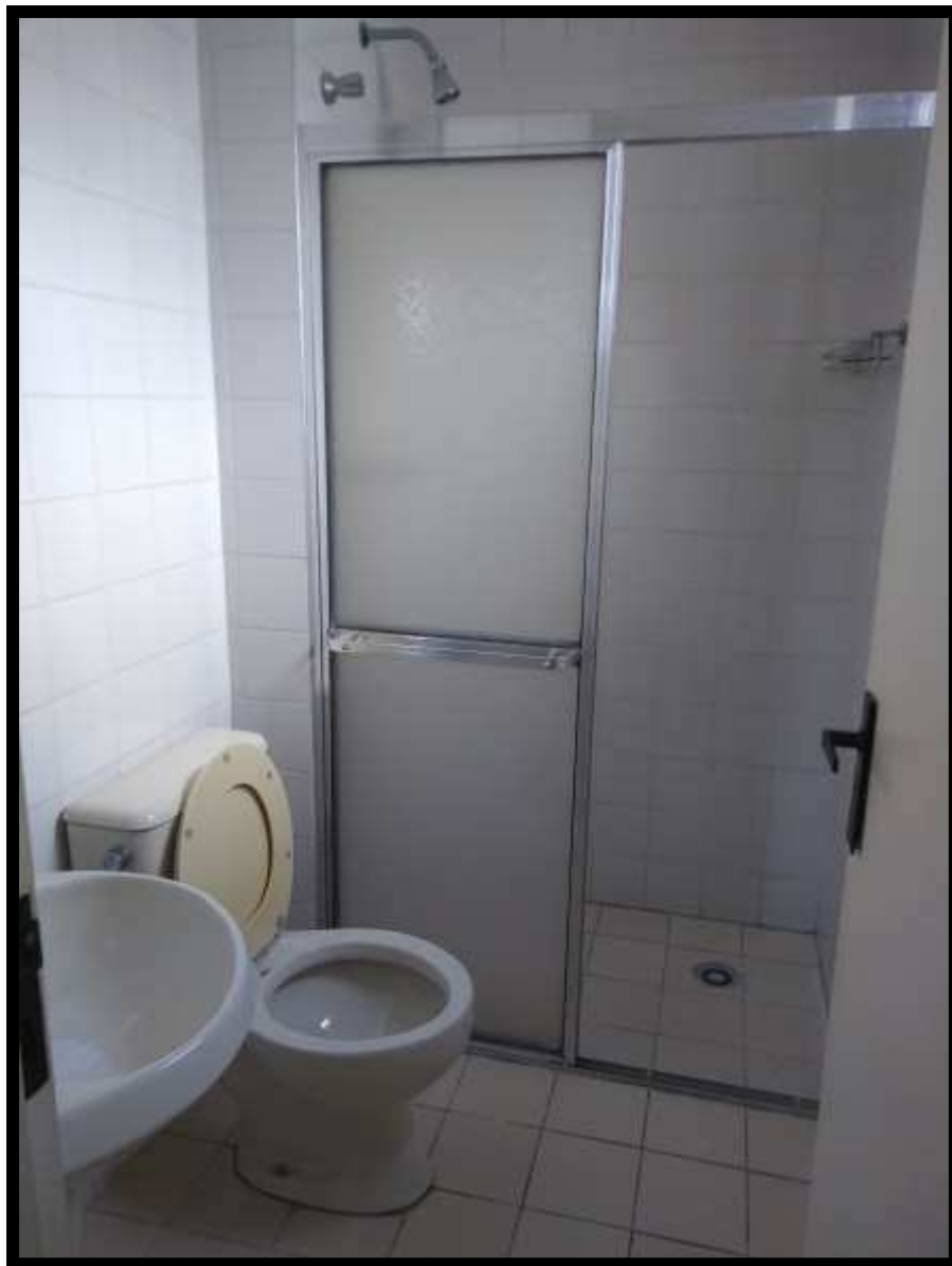
VISTA DO BANHEIRO DA SUÍTE
