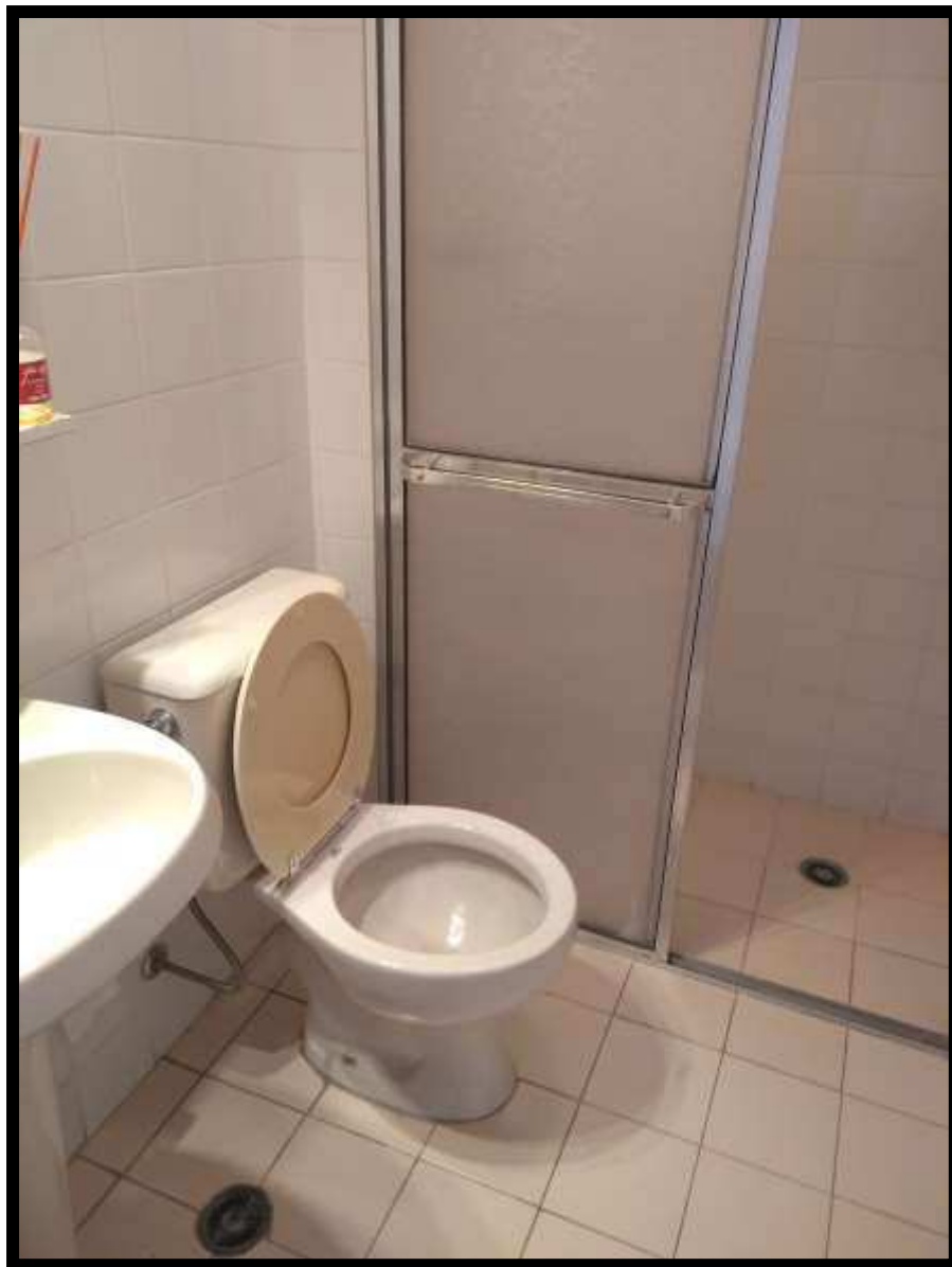
VISTA DO BANHEIRO SOCIAL
