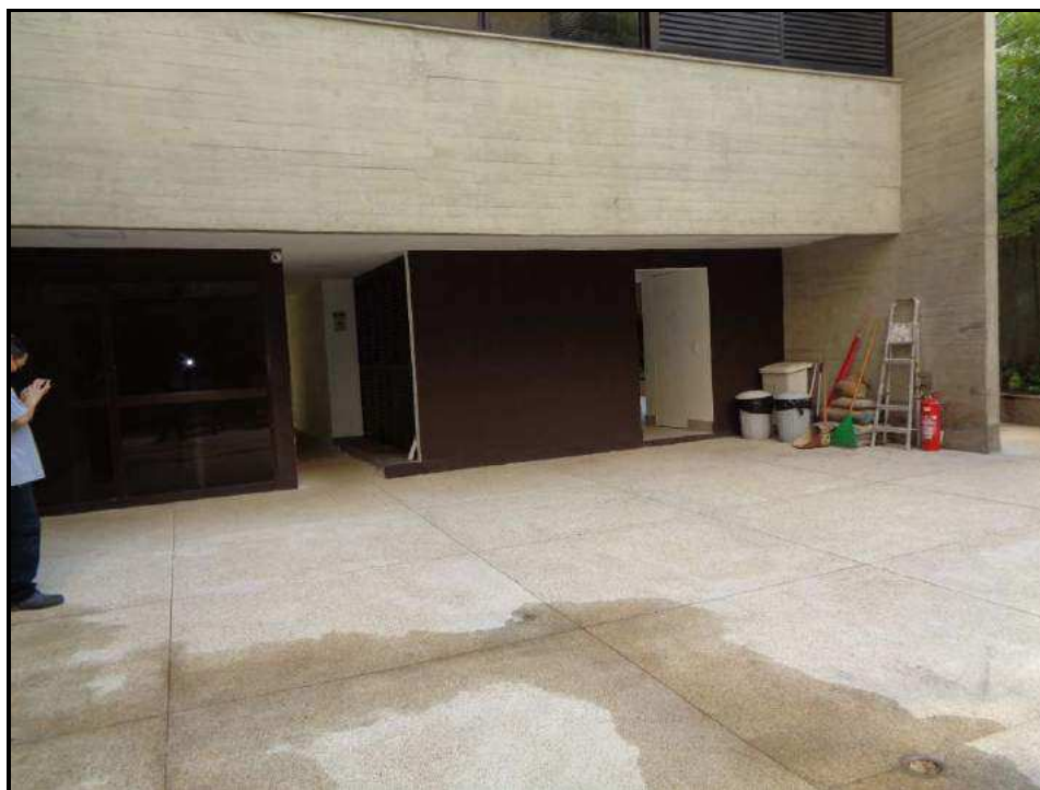
Foto 35: Spa (em obras)
