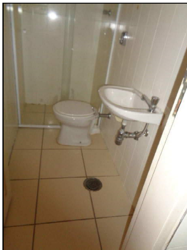
Foto 28: Banheiro de empregada
