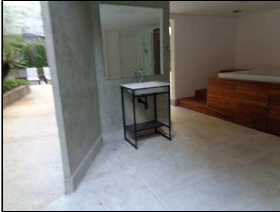
Foto 37: Hidromassagem (em obras)
