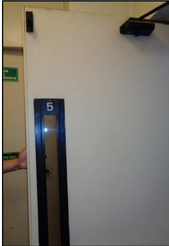
Foto 7: Elevador de serviço no 5º andar
