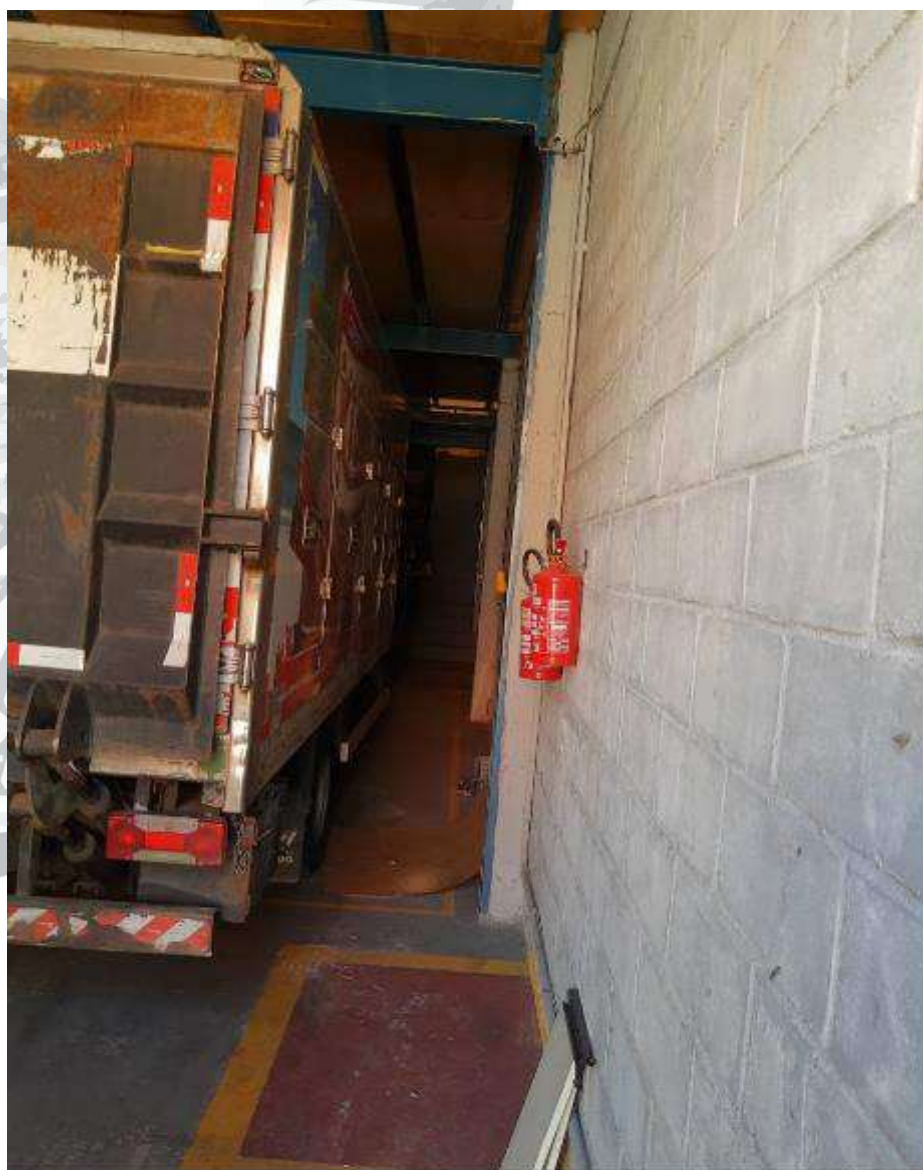
VISTA GERAL INTERNA DO GALPÃO
