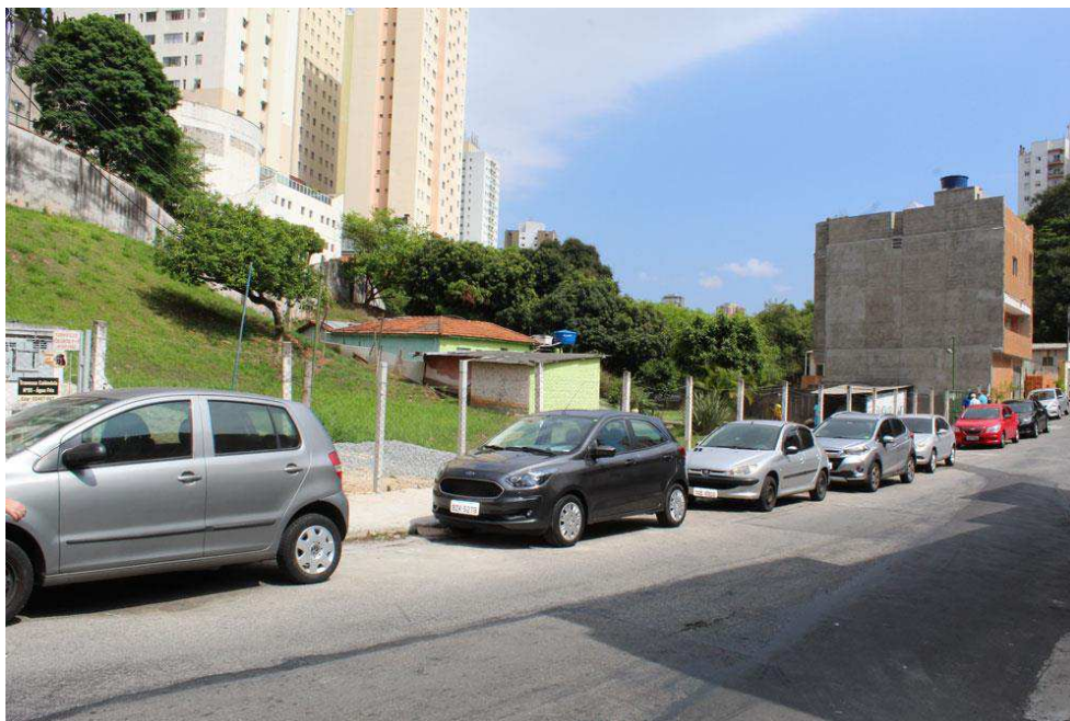
FOTO 6: Vista da testada do imóvel avaliando
