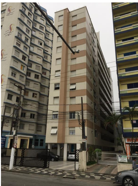
Figura 2: Vista geral do imóvel.
