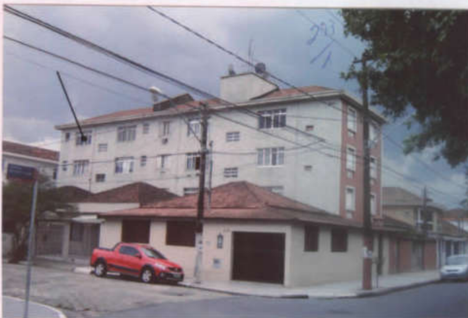
FOTO 02: - Localização do apartamento nº 34 – 3º andar-tipo do Edifício “Borges”, nos fundos da edificação.
