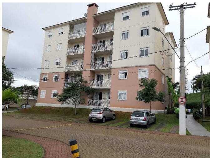
Vista 1 do Edifício Vista da Serra.
