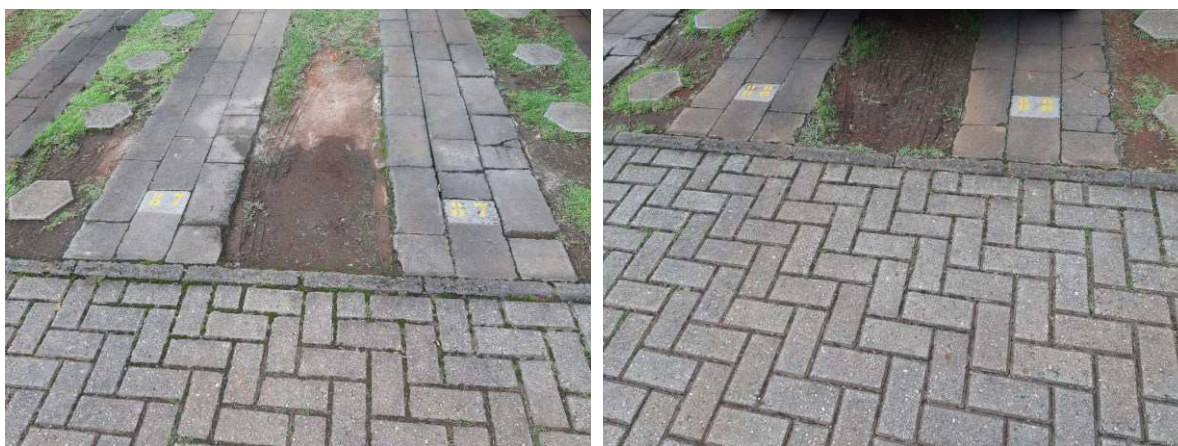
Detalhe das vagas de garagem.
