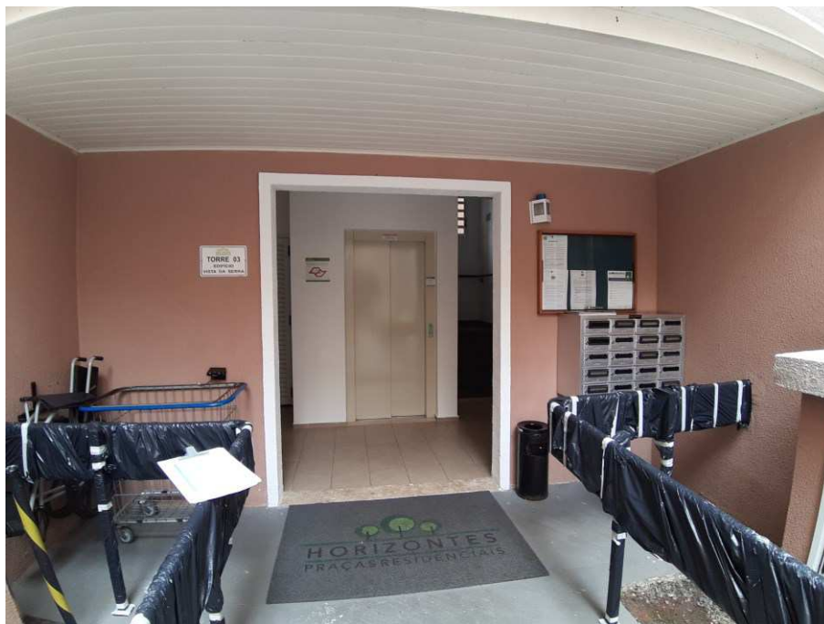
Detalhe do acesso às unidades.
