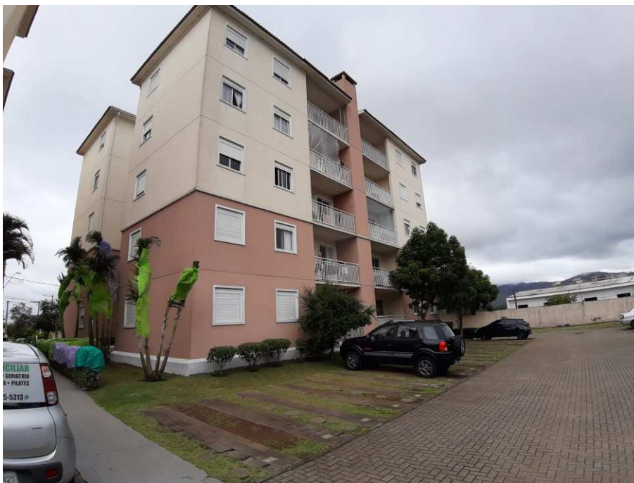
Vista frontal do Edifício Vista da Serra.
