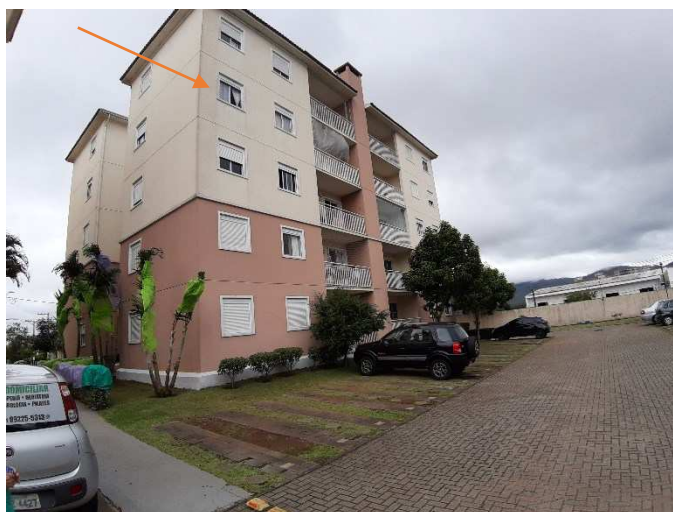
Vista 2 do Vista do Edifício Vista da Serra.
