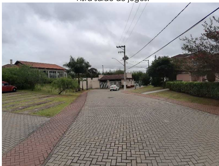
Vista parcial acesso a portaria.
