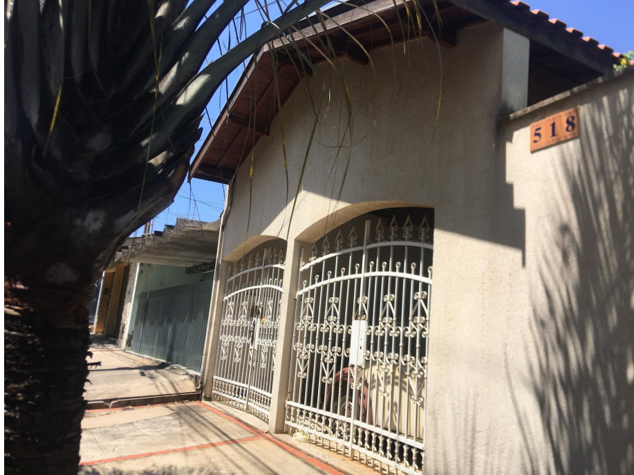
Vista externa do imóvel
