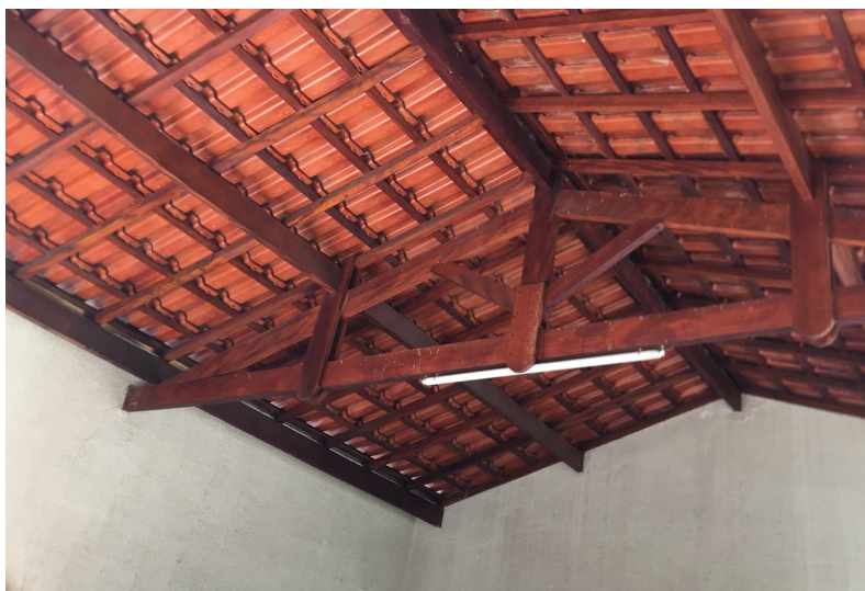
Vista do telhado da garagem
