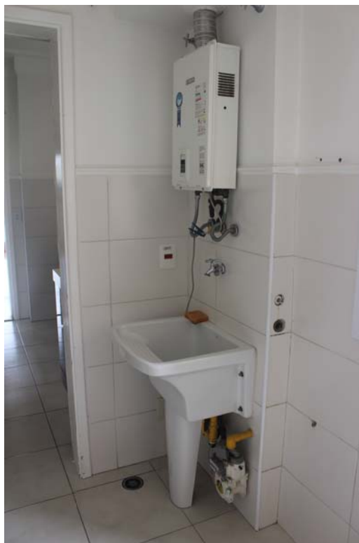
Fotografia 14 – Aspecto da área interna tipo das unidades (em analogia com a unidade 93).
