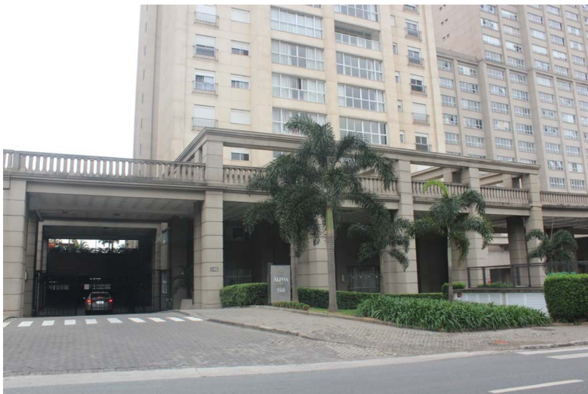
Fotografia 03 – Aspecto da recepção do Condomínio Edifício Alpha Square.
