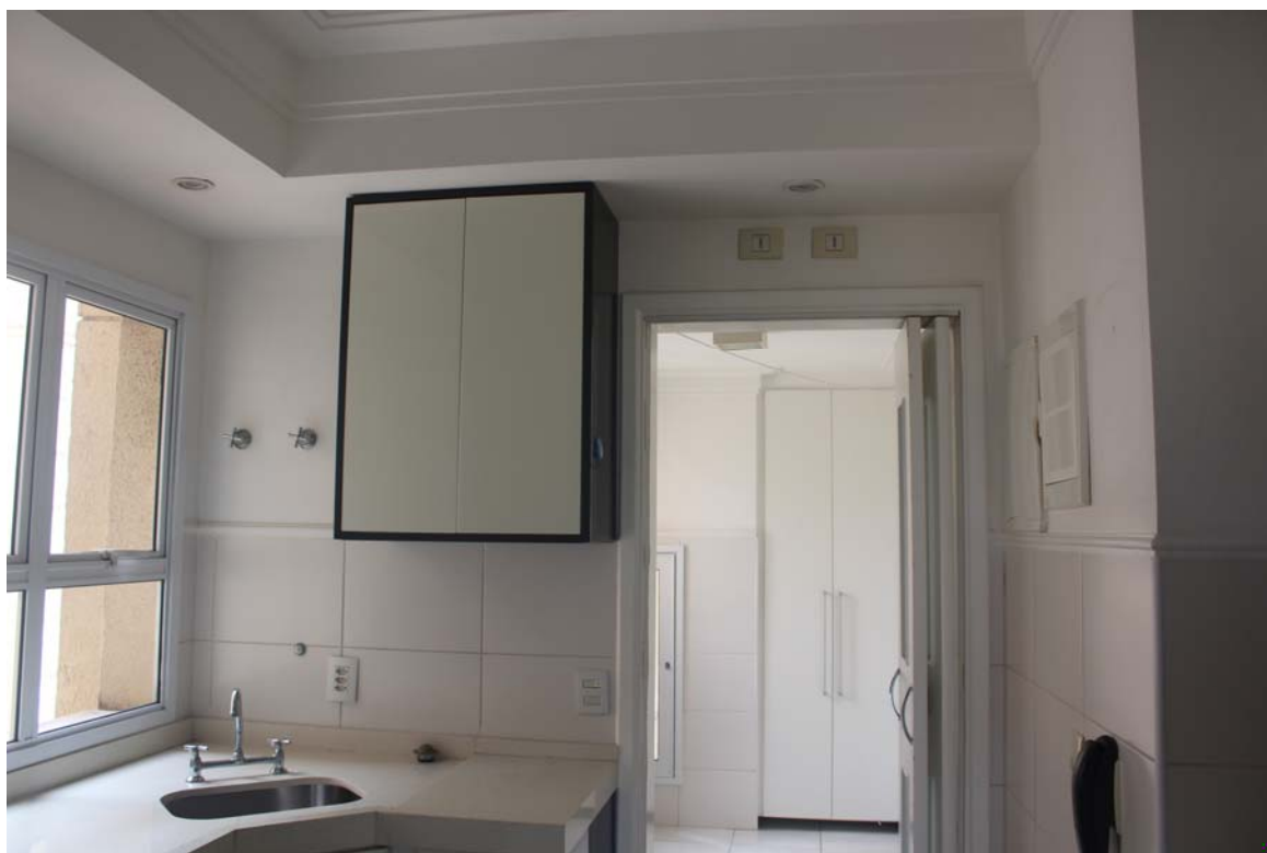
Fotografia 13 – Aspecto da área interna tipo das unidades (em analogia com a unidade 93).
