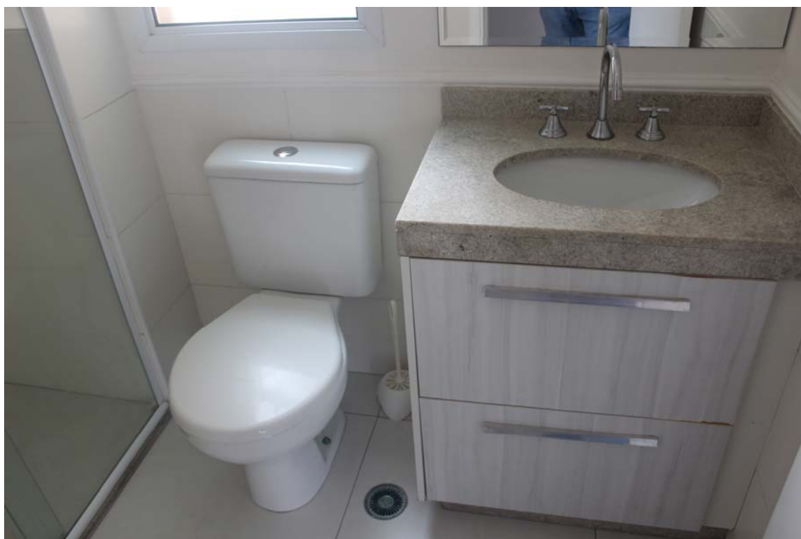
Fotografia 15 – Aspecto da área interna tipo das unidades (em analogia com a unidade 93).
