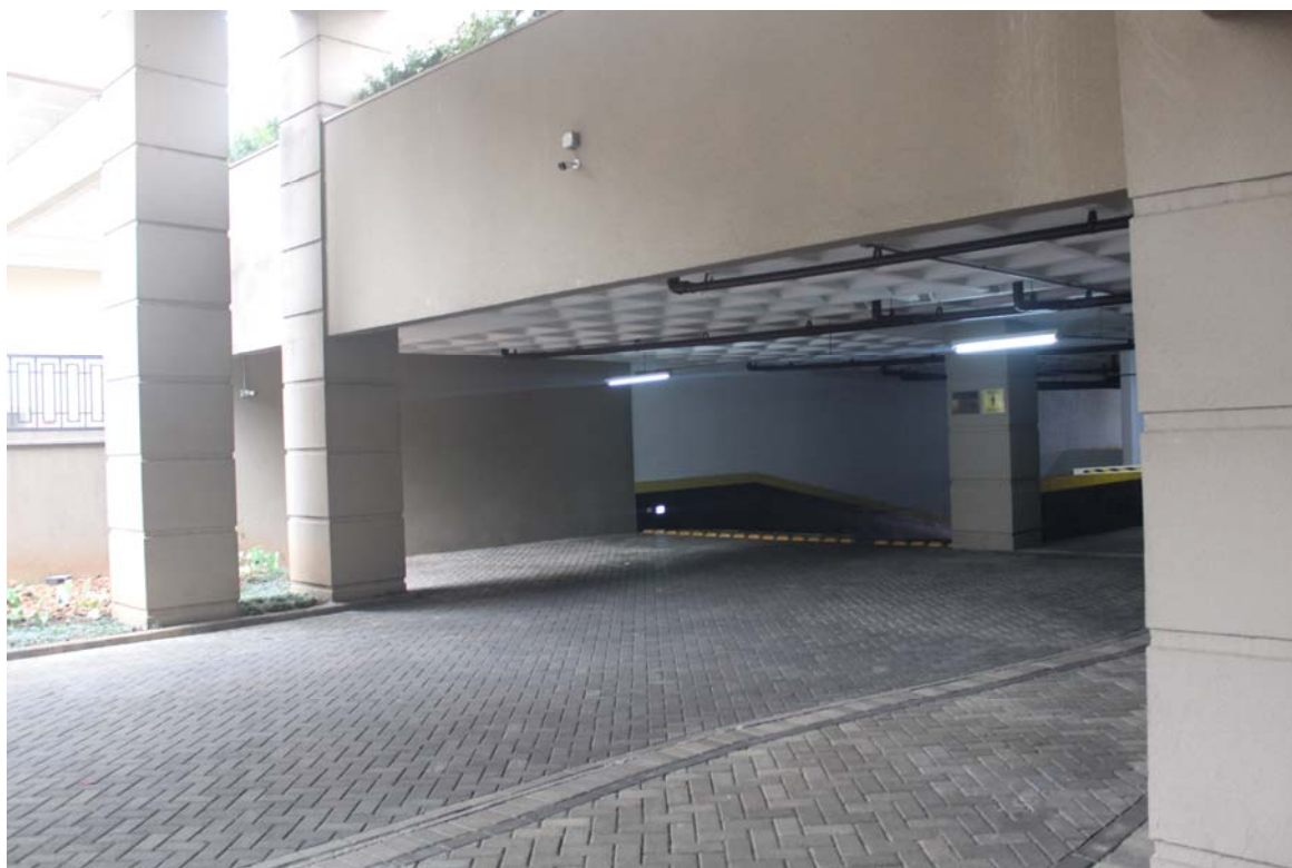
Fotografia 04 – Aspecto da área de acesso ao estacionamento.
