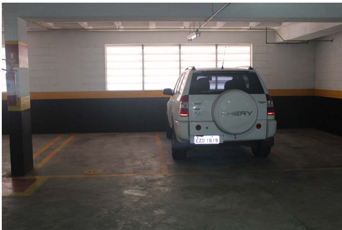
Fotografia 06 – Aspecto das vagas 19 e 20 do 3º subsolo, de uso da unidade 234.
