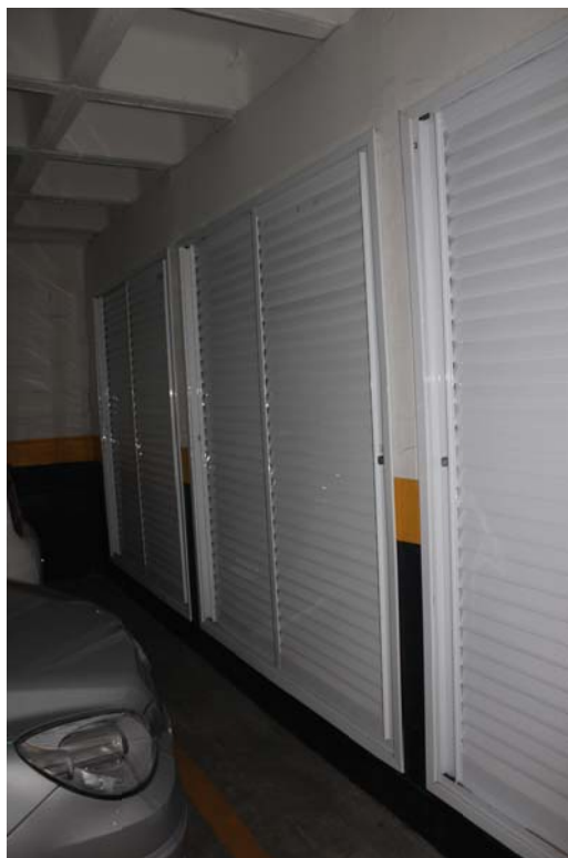
Fotografia 05 – Aspecto do armário depósito no 3º subsolo.
