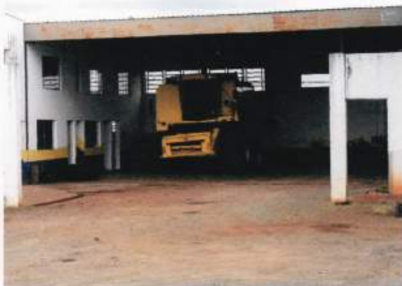
Foto 32 – Mostrando um anexo do prédio.
