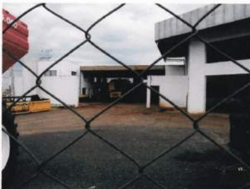
Foto 28 – Mostrando outras construções anexas ao prédio principal.
