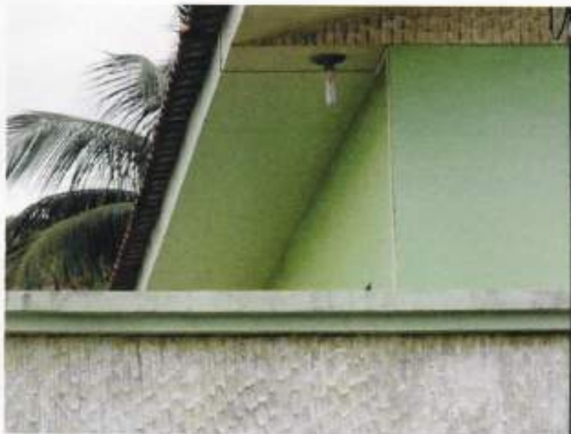
Foto 07 – Mostrando alguns detalhes da cobertura da casa.
