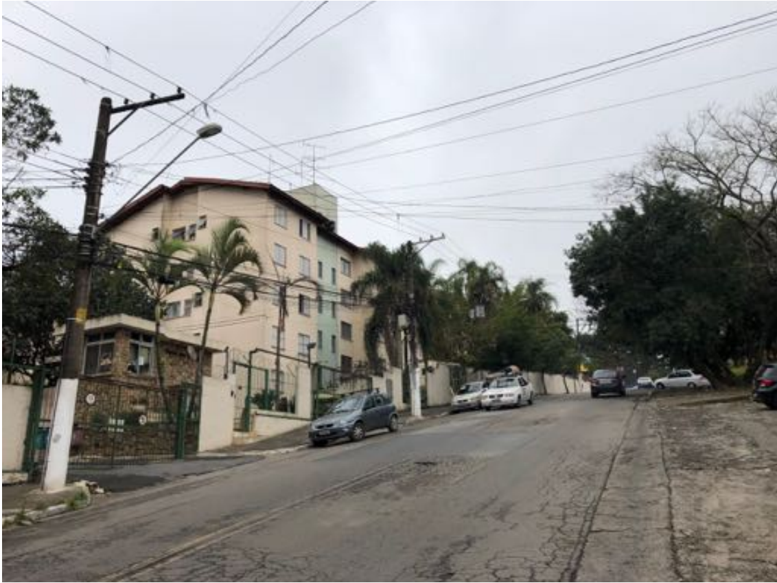
Vista Rua Luiz de Oliveira (a direita do condomínio)
