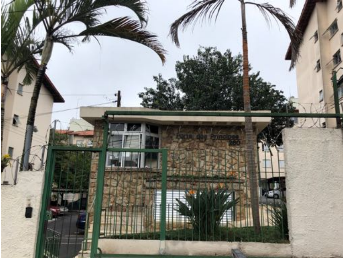
Edifício Condomínio Portal do Príncipes
