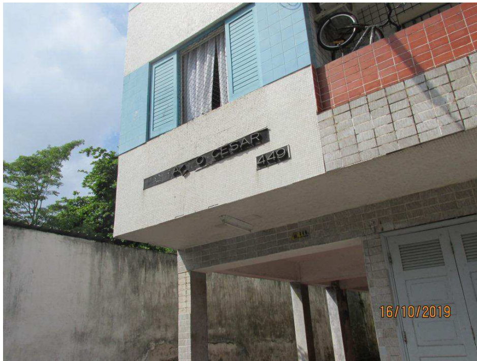
Foto 2 – Detalhe da fachada
