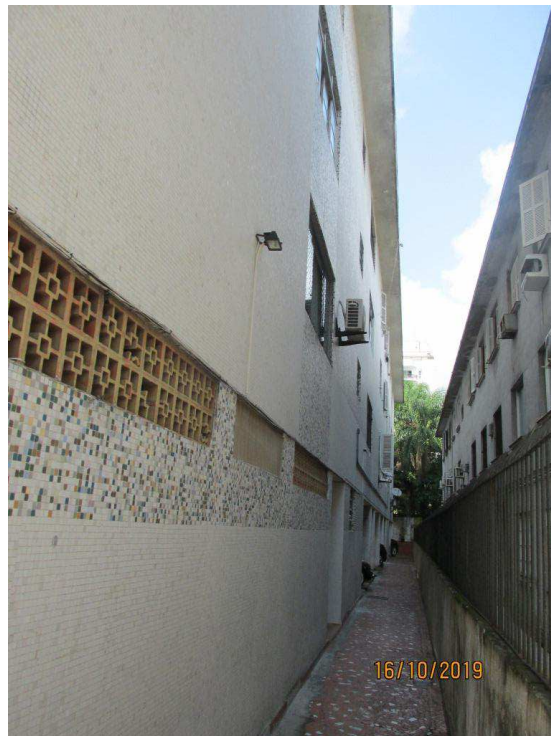
Foto 4 – Corredor de passagem lateral do prédio
