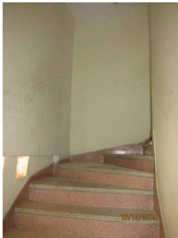
Foto 13 - Detalhe típico das escadarias
