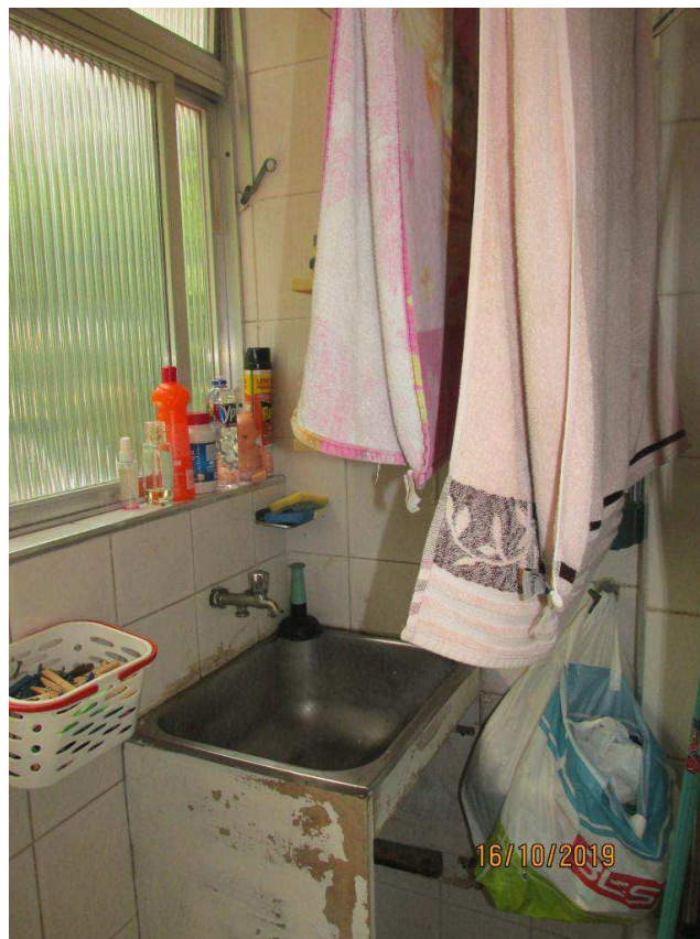
Foto 21 – Área de serviço
