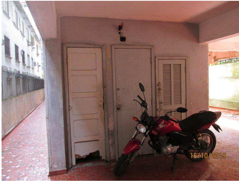
Foto 6 – Depósito e vista parcial da garagem
