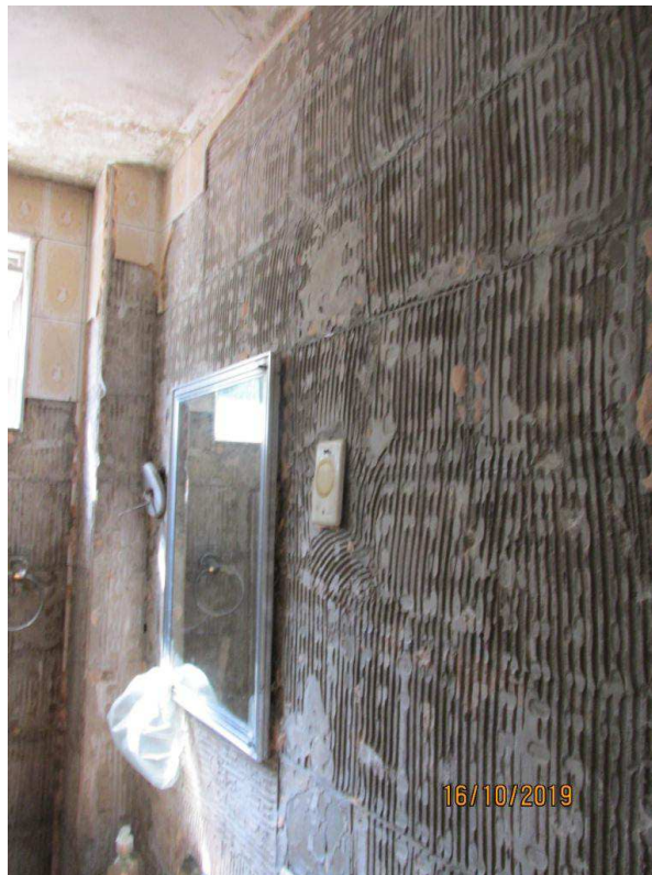
Foto 18 – Vista do banheiro, sem o revestimento de azulejos
