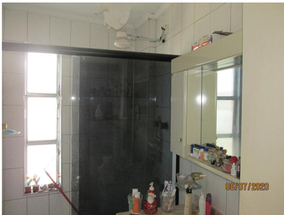
Foto 14 – Banheiro social, completo com fechamento do box do chuveiro em vidro temperado
