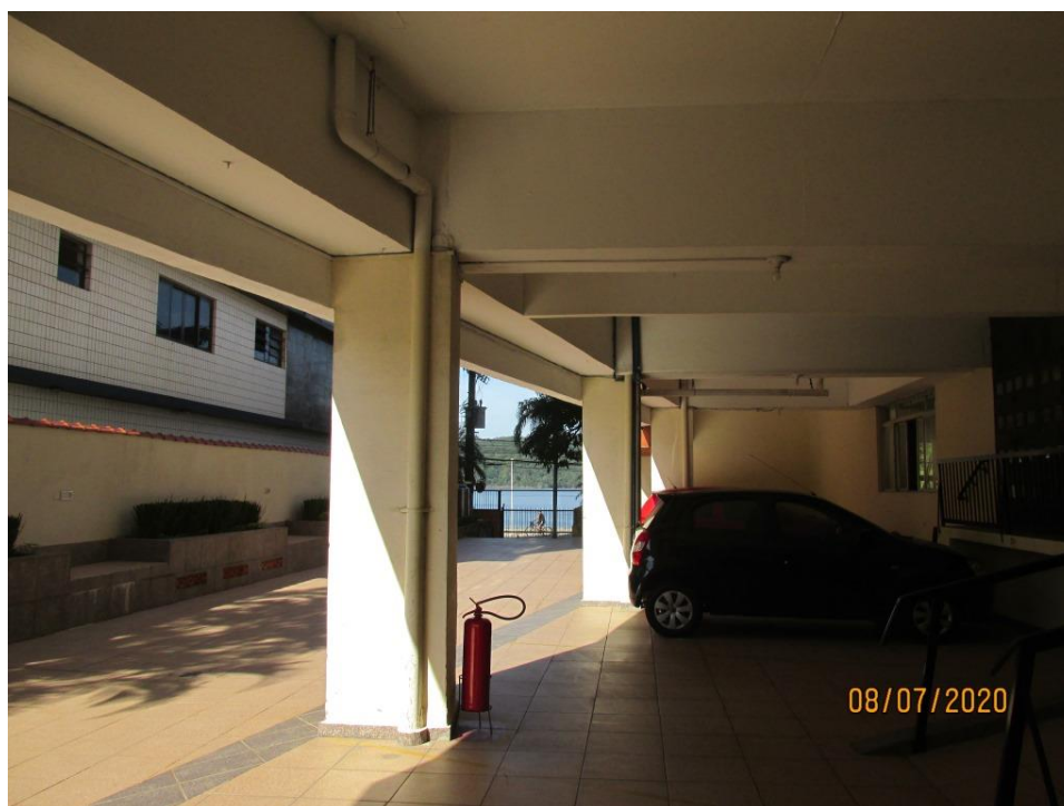
Foto 27 – Vista da garagem no térreo
