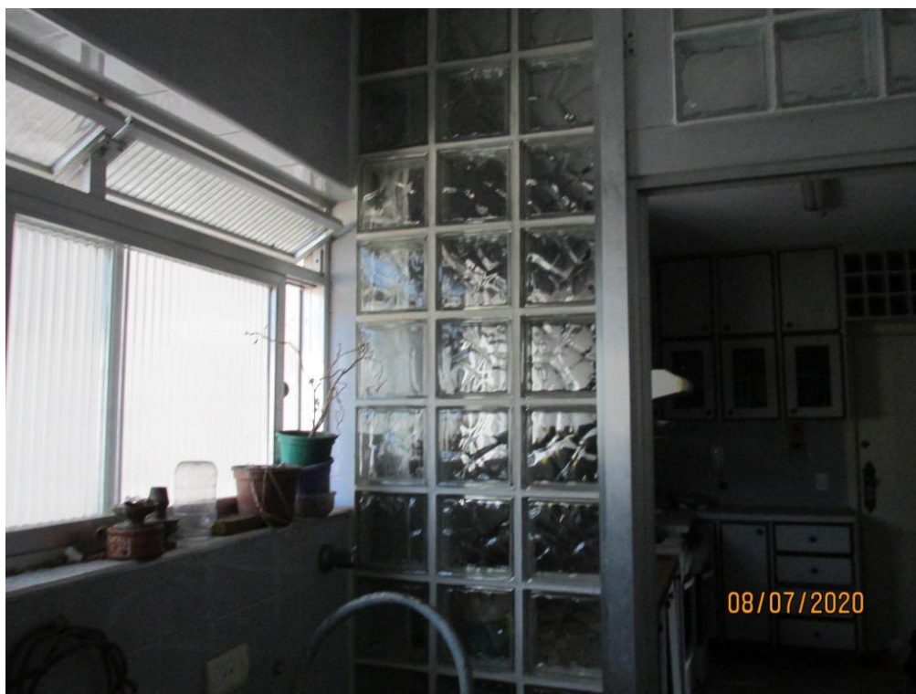
Foto 16 – Área de serviço, separada da cozinha por blocos de vidro
