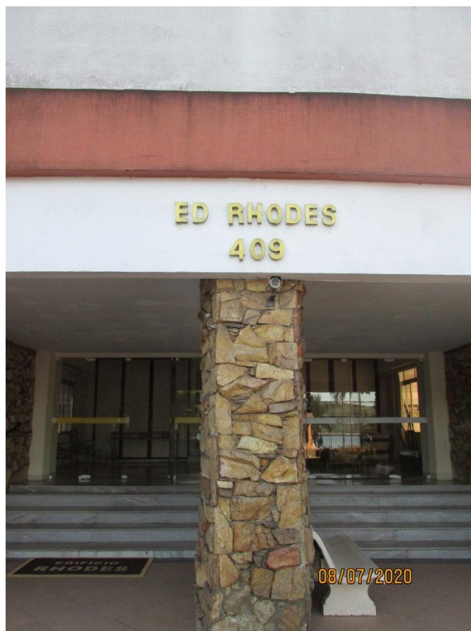
Foto 4 – Detalhe da entrada principal do Edifício RHODES
