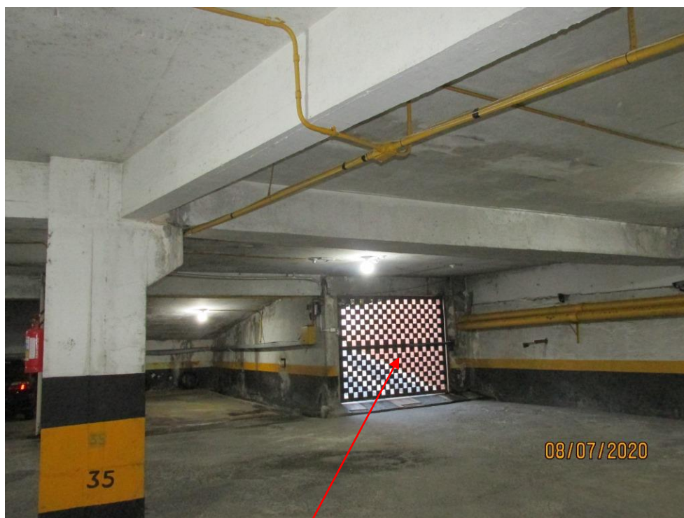
Foto 26 – Entrada para garagem no subsolo
