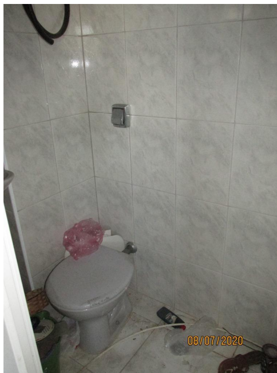
Foto 20 – Outro detalhe do banheiro de empregada
