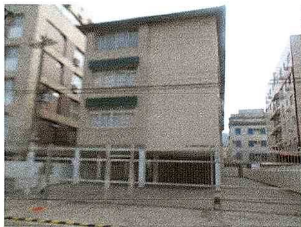
Tomada mostrando a fachada frontal do Condomínio Edifício Porto Menino – R. Da. Vitória Yunes Estéfano, 139, bairro Enseada, município de Guarujá-SP.
