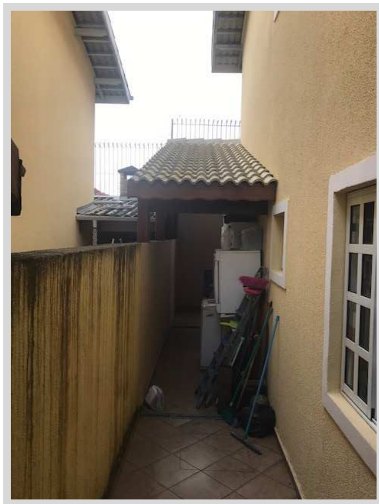
Corredor lateral externo de acesso aos fundos (quintal) da casa avalianda.
