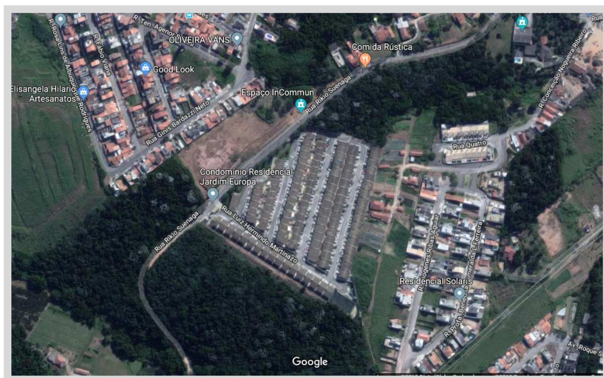
Vista aérea do Condomínio Residencial Jardim Europa.
