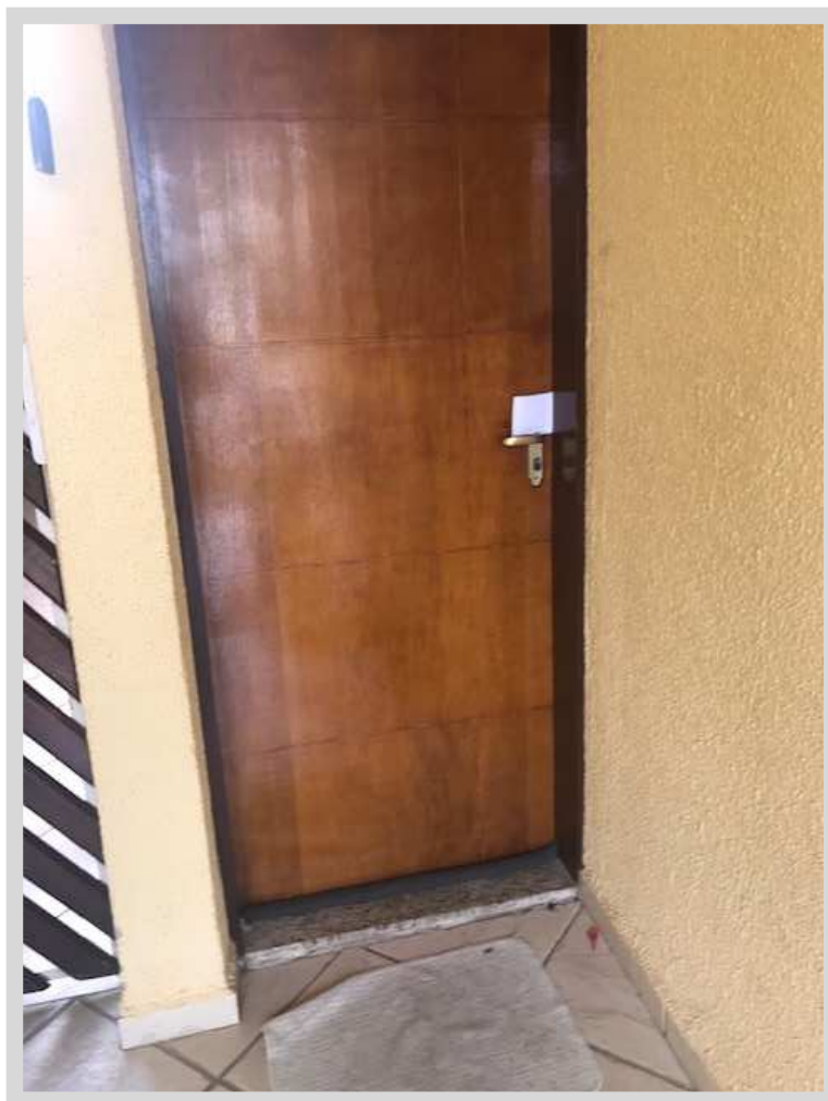
Porta de acesso a sala da casa avalianda.
