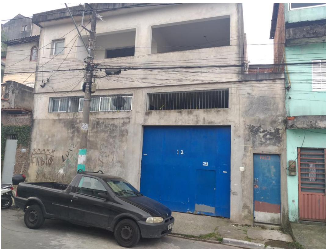
Foto 2 - Vista da fachada do Edifício em questão, o portão com nº 12 local vistoriado, porta lateral de acesso ao imóvel locado
