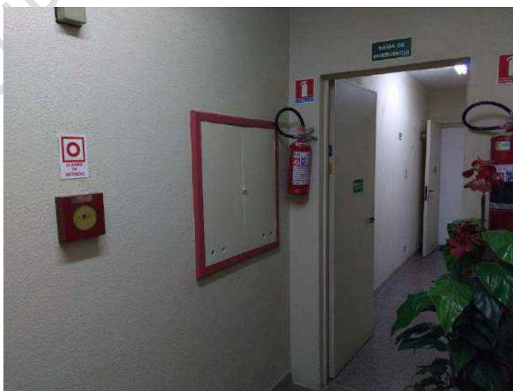
sistema contra incêndio
