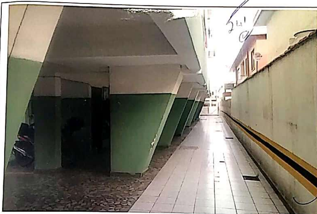
Foto 6 - Área da garagem, no fundo do edifício; estado de conservação é regular.
