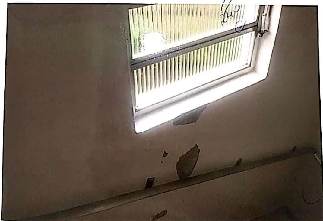
Foto 7 - Revestimento esborado das paredes na escadaria.
