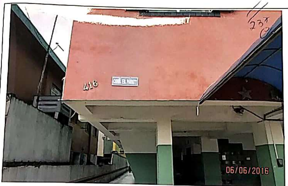
Foto 2 - Vista do pavimento térreo utilizado como garagem dos condôminos
