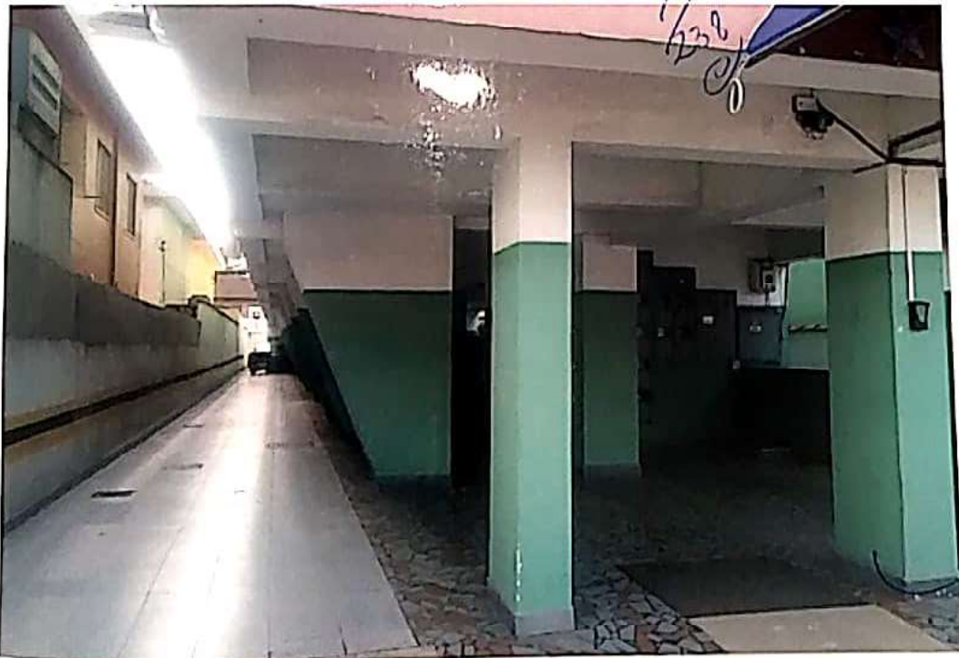
Foto 5 - Outra vista da garagem no térreo do edifício.
