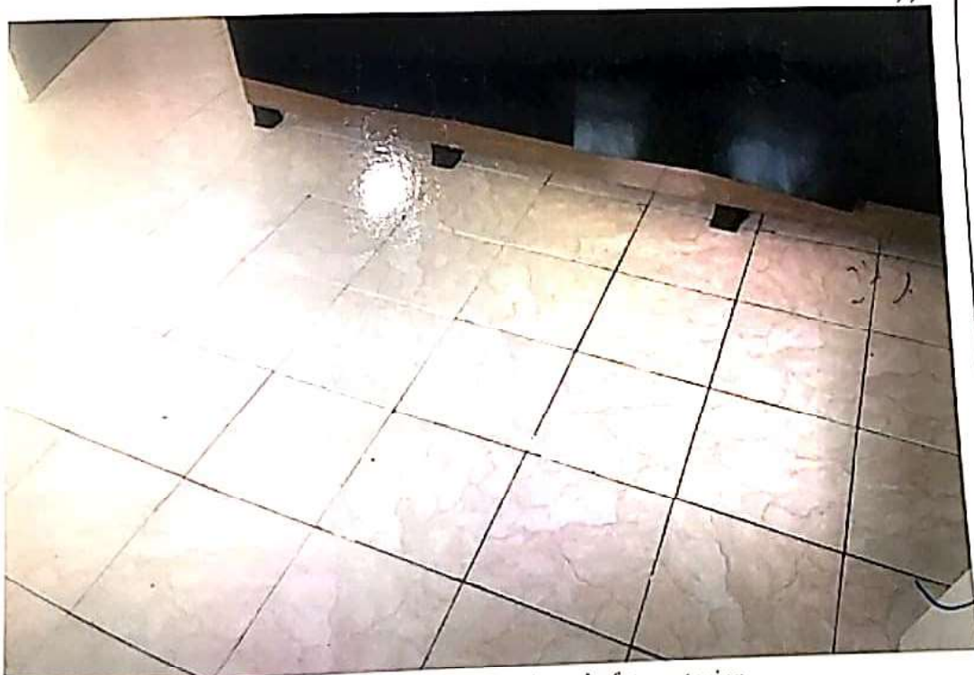
Foto 12 - Desgaste do rejunte no piso do dormitório da foto anterior.
