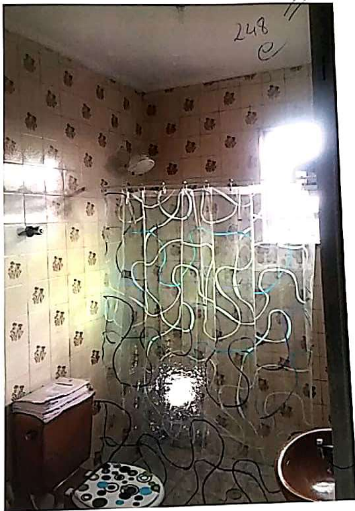
Foto 14 - Banheiro com revestimento em azulejos até o teto; louças coloridas cor marrom; não há box para o chuveiro.
