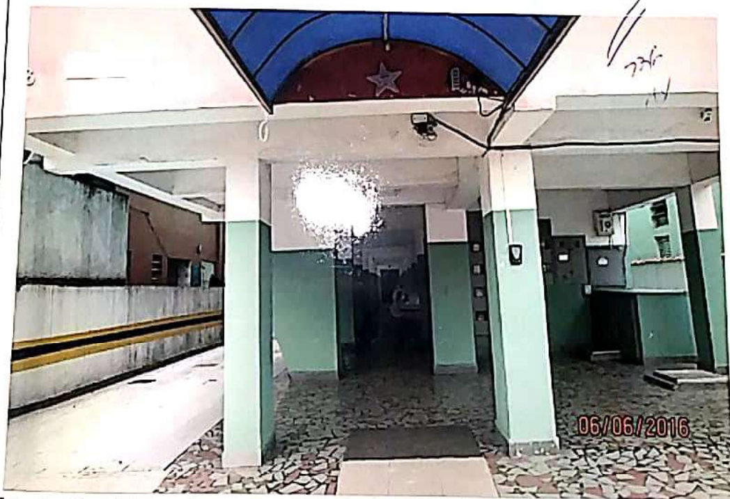
Foto 3 - Idem foto anterior, mostrando ao fundo na parede o quadro de medidores de energia; as fotos 1, 2 e 3 foram obtidas na 1ª diligência agendada, em 06/06/16.
