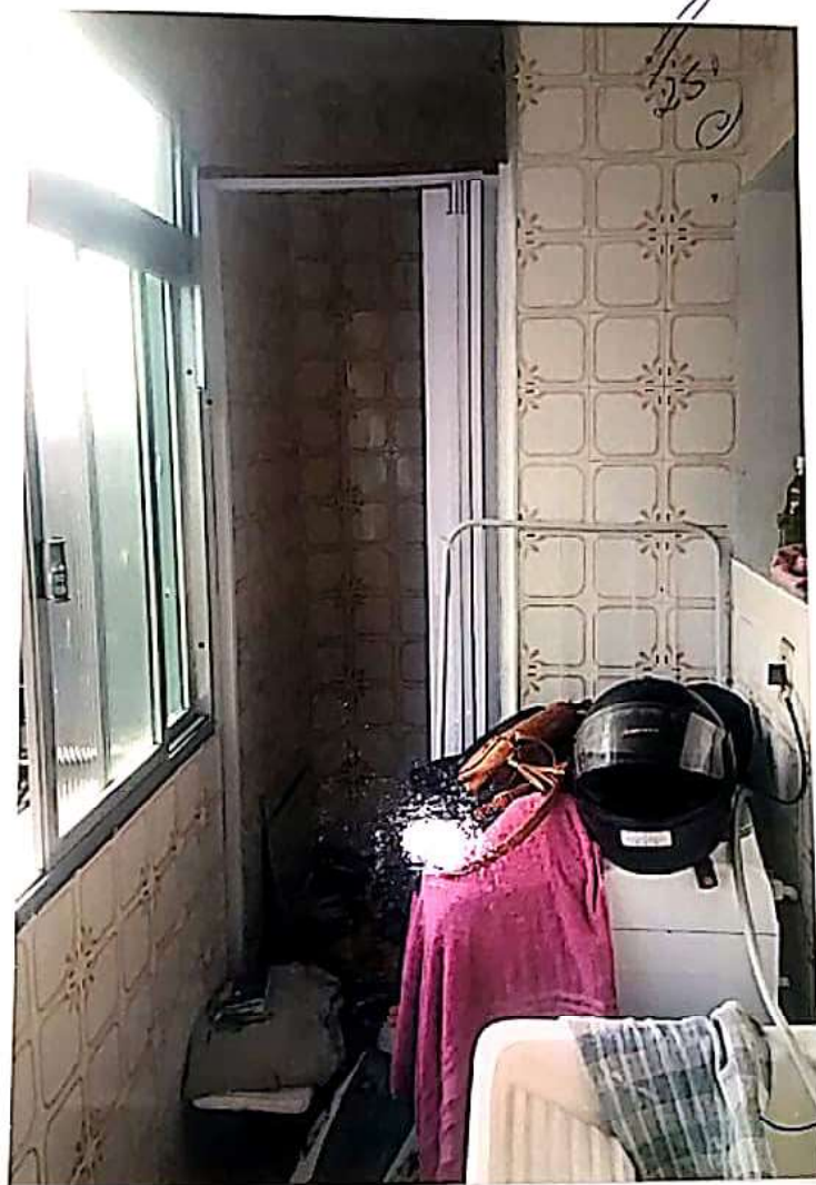
Foto 17 - Área de serviço, com mesmo padrão de revestimento da cozinha e fechamento com janela de alumínio; W.C. externo com porta sanfonada.
