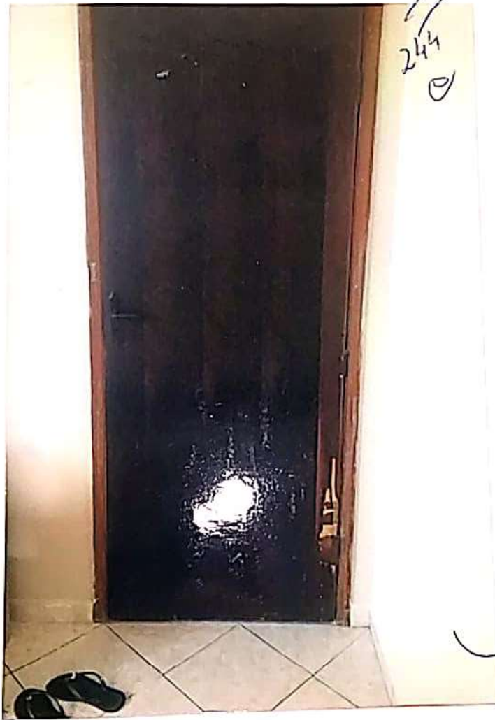
Foto 10 - Porta da sala do apartamento em questão, com danificações na parte inferior.
