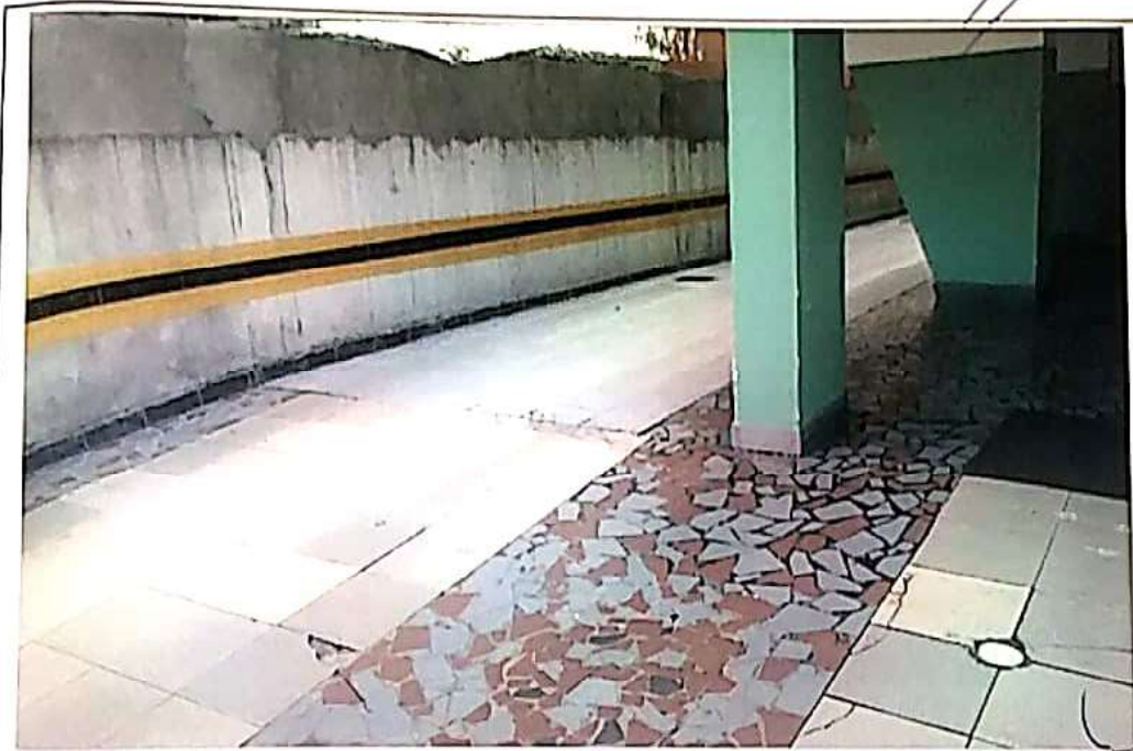
Foto 4 - Idem fotos anteriores, mostra em detalhe o péssimo estado dos pisos cerâmicos da garagem, no térreo.
