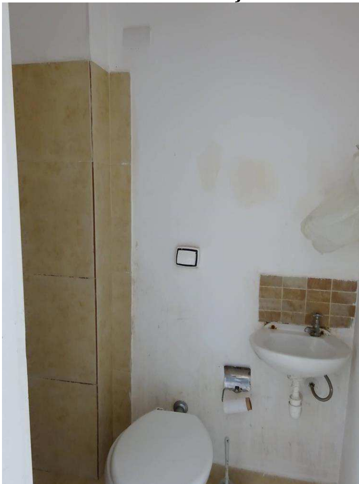
FOTO 7: Vista do banheiro de serviço do imóvel avaliando.
