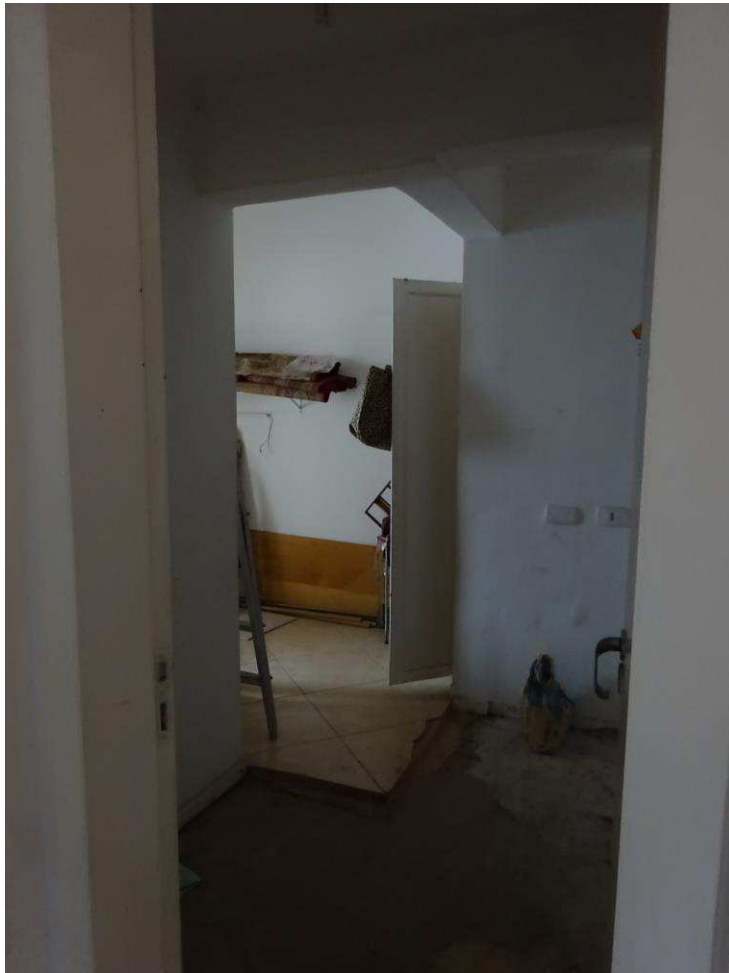
FOTO 10: Vista de outro dormitório do imóvel avaliando.
