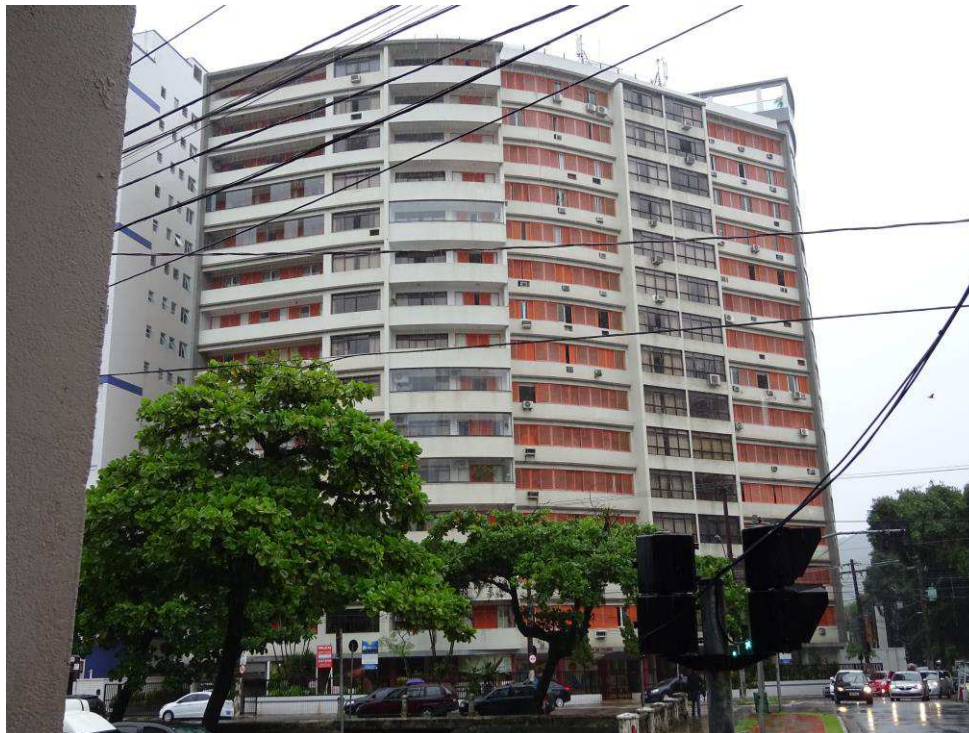
FOTO 1: Vista da fachada frontal do edifício Barão de Penedo.
