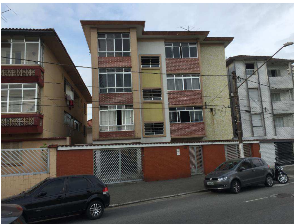
Figura 2: Vista geral do imóvel.
