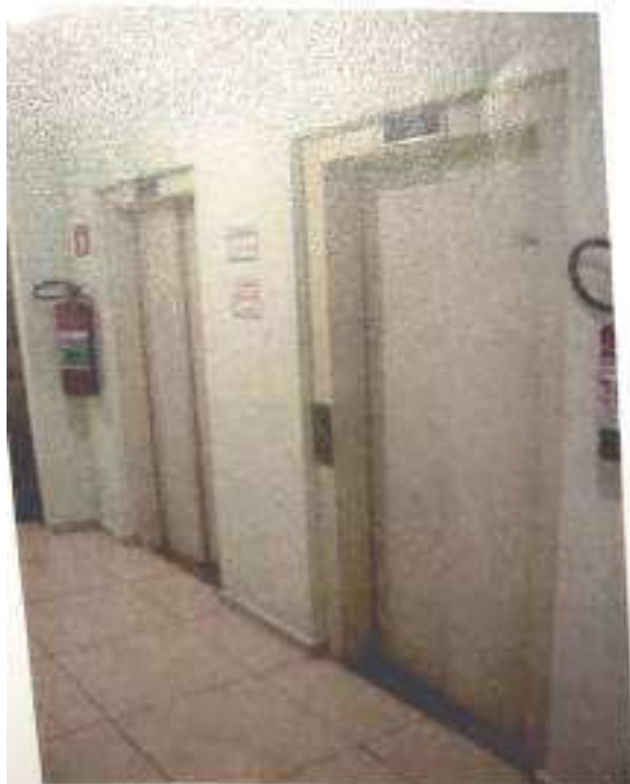
aspecto da área comum do Bloco 09 (hall elevadores).
