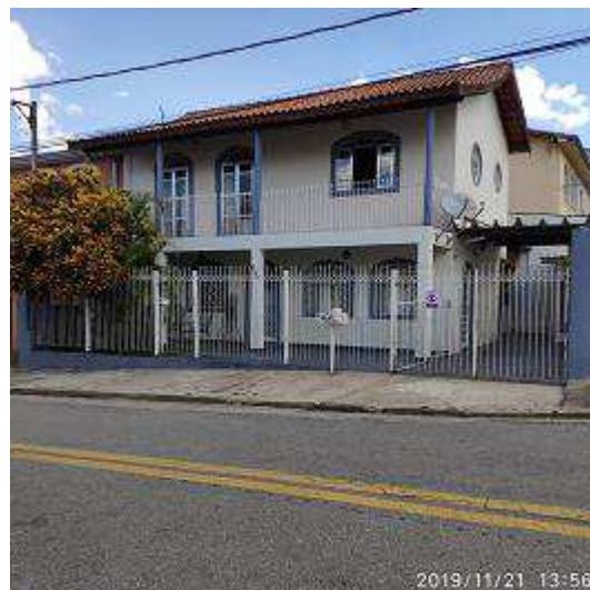
Garagem da unidade 01 é descoberta, encontra-se Na frente do prédio
