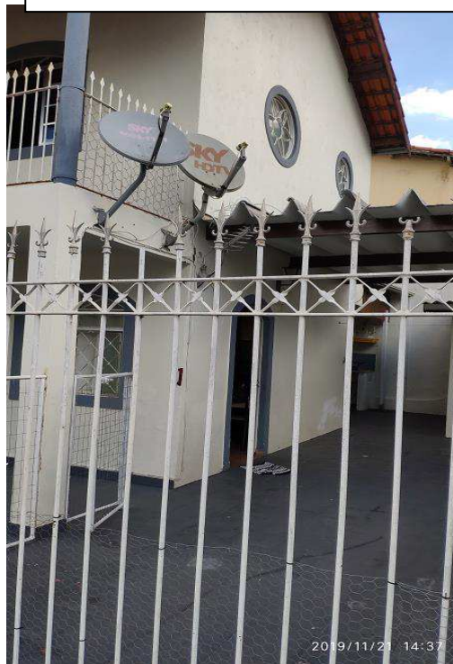
Garagem coberta de utilização da unidade dois
