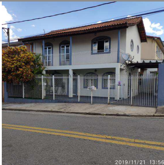
VISTA FRONTAL DO IMÓVEL
