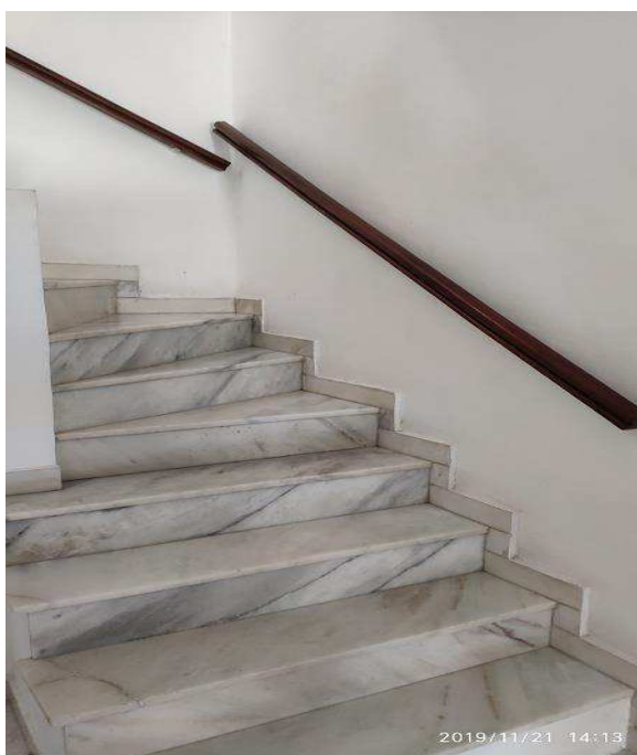
Escada do primeiro imóvel de acesso ao 2º andar
