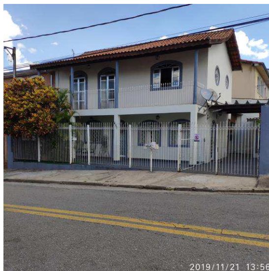
Vista Frontal do imóvel 01
