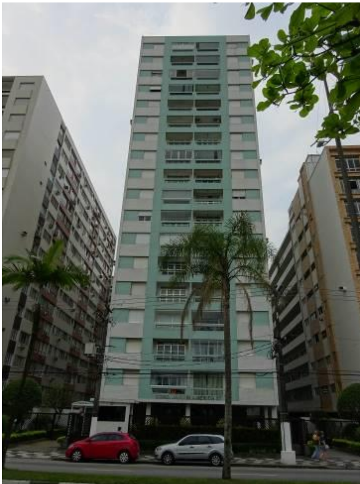
FOTO 1: Vista da fachada frontal do edifício Jardim América.
