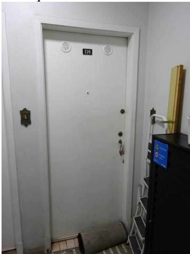
FOTO 3: Vista da porta de entrada do imóvel avaliando.
