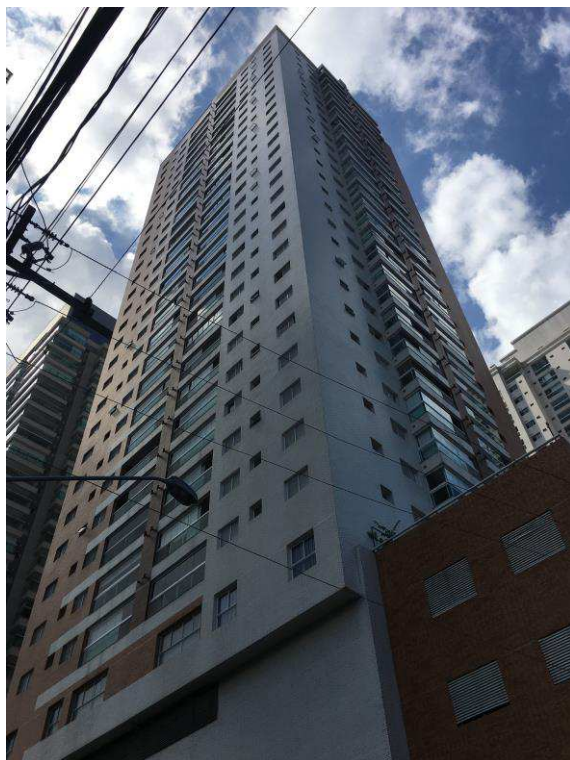
Figura 3: Vista geral do prédio.
