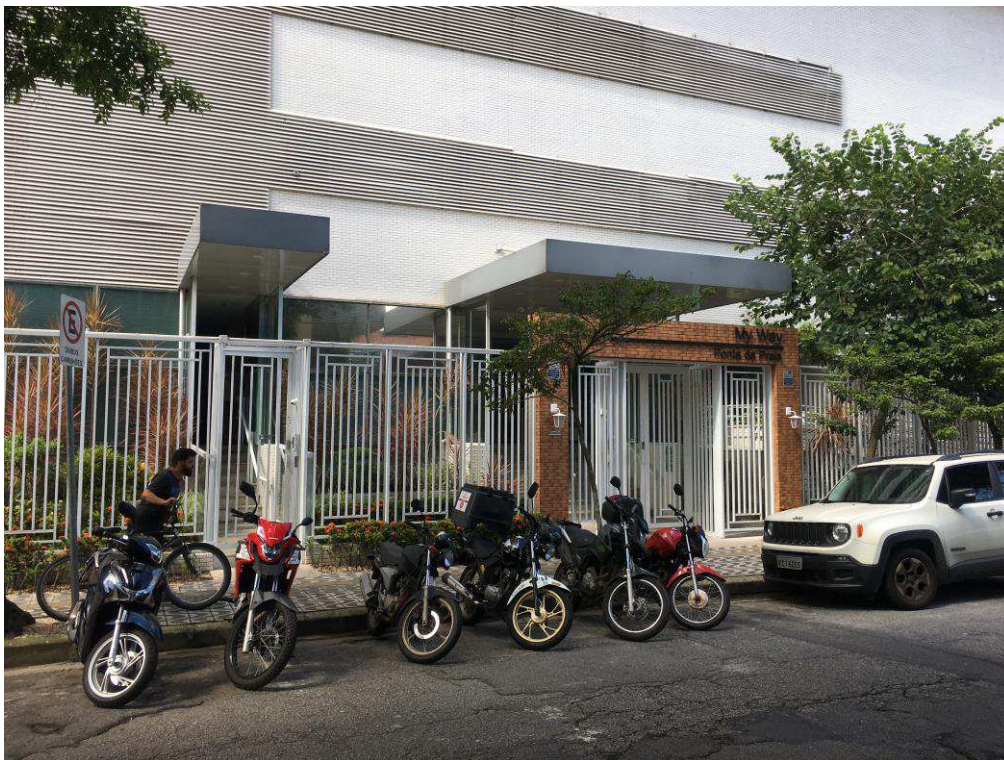
Figura 2: Vista dos acessos principais ao Condomínio Edifício My Way Ponta da Praia.
