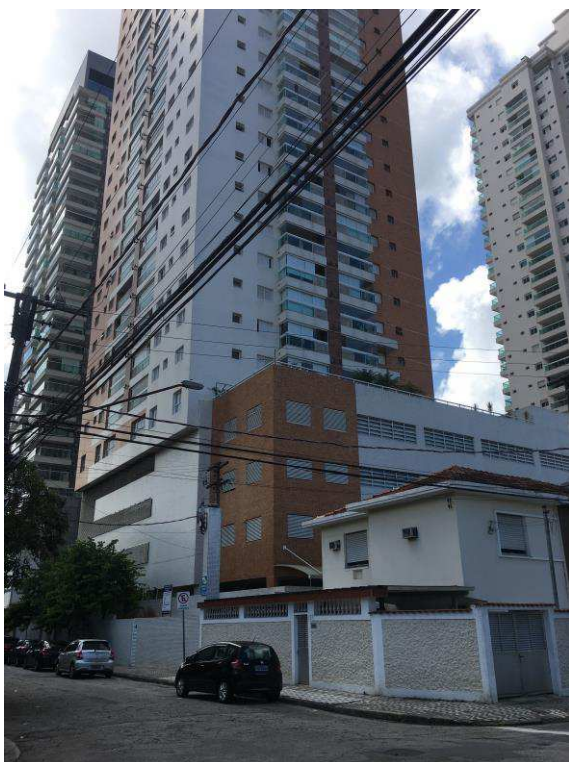
Figura 4: Vista geral do prédio, outro ângulo.
