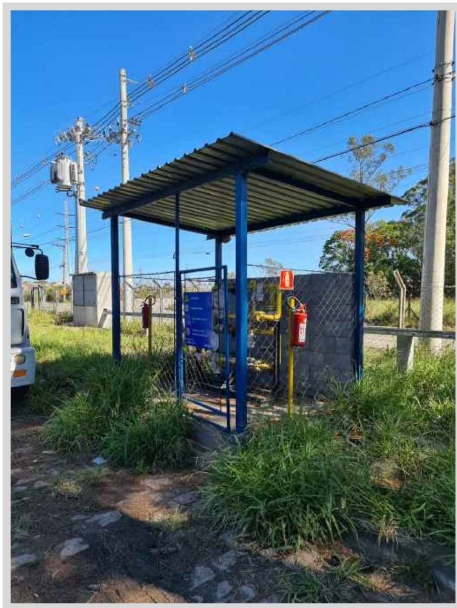
Cabine de gás (9).
