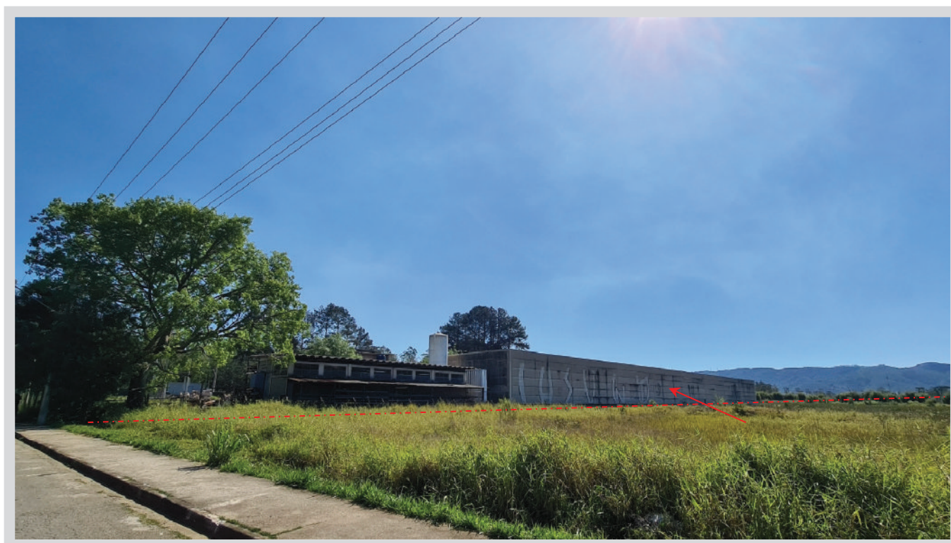
Vista dos fundos do imóvel a partir da Rua Tobias Barreto.
