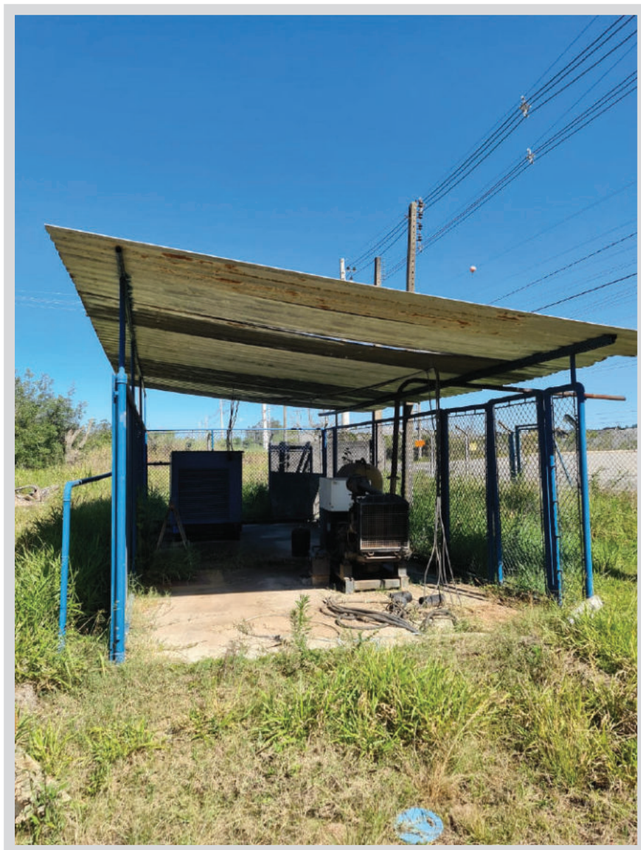
Vista da cabine elétrica.
