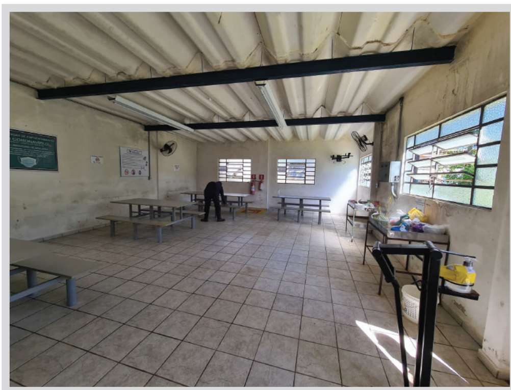
Vista interna do refeitório.
