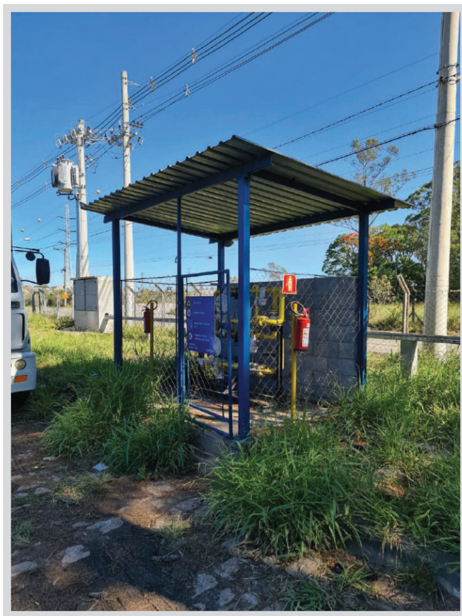
Vista do abrigo de gás.
