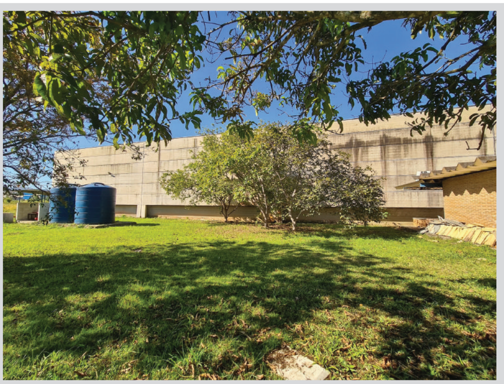
Vistas externas do Galpão (5) localizado o estoque.
