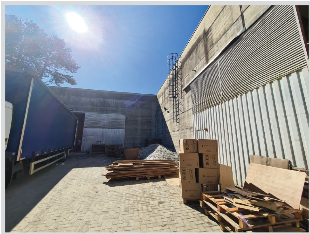
Vista externa do Galpão (estoque).
