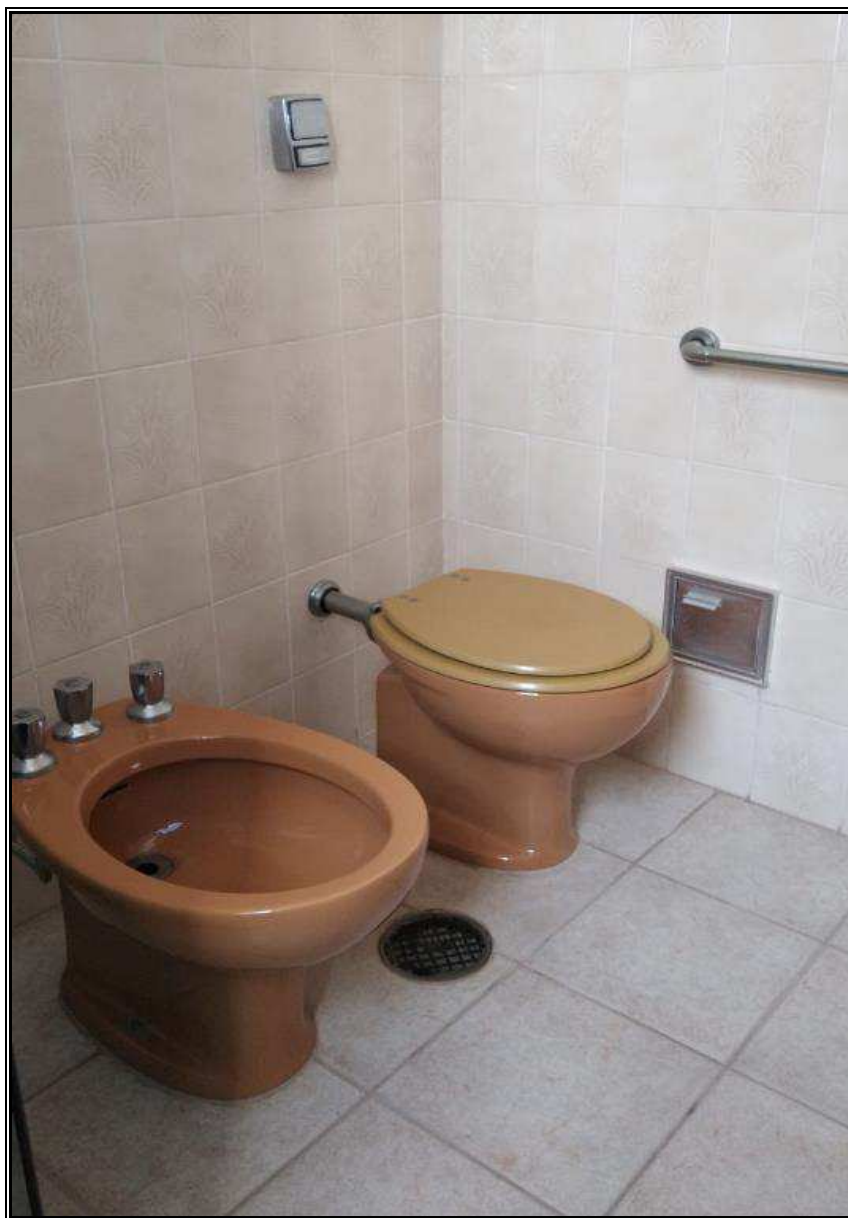
BANHEIRO (DETALHE DO ACABAMENTO)
