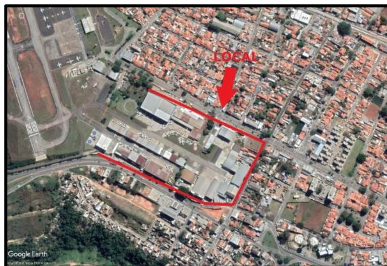
FIGURA 1: Foto aérea capturada através do Google Earth, a seguir, ilustra a localização da vistoria.
