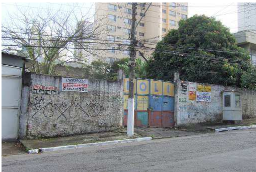
VISTA FRONTAL DO IMÓVEL AVALIANDO
