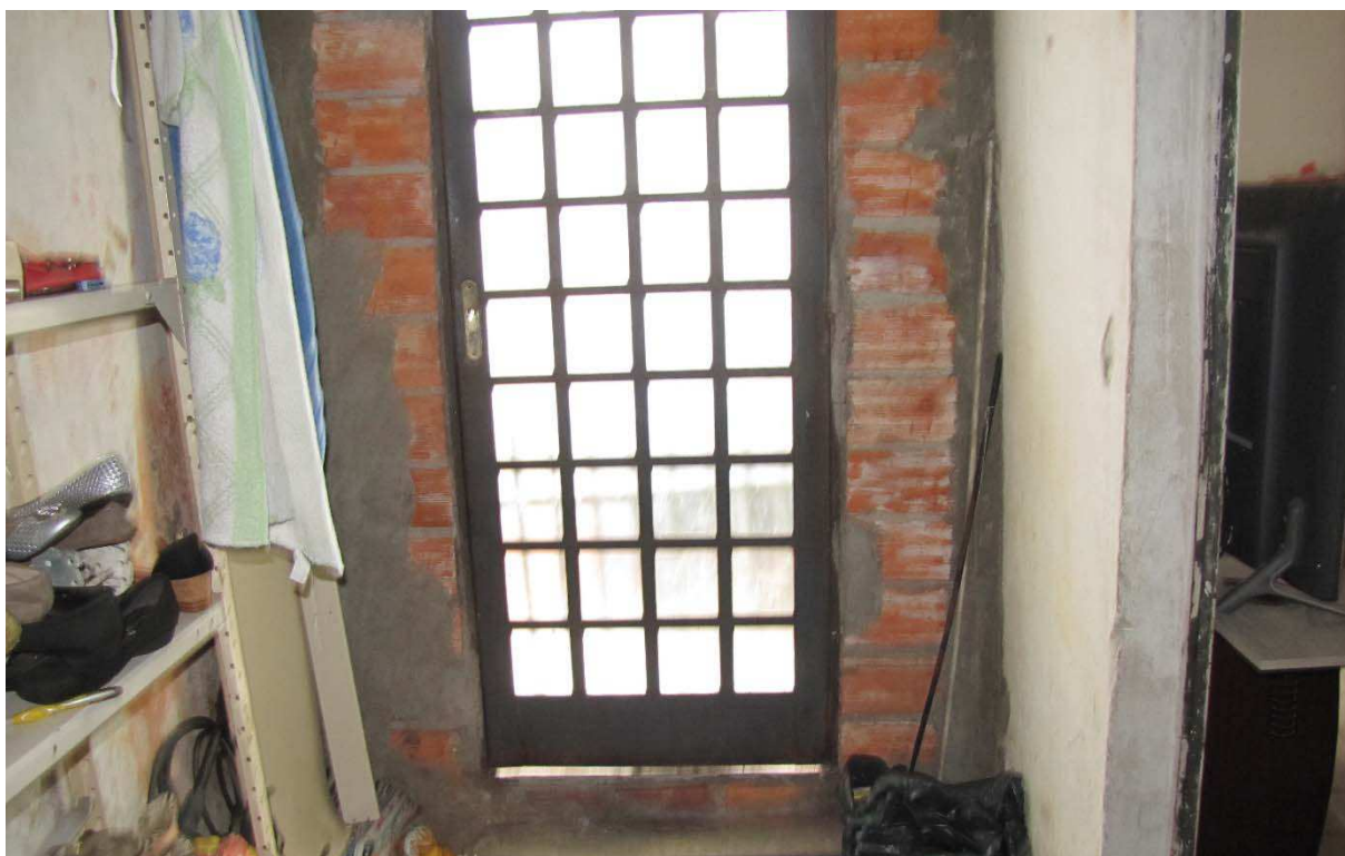
Vista Geral do cômodopor outro ângulo que junta a cozinha ao dormitório
