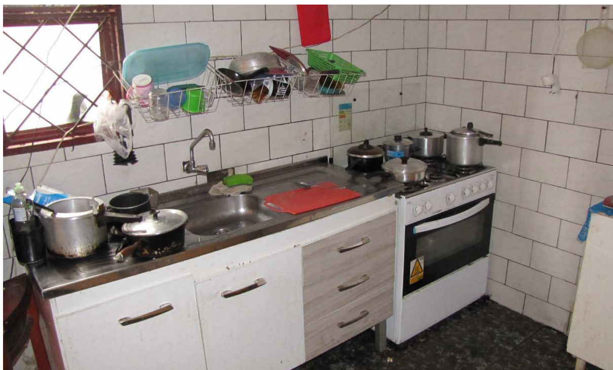
Vista Geral da cozinha por outro ângulo, com detalhe na parede hidráulica revestida com peças cerâmicas.
