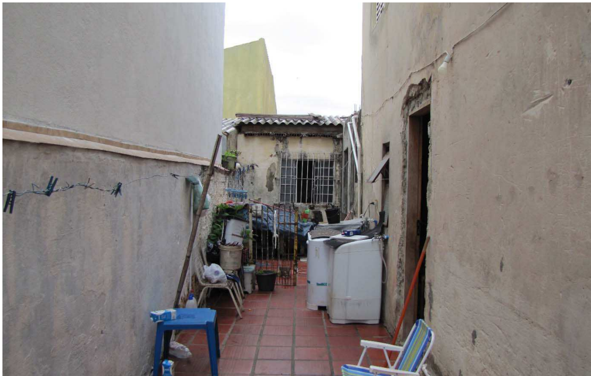
Vista Geral do acesso para a casa dois pela parte externa do imóvel
