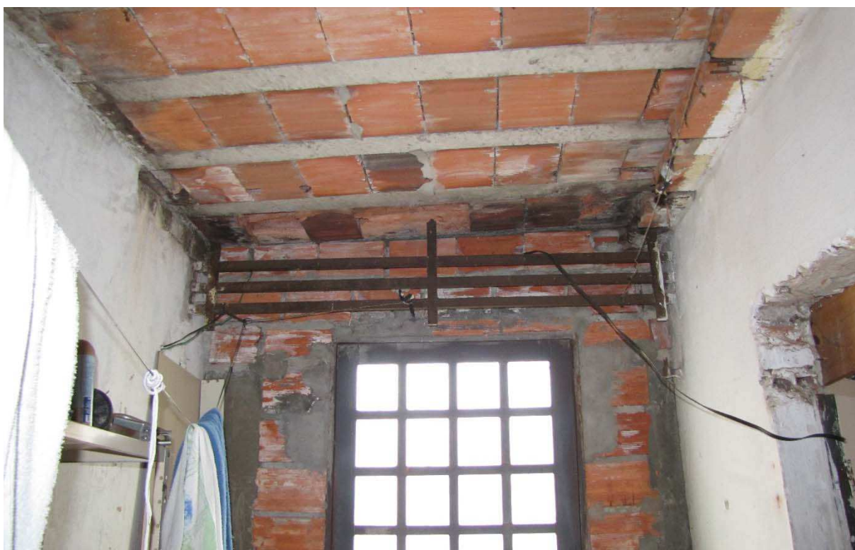
Vista Geral do cômodo que junta a cozinha ao dormitório, com detalhe na parede e laje não acabada.
