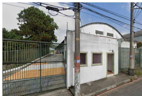
Rua Espírito Santo, 222, Casa Grande
