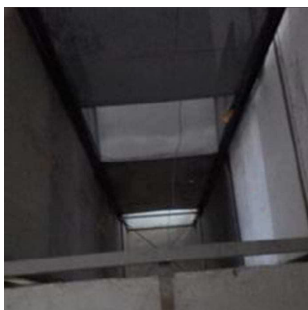
Poço do elevador de carga
