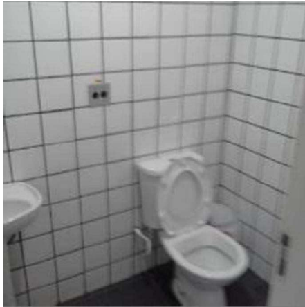
Banheiro masculino - térreo
