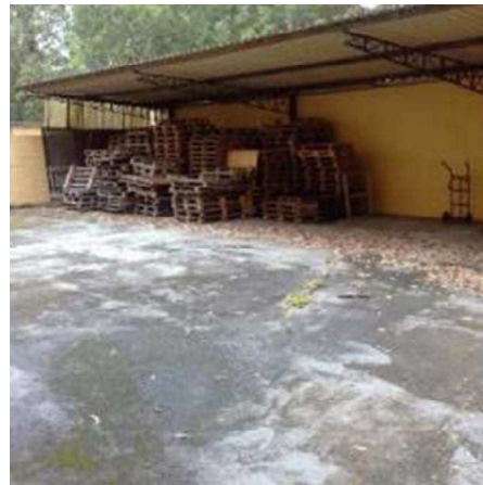
Cobertura junto à divisa de fundos
