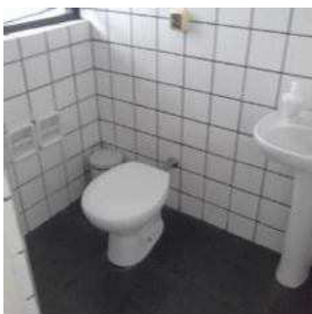
Banheiro feminino - 1º piso
