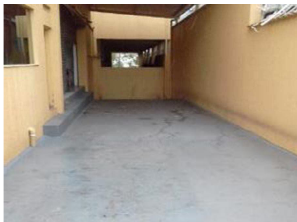
Corredor lateral - entrada de carros
