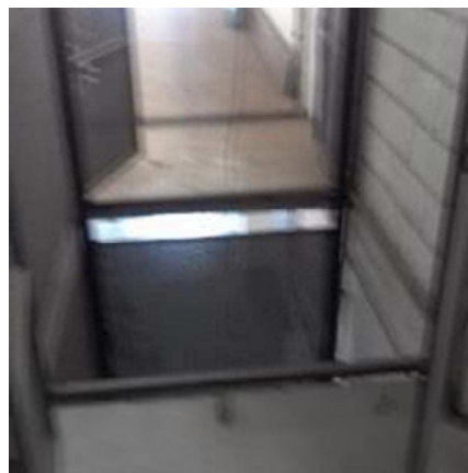
Elevador de carga
