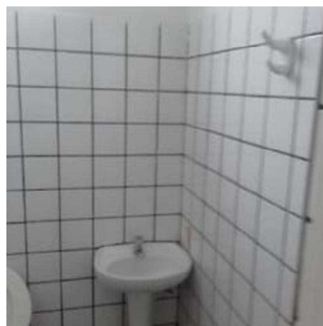
Banheiro feminino 2º piso
