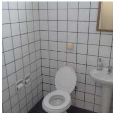
Banheiro masculino 2º piso
