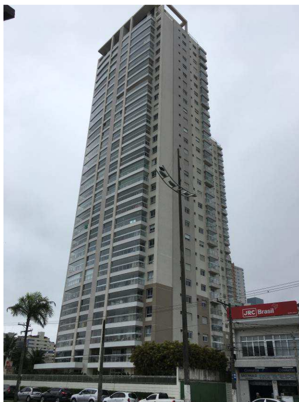
Figura 2: Vista geral do imóvel.
