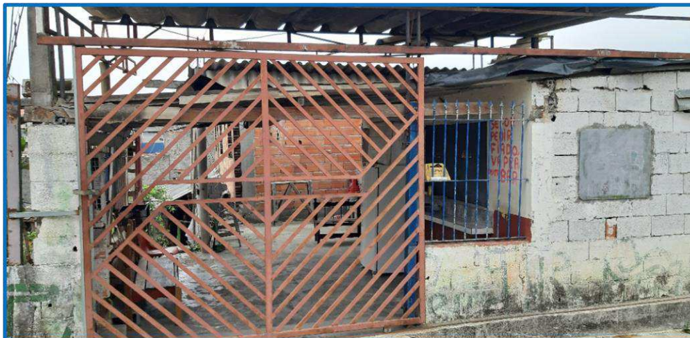
Vista da área frontal da residência - garagem.
