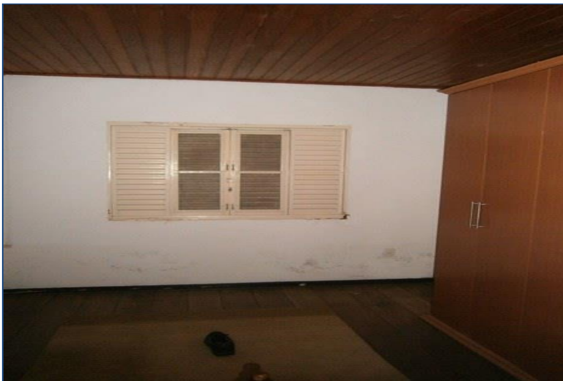
FOTO nº 18 Vista da Suíte de Casal na Casa Térrea Principal.
