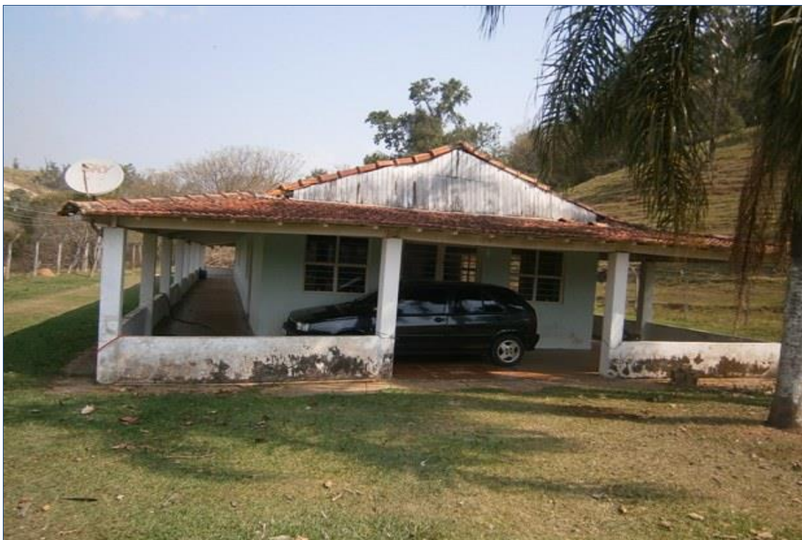
FOTO nº 11 Vista da Casa Térrea Principal.
