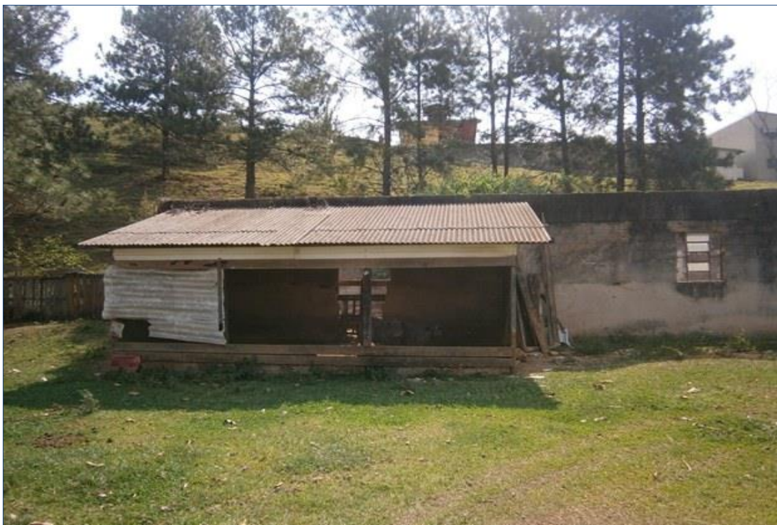
FOTO nº 09 Vista do Abrigo para os Leitões.
