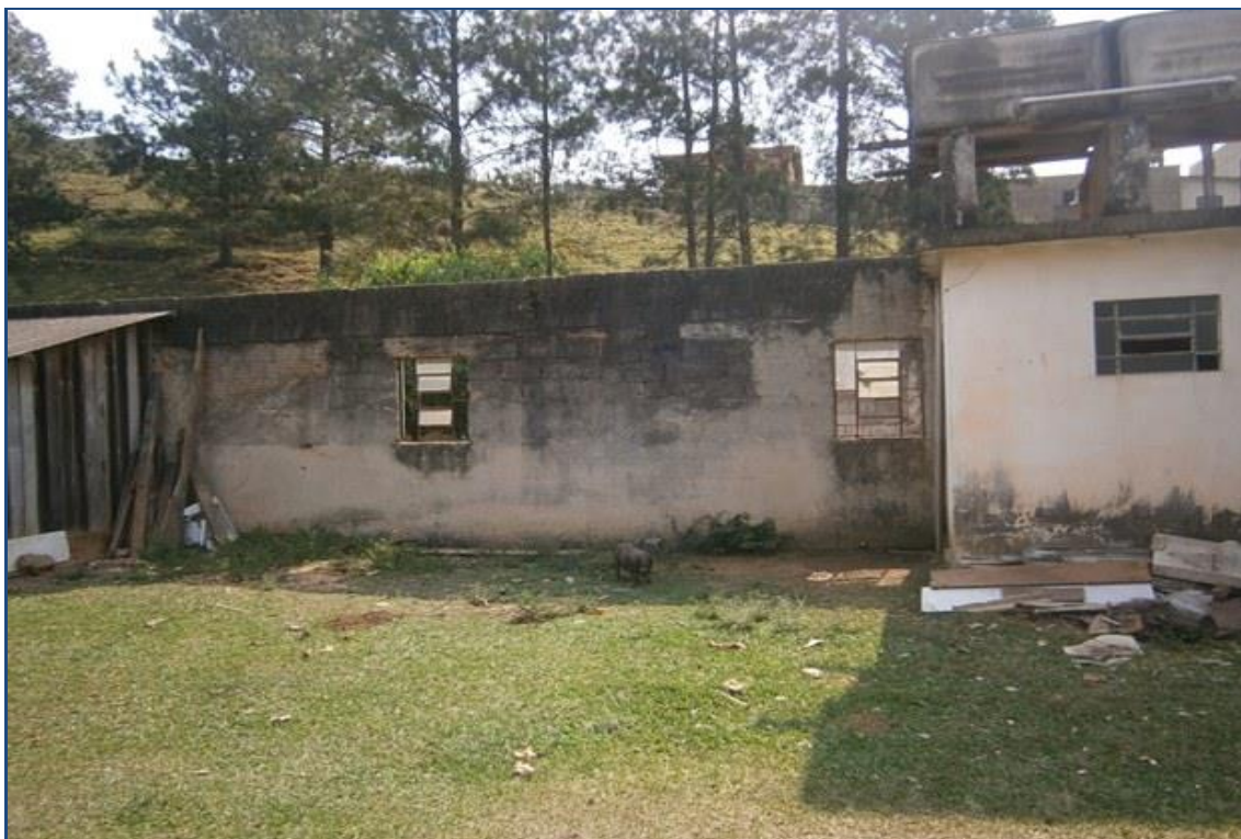
FOTO nº 10 Vista das construções em ruínas.
