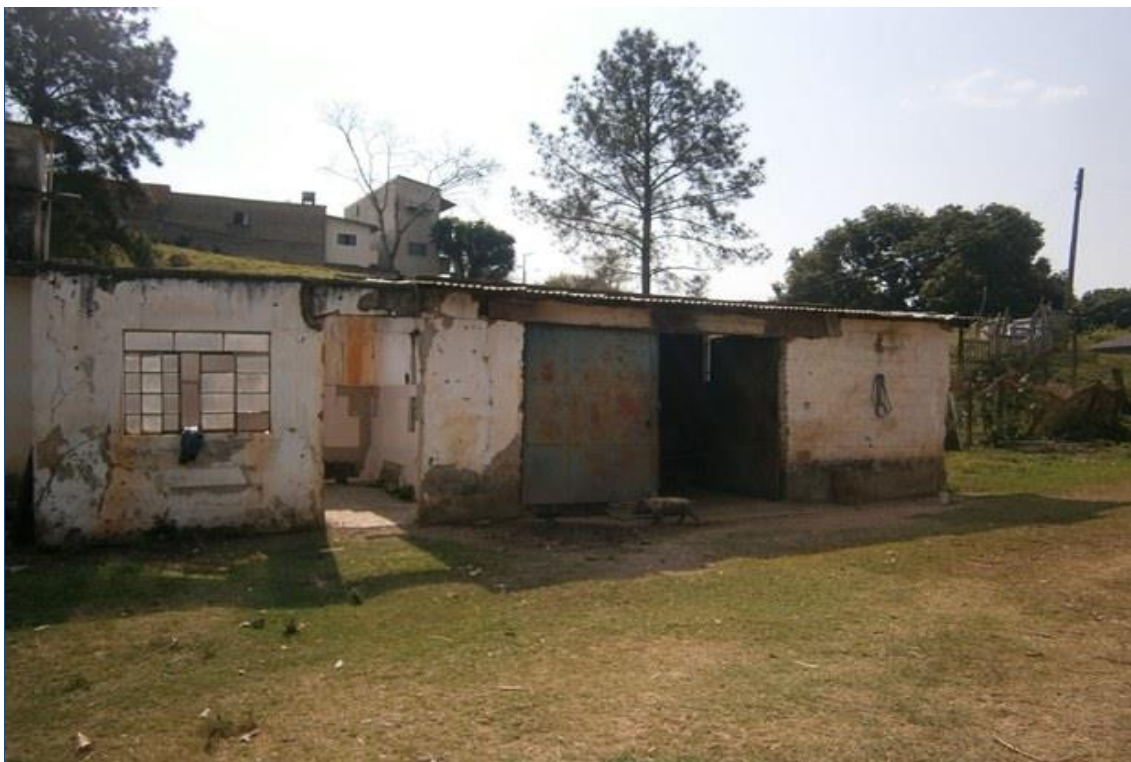
FOTO nº 07 Vista do Abrigo para os Porcos e Galinhas.
