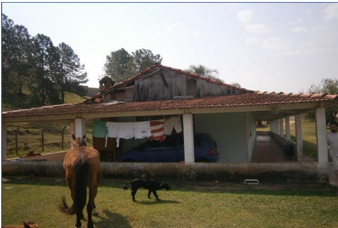
FOTO nº 12 Outra vista da Casa Térrea Principal.
