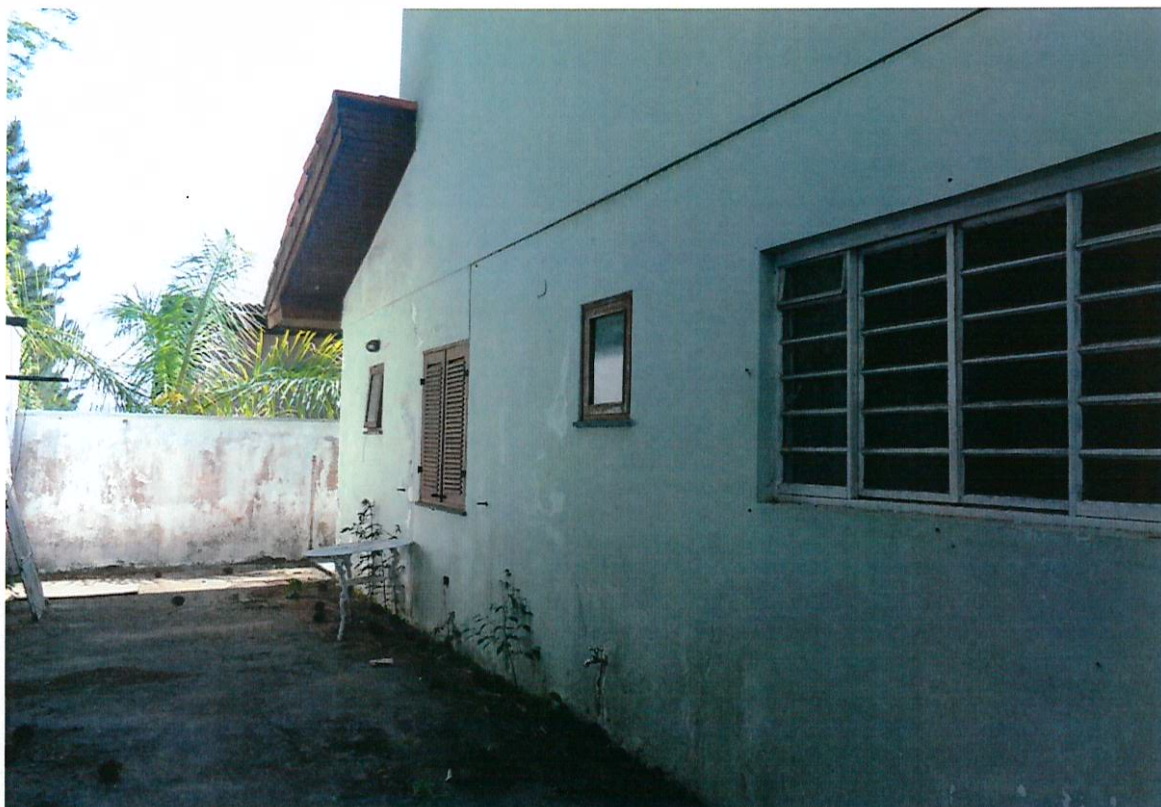
Vista dos área dos fundos do imóvel avaliando.
