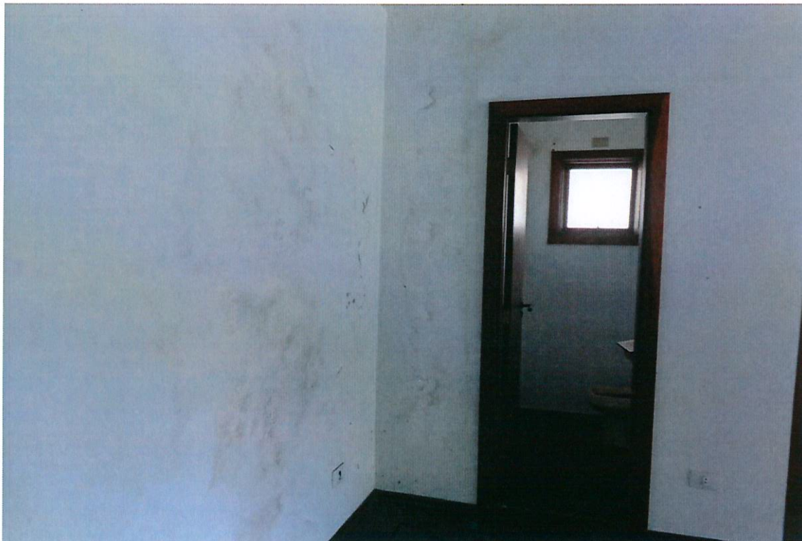
Vista do lavabo localizado ao lado da entrada principal da sala de estar.
