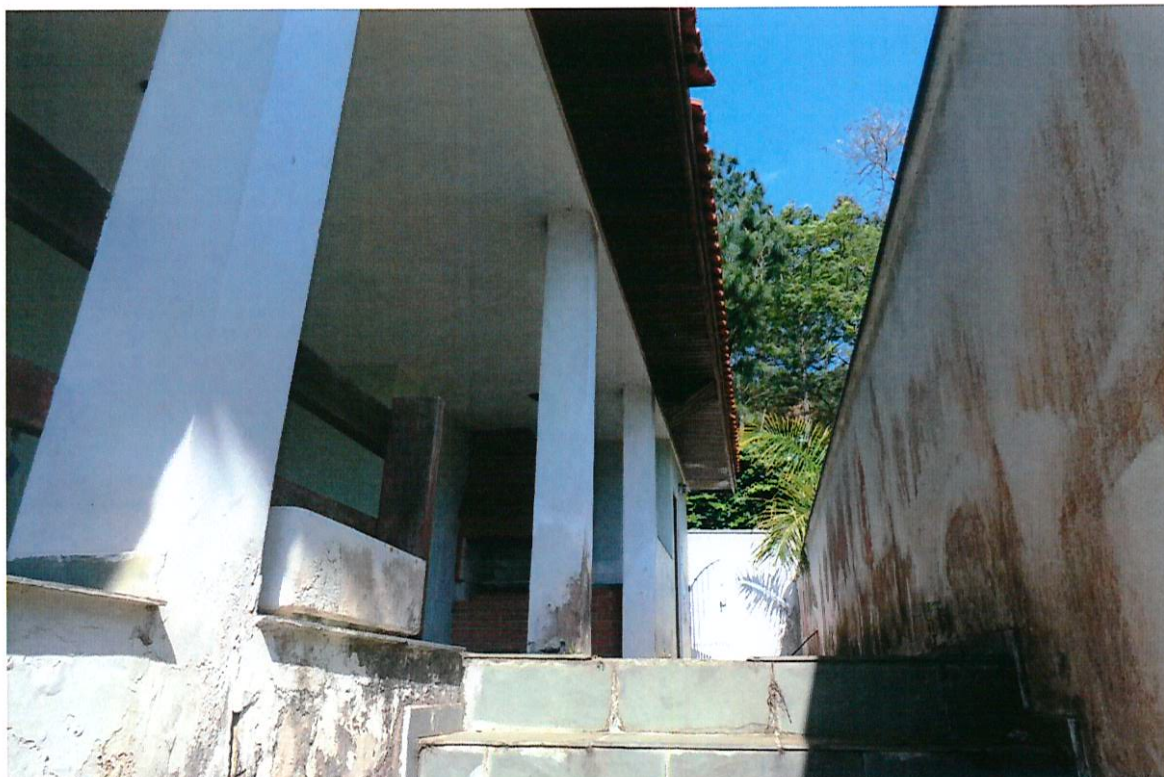
Vista do final da escadaria que dá acesso à área da varanda/churrasqueira.
