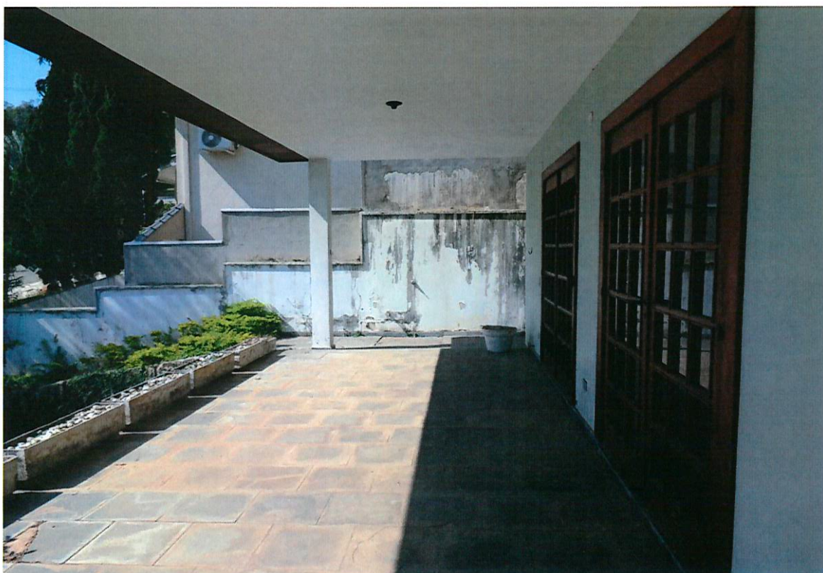
Vista da varanda na frente da casa e das portas de correr da sala de estar.
