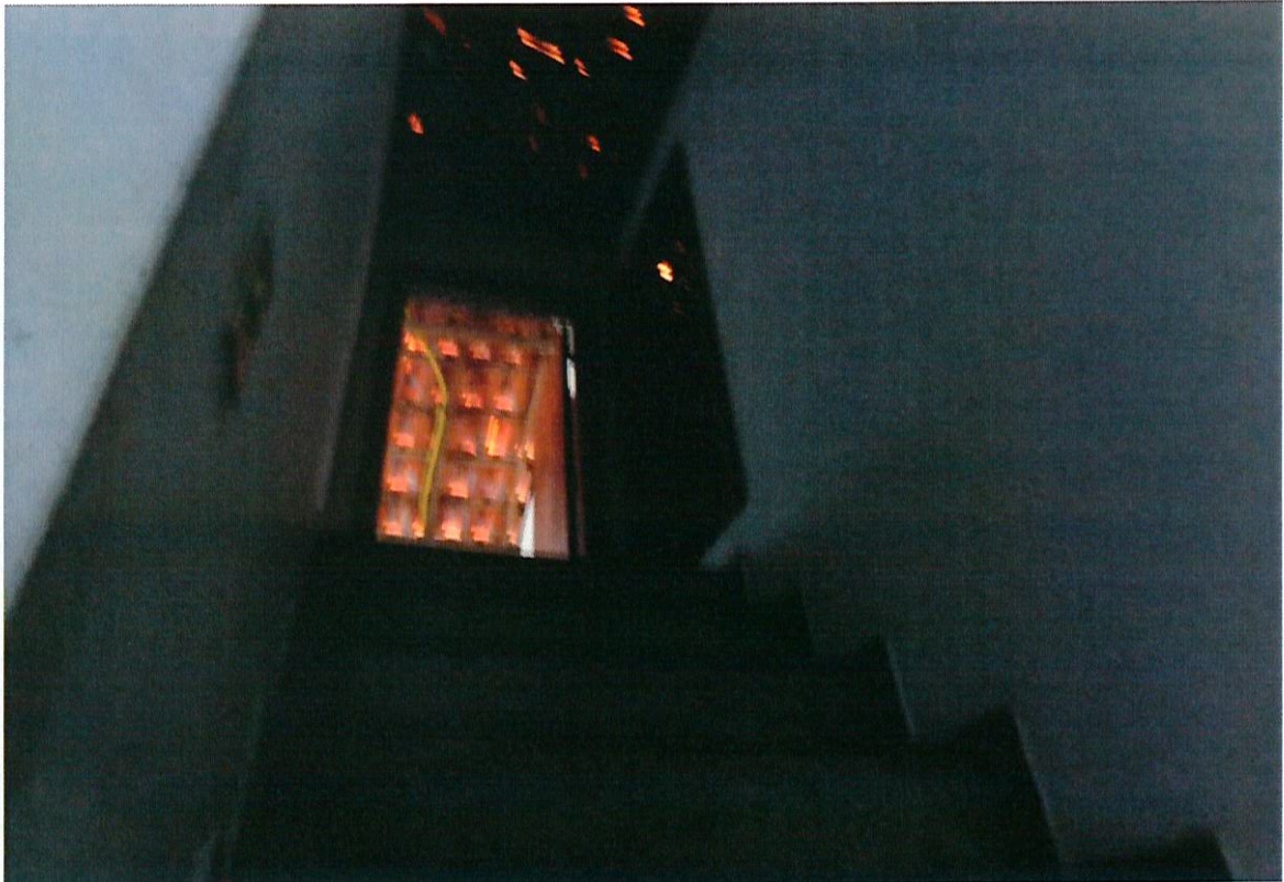
Vista parcial da escadaria do acesso a cobertura/telhado da casa.
