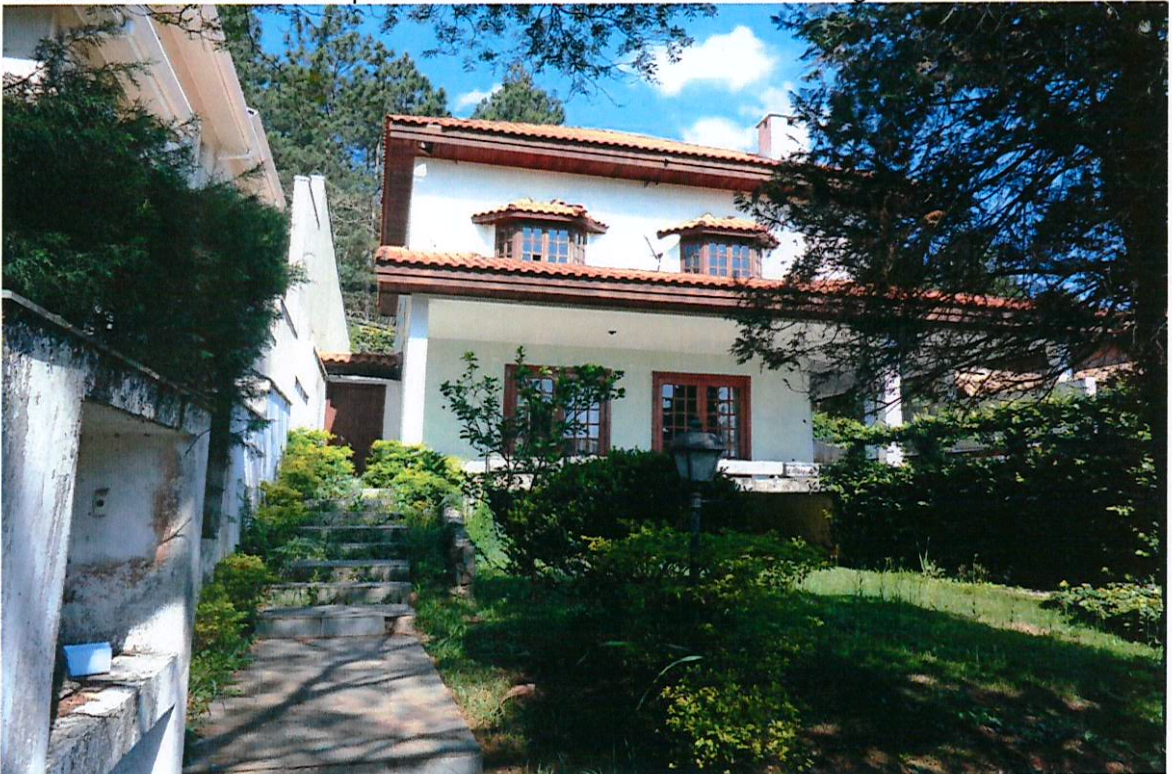
Vista de outro ângulo da fachada, lateral esquerda e parte do jardim da entrada do imóvel.
