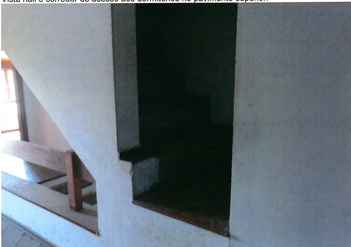
Vista parcial da escadaria de acesso a cobertura/telhado da casa.
