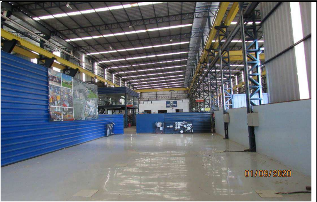
FOTO 15 – Vista geral interna do barracão de serviços.
