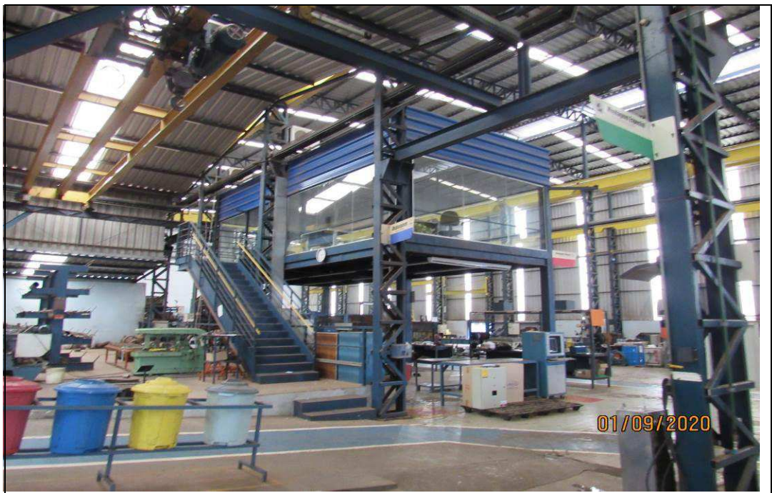
FOTO 08 – Vista geral interna do barracão.
