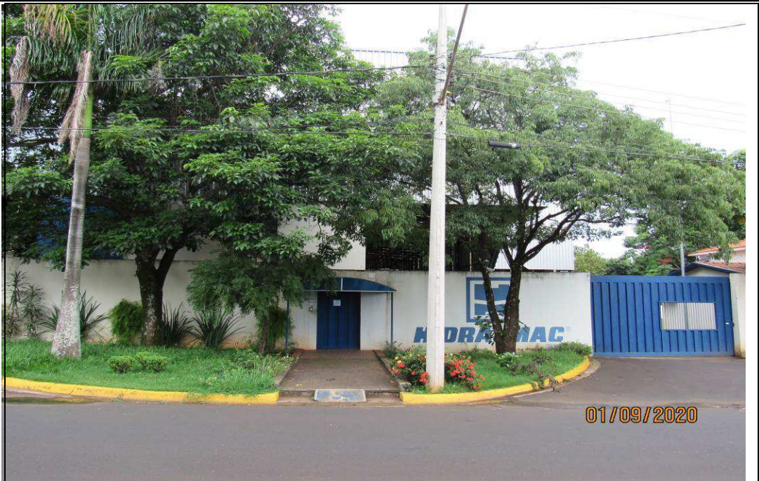
FOTO 03 – Vista geral frontal do barracão.
