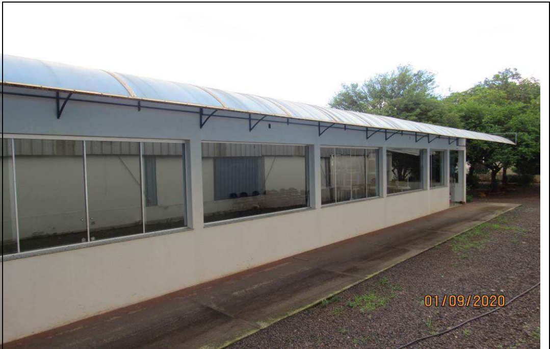
FOTO 20 – Vista geral externa da edificação lateral ao barracão de serviços.
