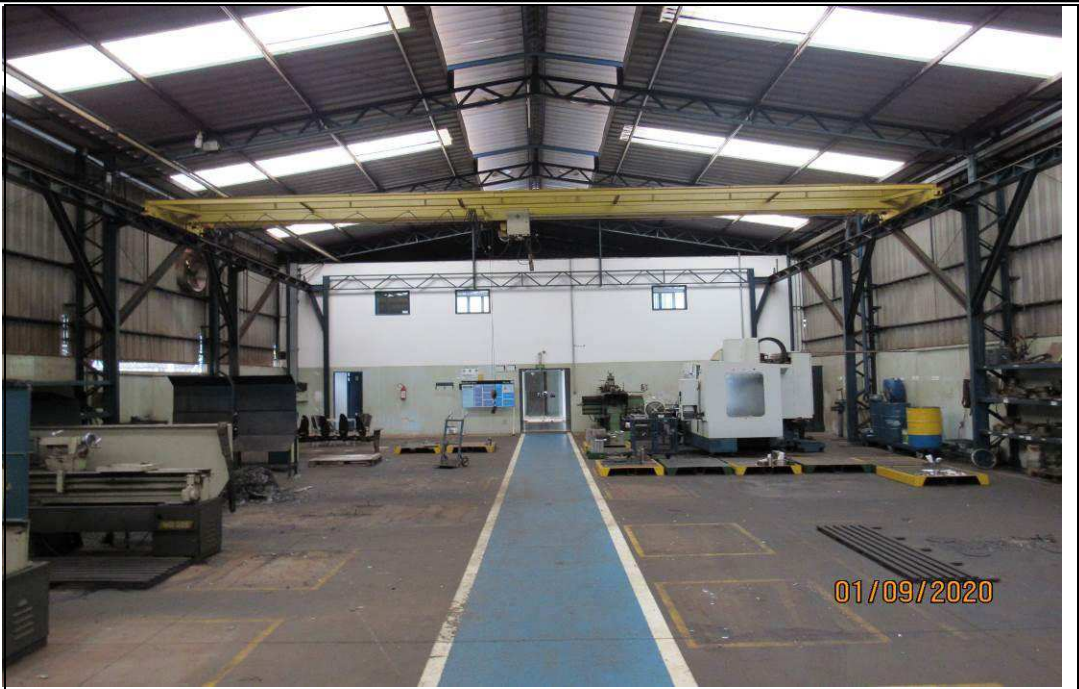
FOTO 13 – Vista geral interna do barracão de serviços.
