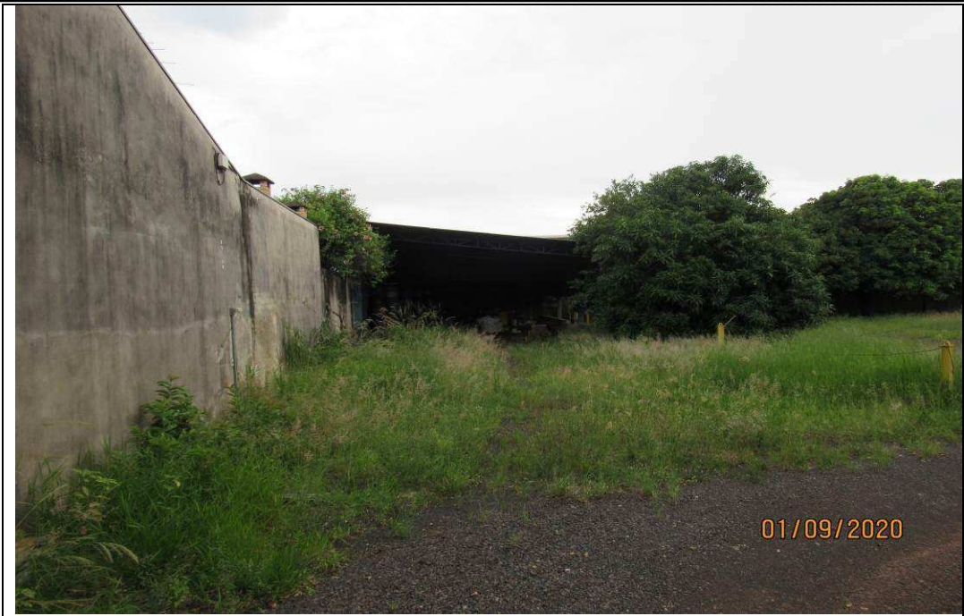
FOTO 27 – Vista geral interna do terreno com a edificação metálica existente.
