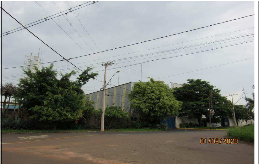
FOTO 04 – Vista geral frontal da fachada do imóvel.
