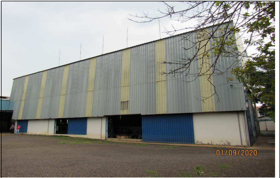
FOTO 12 – Vista geral externa de uma das faces do barracão avaliando.
