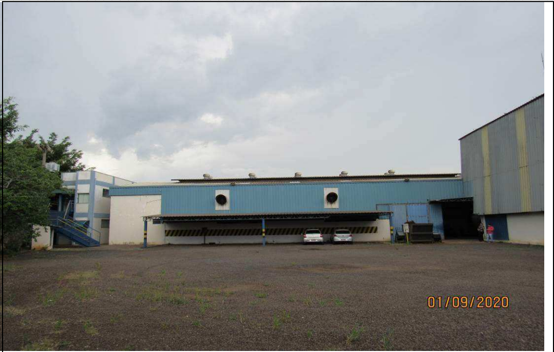
FOTO 11 – Vista geral externa de uma das faces do barracão avaliando.
