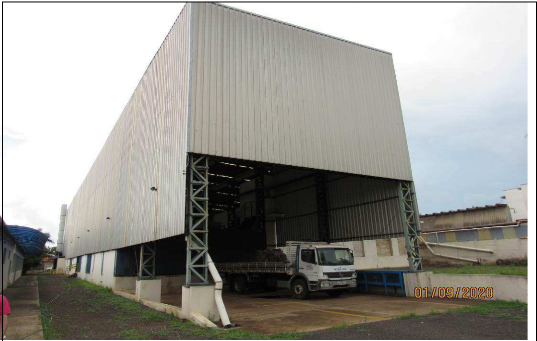
FOTO 14 – Vista geral externa de uma das faces do barracão avaliando.
