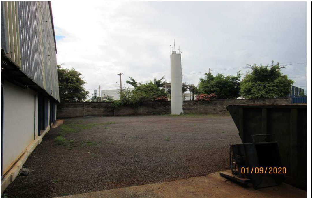
FOTO 10 – Vista geral da área externa do barracão industrial.
