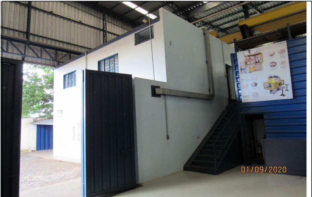
FOTO 16 – Vista geral interna do barracão de serviços.
