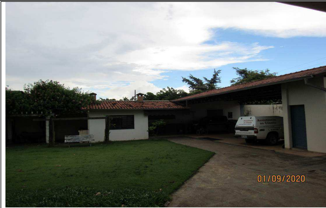
FOTO 24 – Vista geral externa das edificações descritas acima.
