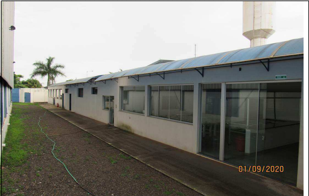
FOTO 19 – Vista geral externa da edificação lateral ao barracão de serviços.
