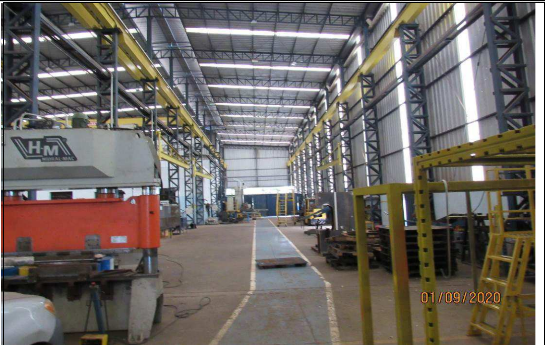
FOTO 09 – Vista geral interna do barracão.
