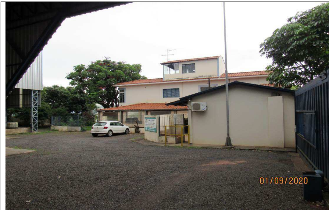
FOTO 25 – Vista geral externa das edificações descritas acima.
