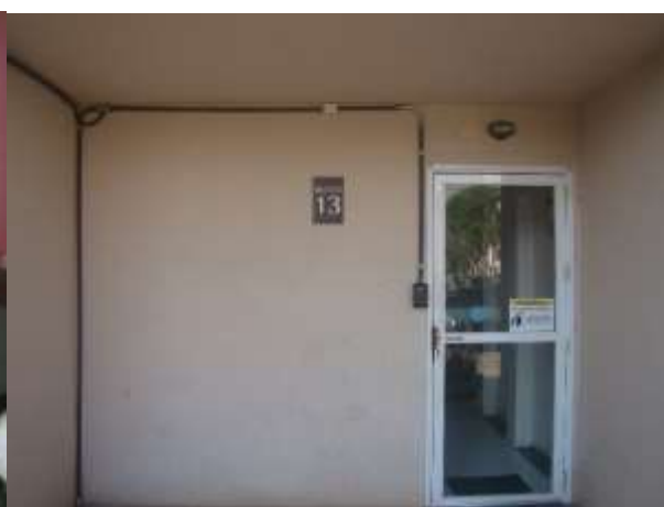
Fotografia 06: Entrada do bloco
