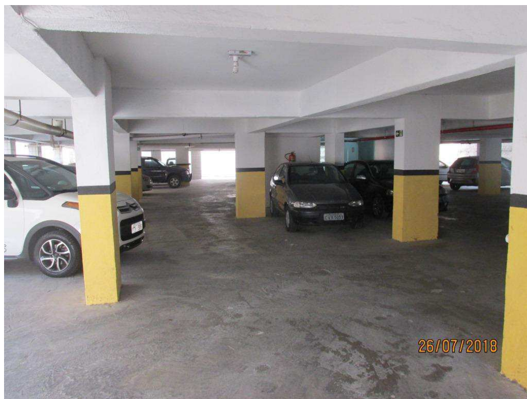
Foto 6 - Vagas de garagem no subsolo
