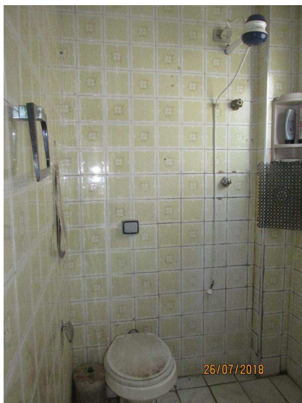
Foto 20 – Banheiro da suíte
