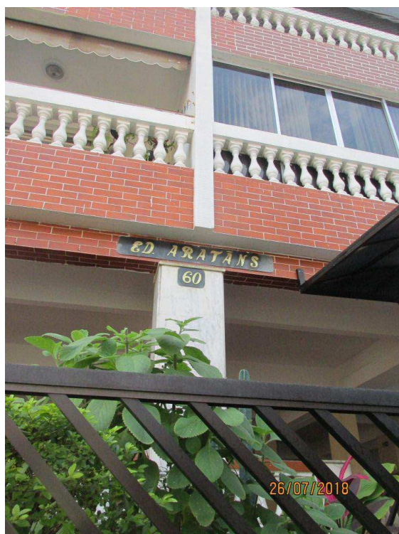
Foto 2 - Detalhe da fachada
