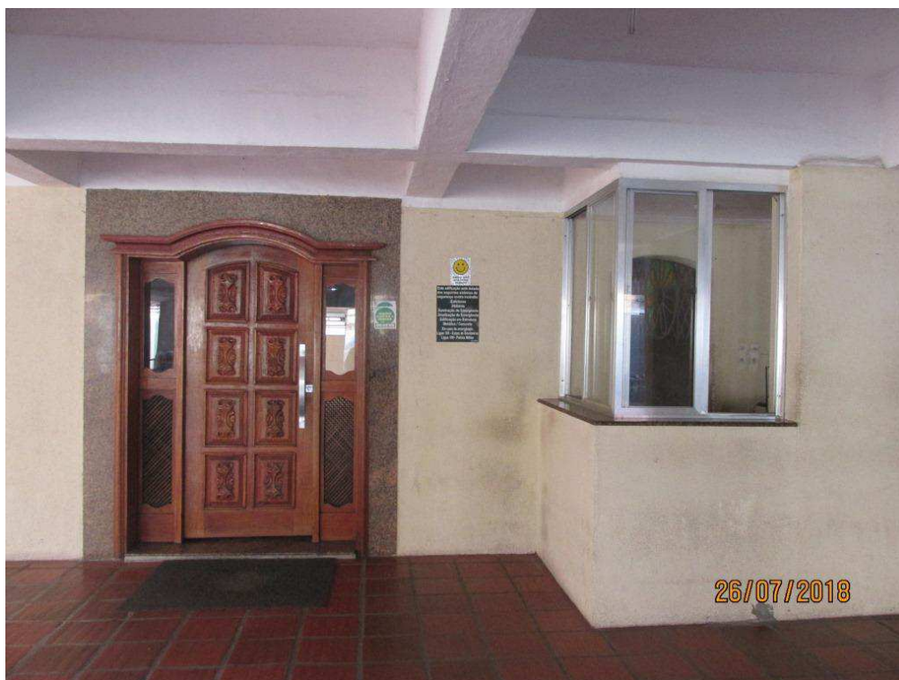
Foto 3 - Entrada social do Bloco "A" no térreo e portaria
