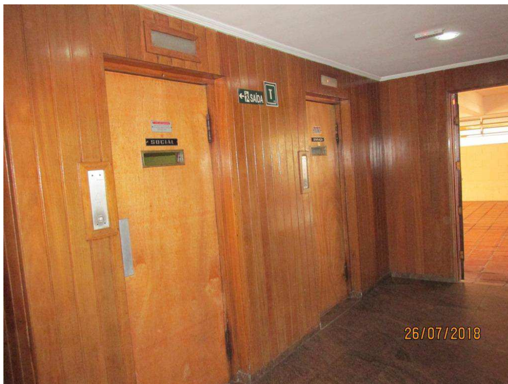
Foto 9 - Hall de elevadores no térreo
