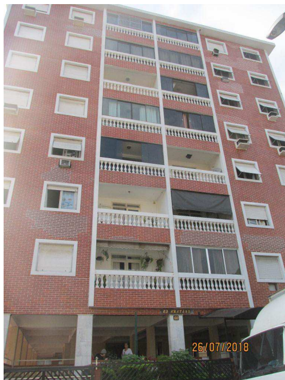
Foto 1 - Fachada do Edifício ARATANS
