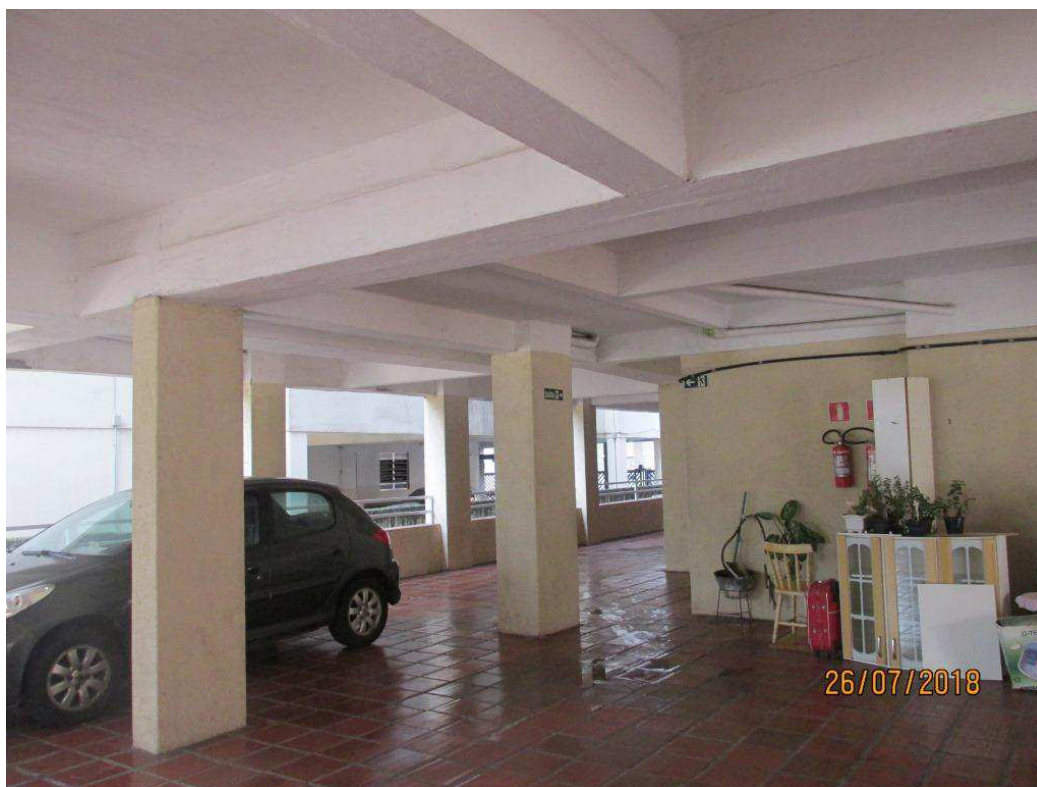
Foto 5 - Outra vista da garagem no pavimento térreo
