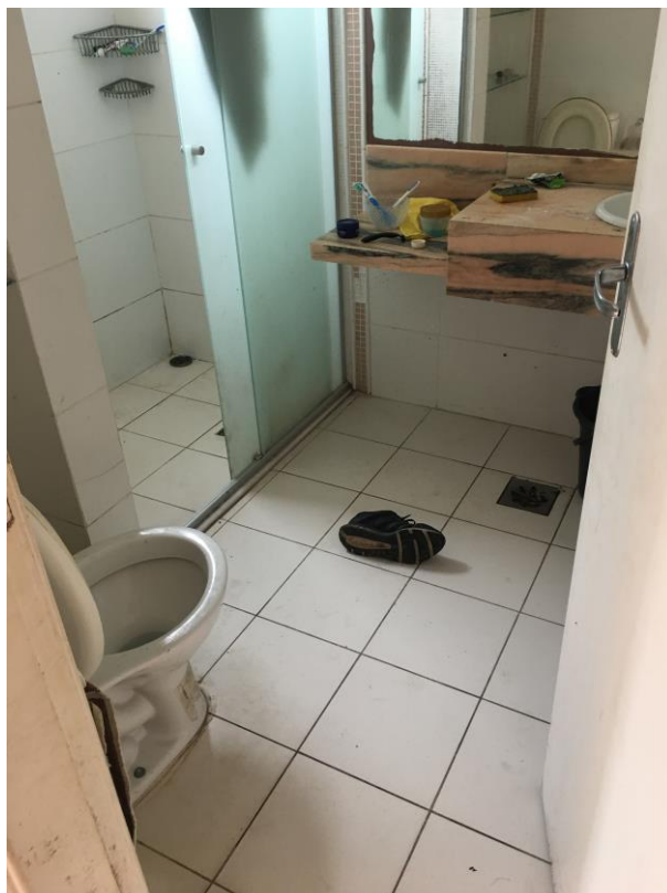
Figura 17: Banheiro do andar superior, nos fundos.
