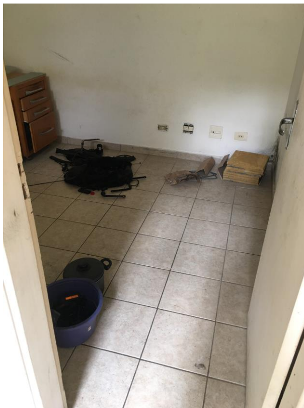
Figura 15: Quarto de serviços.
