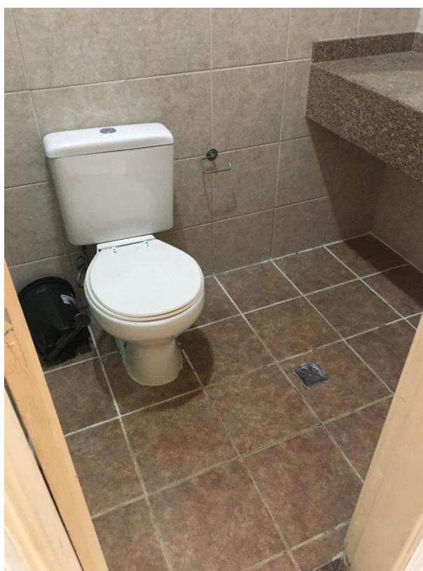
Figura 14: Banheiro de serviço.
