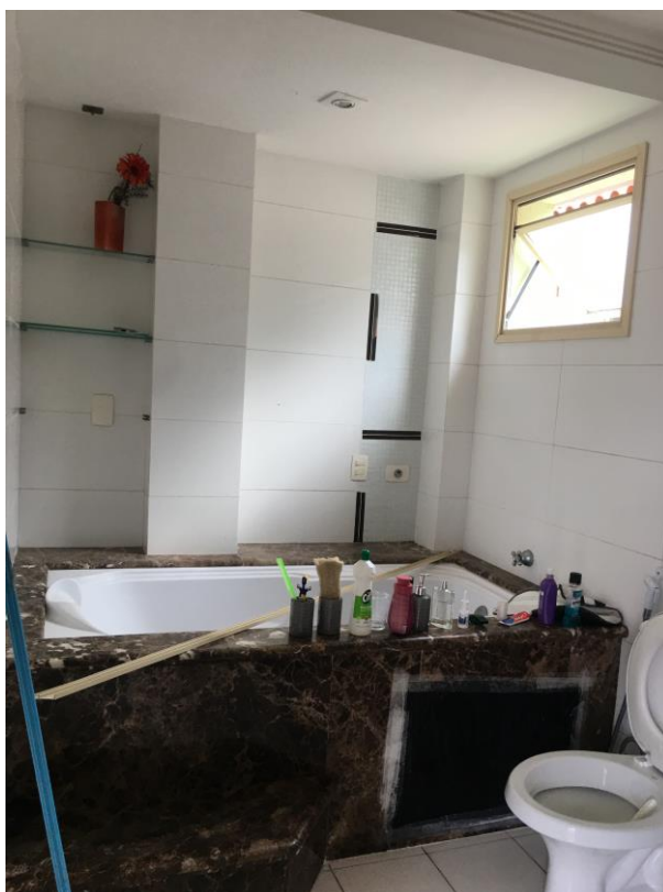
Figura 22: Banheiro da suíte.
