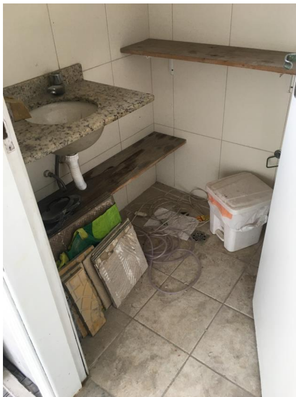
Figura 11: Banheiro da área de lazer sob outro ângulo.
