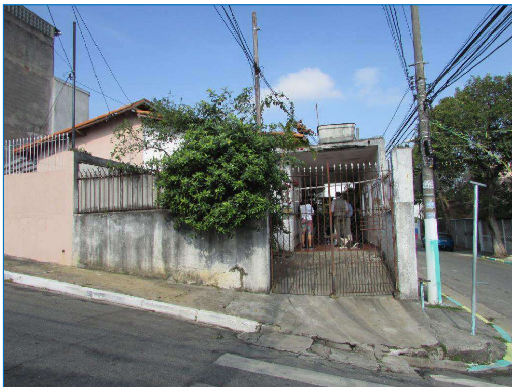
FOTO 05 – FACHADA DO IMÓVEL AVALIANDO, EM PROJEÇÃO PARA A RUA JOSÉ GAÍBA, Nº 272.
