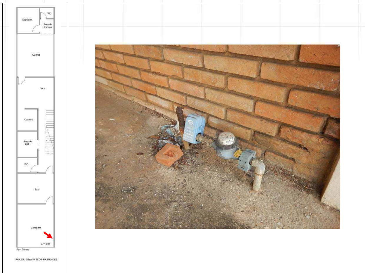
DETALHE DO CAVALETE DE ÁGUA LACRADO PELO SEMAE.
