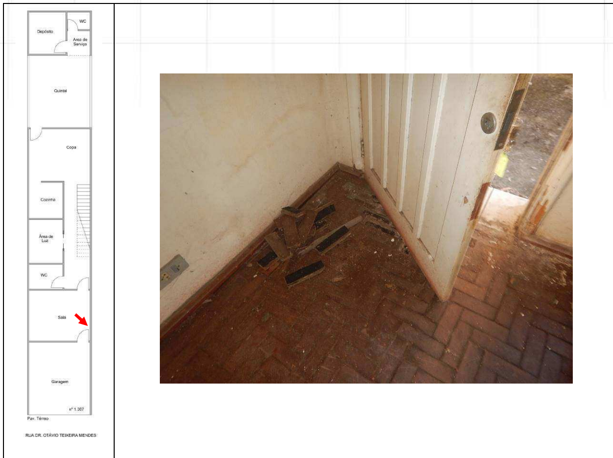
DETALHES DE DANOS NO PISO DA SALA.
