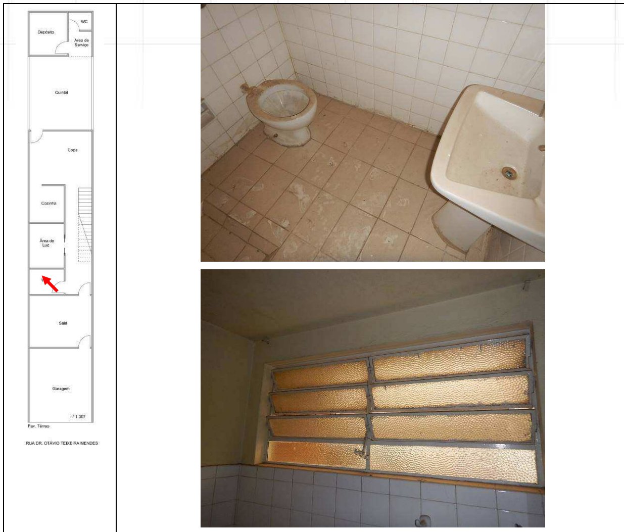
DETALHES DO BANHEIRO.
