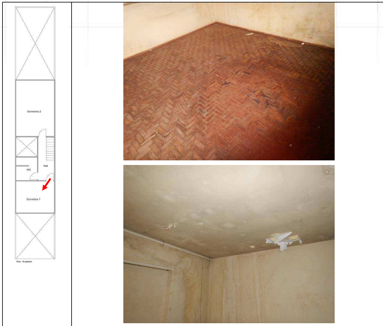
DETALHE DO PISO DANIFICADO E TETO COM MANCHAS DE UMIDADE E INFILTRAÇÃO.
