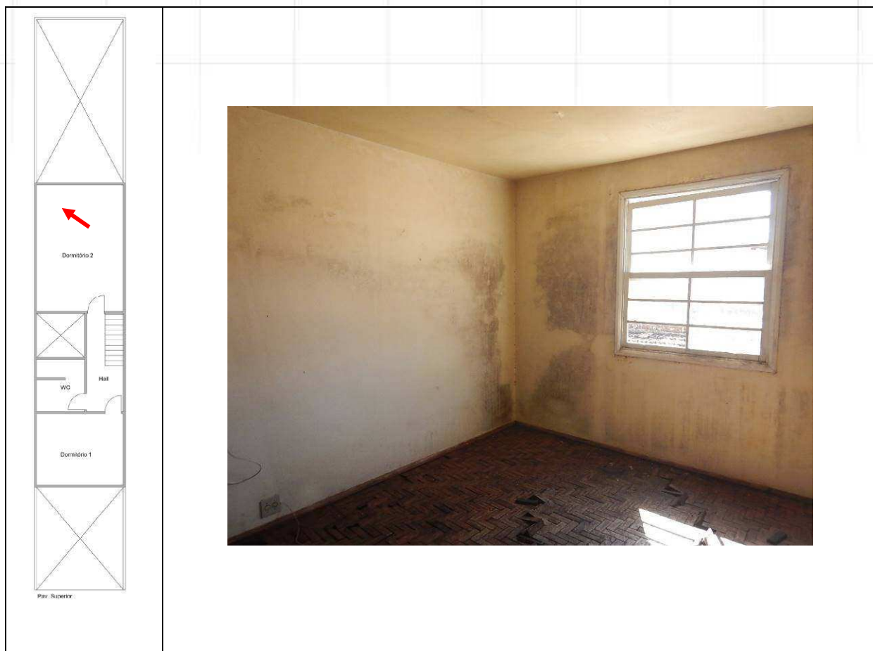
DETALHES DE MANCHAS DE UMIDADE NAS PAREDES DO DORMITÓRIO 2.
