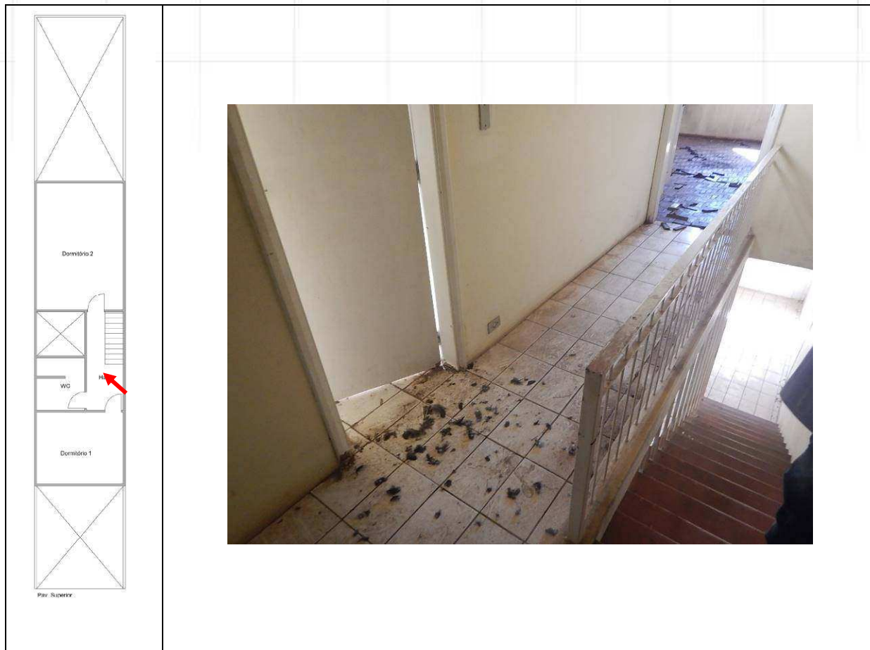
HALL DE CIRCULAÇÃO DO PAVIMENTO SUPERIOR.
