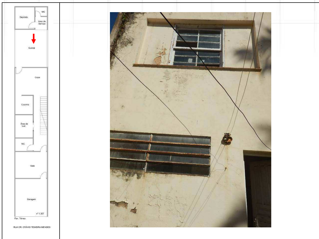
VISTA DA FACHADA DOS FUNDOS DO IMÓVEL.
