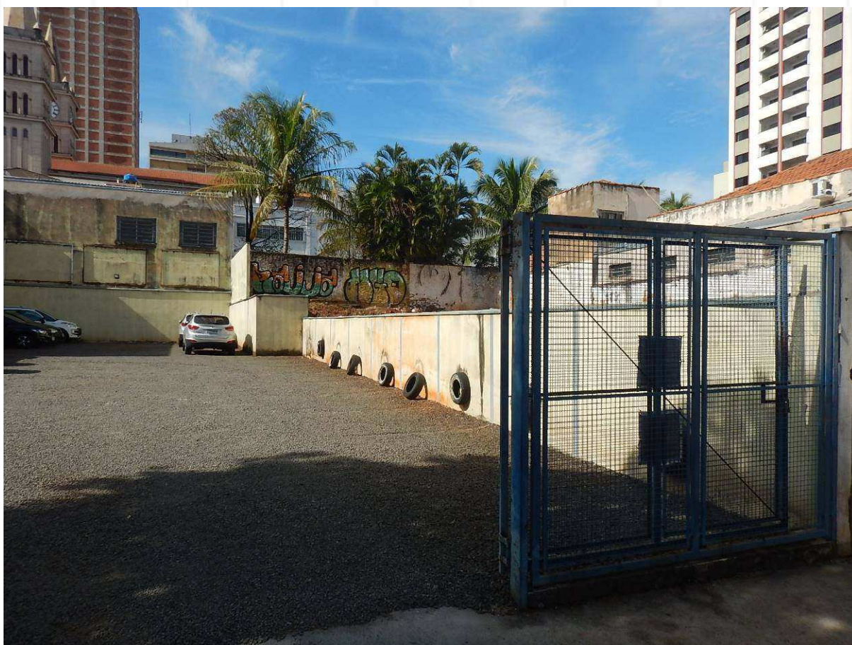
VISTA DA FACHADA DO IMÓVEL II , DE Nº 1.023 DA RUA ALFERES JOSÉ CAETANO.
