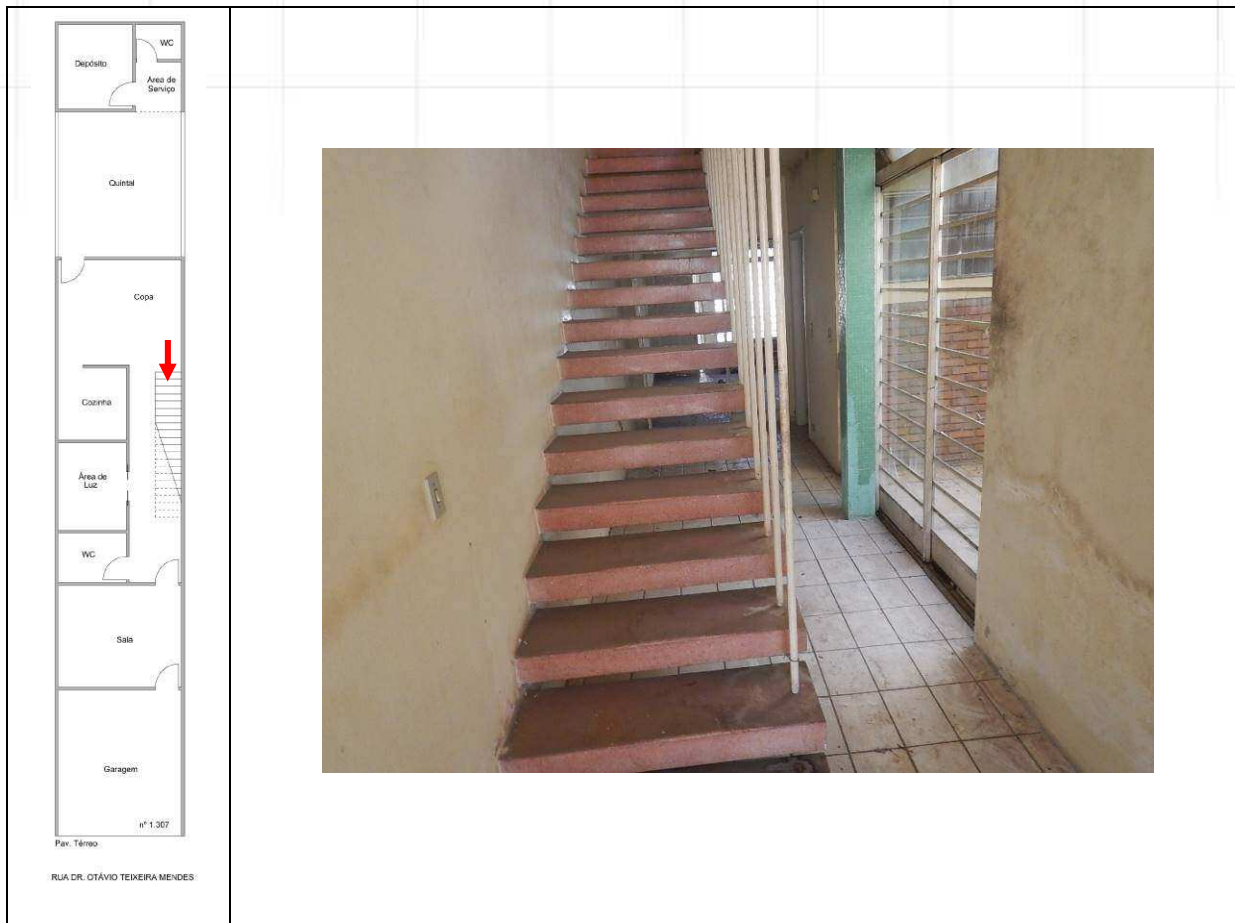
ESCADA DE ACESSO AO PAVIMENTO SUPERIOR.
