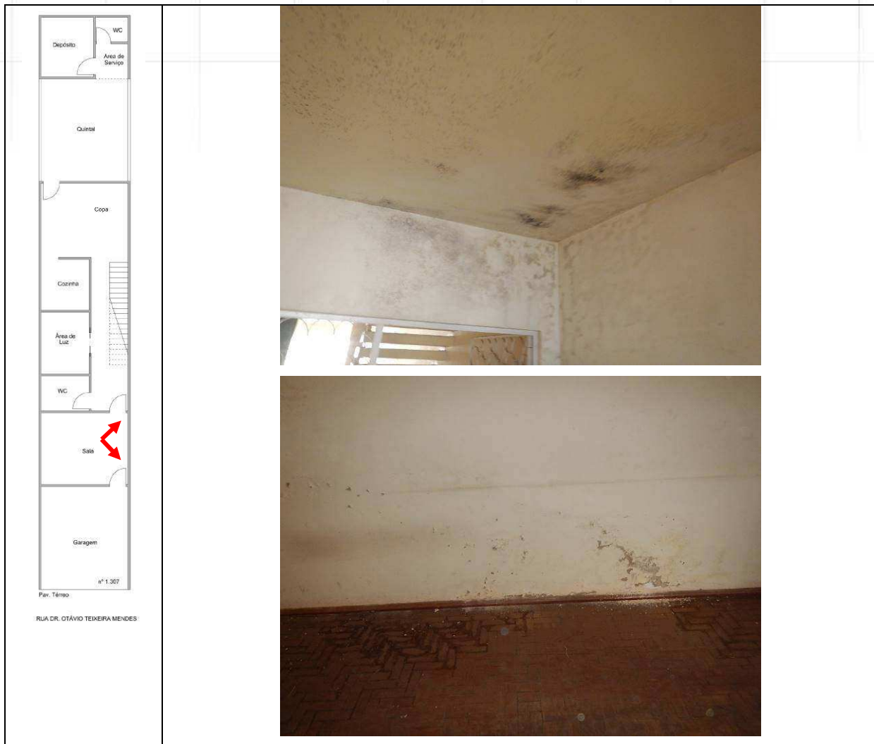
DETALHES DE MANCHAS DE UMIDADE NAS PAREDES E TETO DA SALA.
