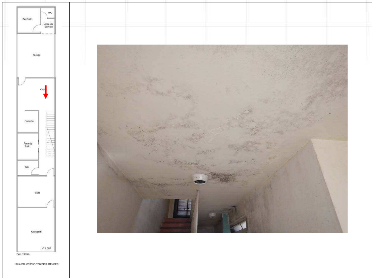
DETALHE DE MANCHA DE UMIDADE NO TETO.
