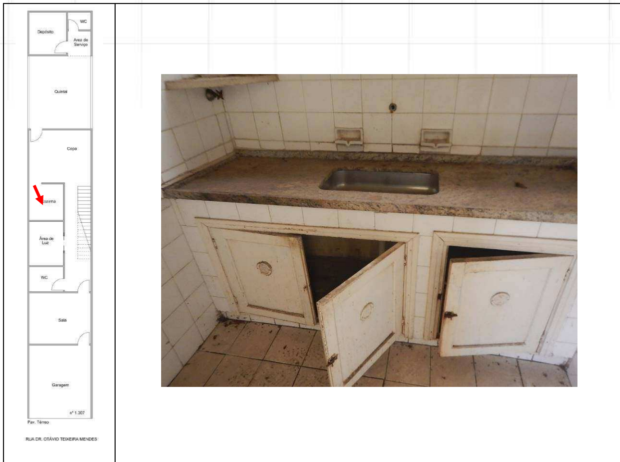
DETALHES DO MAU ESTADO DE CONSERVAÇÃO DOS ARMÁRIOS DA COZINHA.
