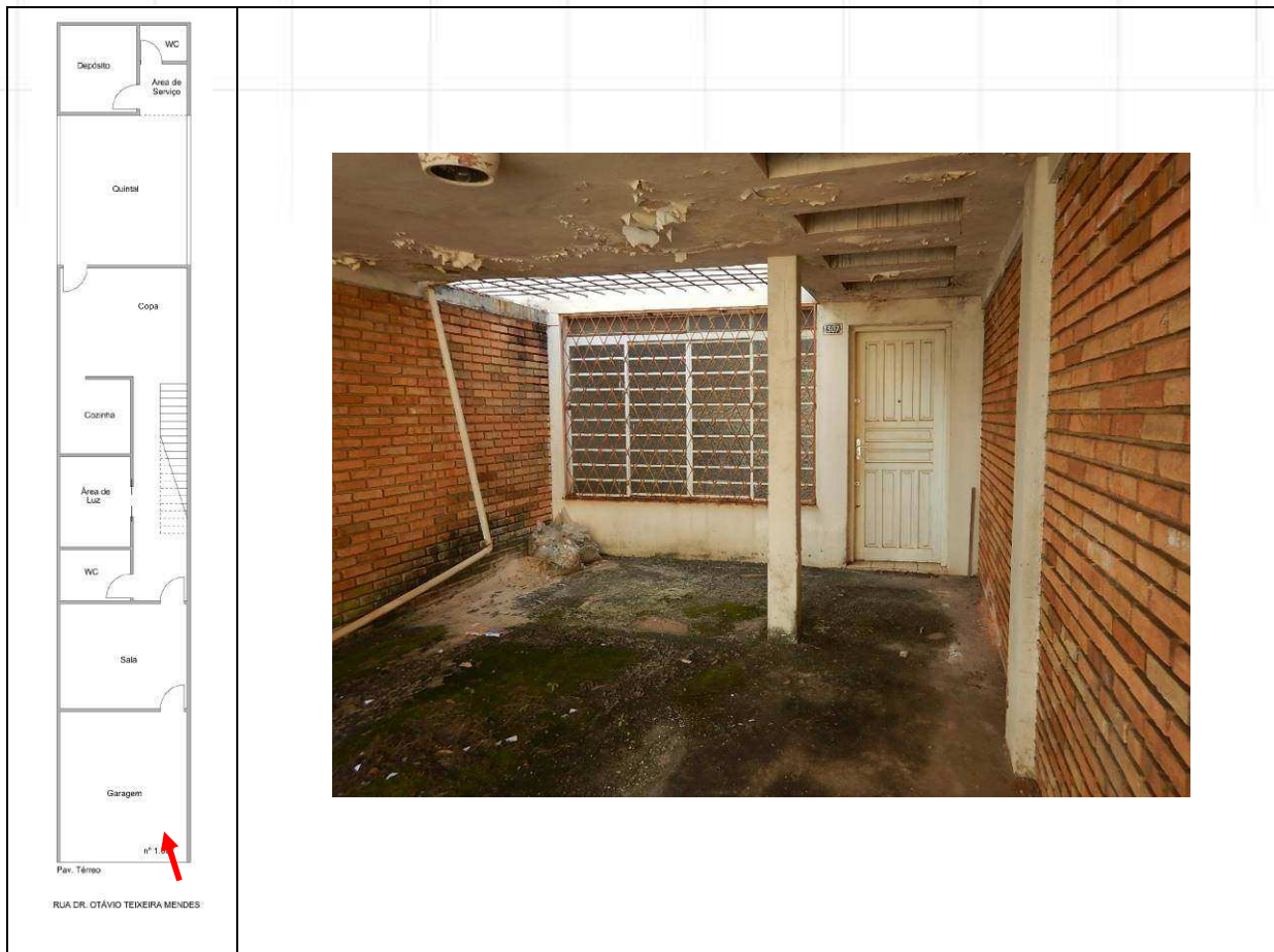
VISTA DA GARAGEM.
