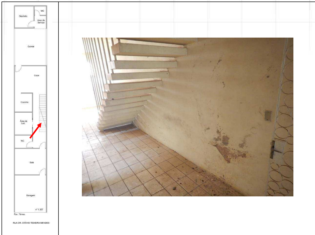
DETALHES DE MANCHAS DE UMIDADE NA PAREDE DE DIVISA.
