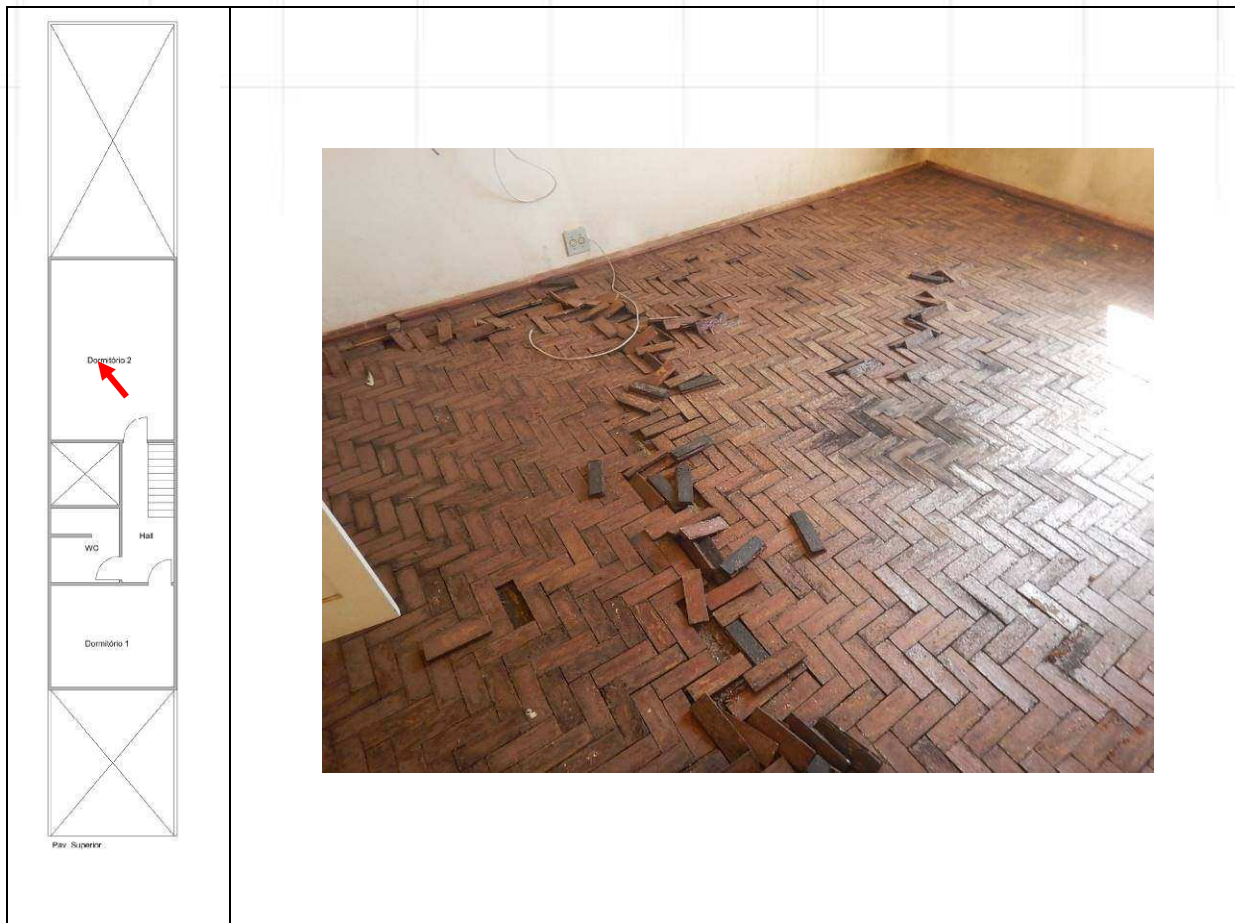
DETALHE DO PISO DANIFICADO.
