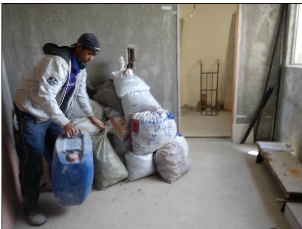
FOTO 06 – VISTA DA ÁREA DE SERVIÇO DO IMÓVEL
