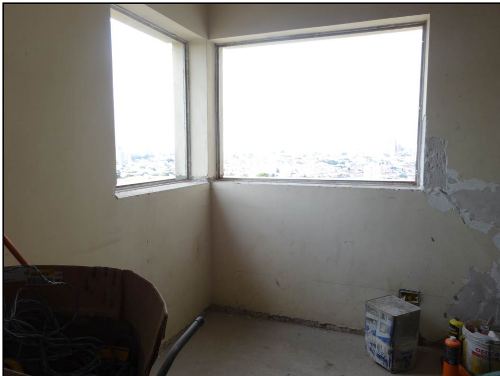
FOTO 08 – VISTA DA SUITE 01
