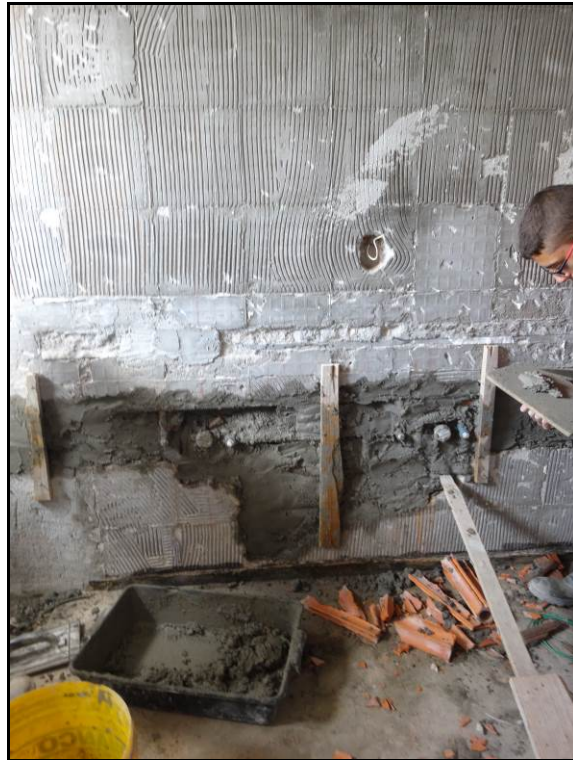
FOTO 12 – VISTA DO SANITÁRIO DA SUÍTE 02
