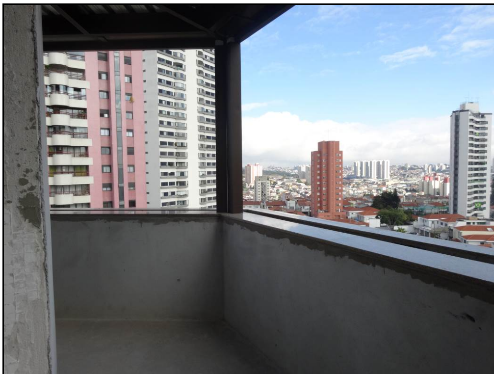
FOTO 16 – VISTA DA SACADA
