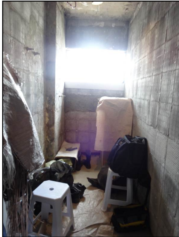
FOTO 10 – VISTA DO SANITÁRIO DA SUÍTE 01
