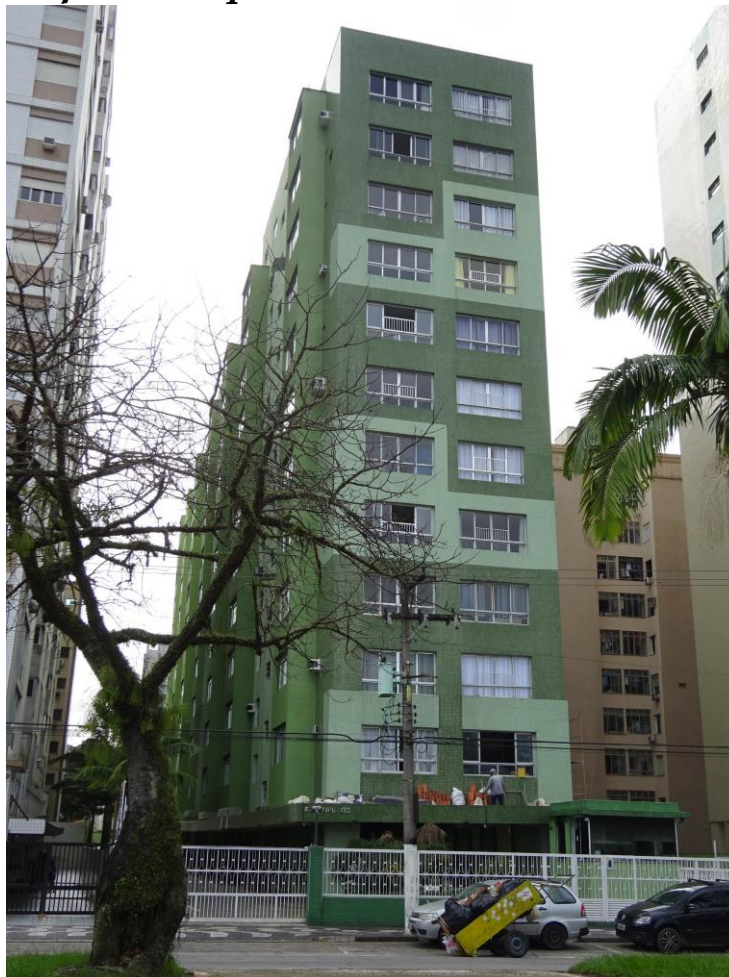
FOTO 1: Vista da fachada frontal e lateral esquerda do Edifício Itaipu.
