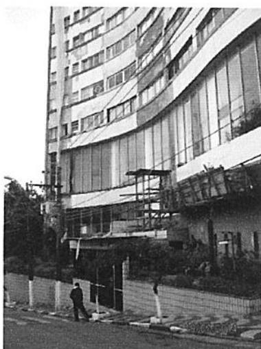
FOTO Nº 01: Visualização da fachada do prédio que abriga o imóvel avaliando, localizado na Alameda Ary Barroso nº61.
