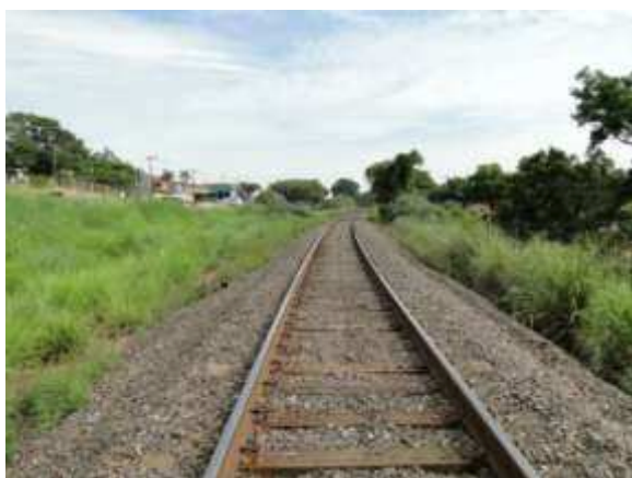
FOTO N.º 21- Tomada do leito ferroviário, no sentido da cidade de Nova Odessa, que faz divisa com a gleba avalianda.
