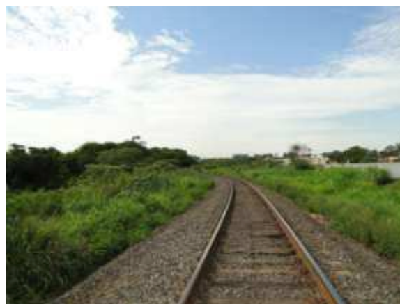
FOTO N.º 22- Aspecto do leito ferroviário, no sentido da cidade de Sumaré, que faz divisa com a gleba avalianda.
