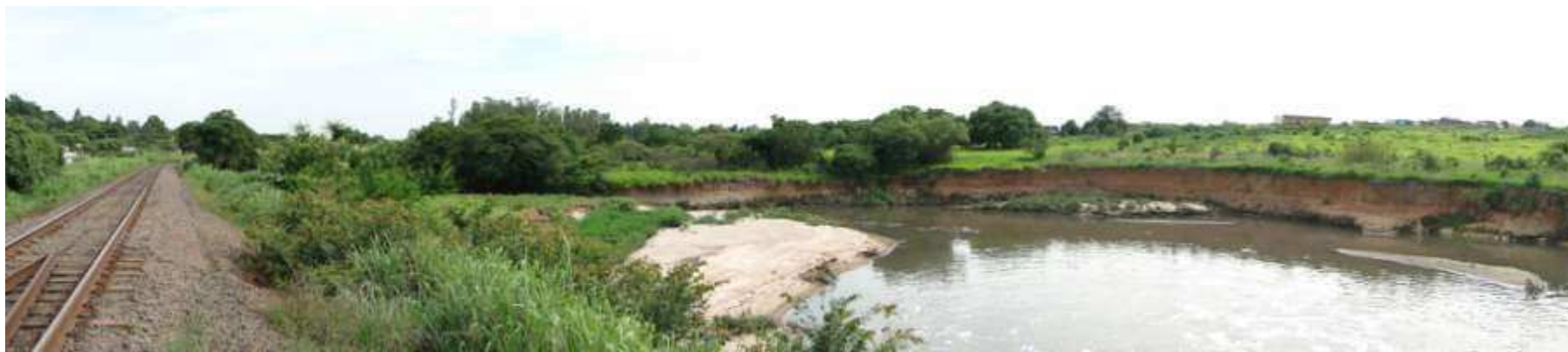
FOTO N.º 26- Aspecto panorâmico geral da divisa da gleba avalianda, com a via férrea, e com o ribeirão Quilombo.
