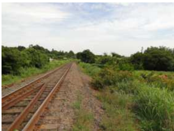
FOTO N.º 13- Vista da via férrea, que faz divisa com a gleba avalianda.
