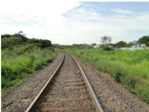
FOTO N.º 11- Aspecto da via férrea, no sentido Sumaré, que faz divisa com a gleba avalianda.
