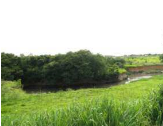
FOTO N.º 20- Vista interna da gleba avalianda, sendo cortada pelo ribeirão Quilombo, observada a partir do leito ferroviário.
