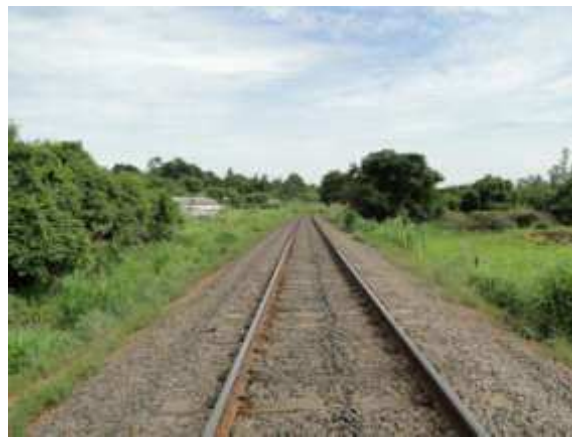
FOTO N.º 18- Tomada do leito ferroviário, que faz divisa com a gleba avalianda.
