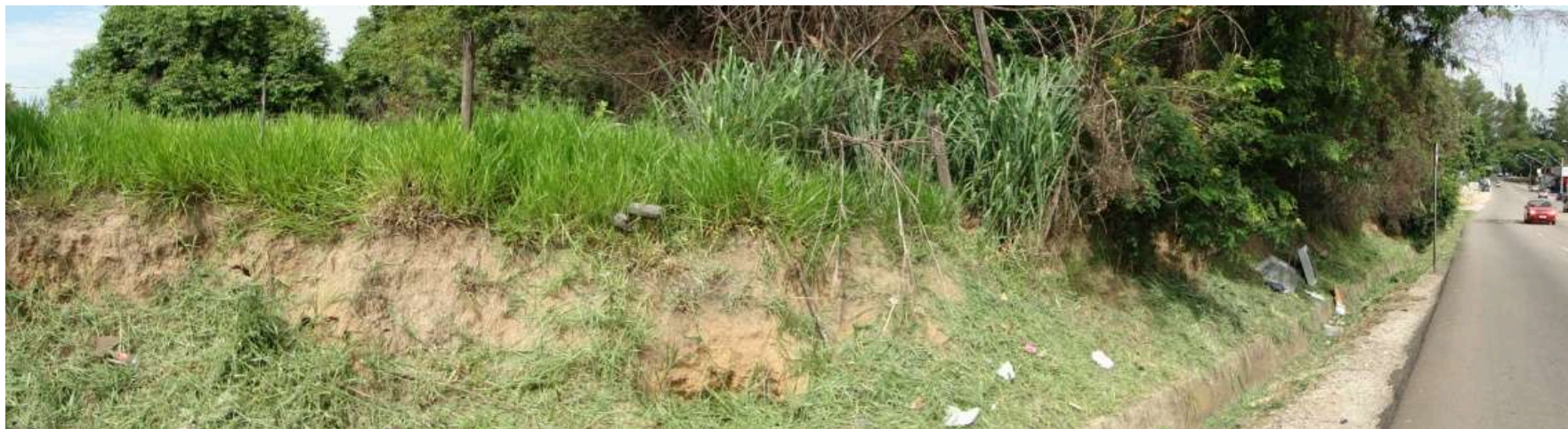
FOTO N.º 08- Tomada panorâmica externa da gleba avalianda, na face voltada para a av. Fuad Assef Maluf.
