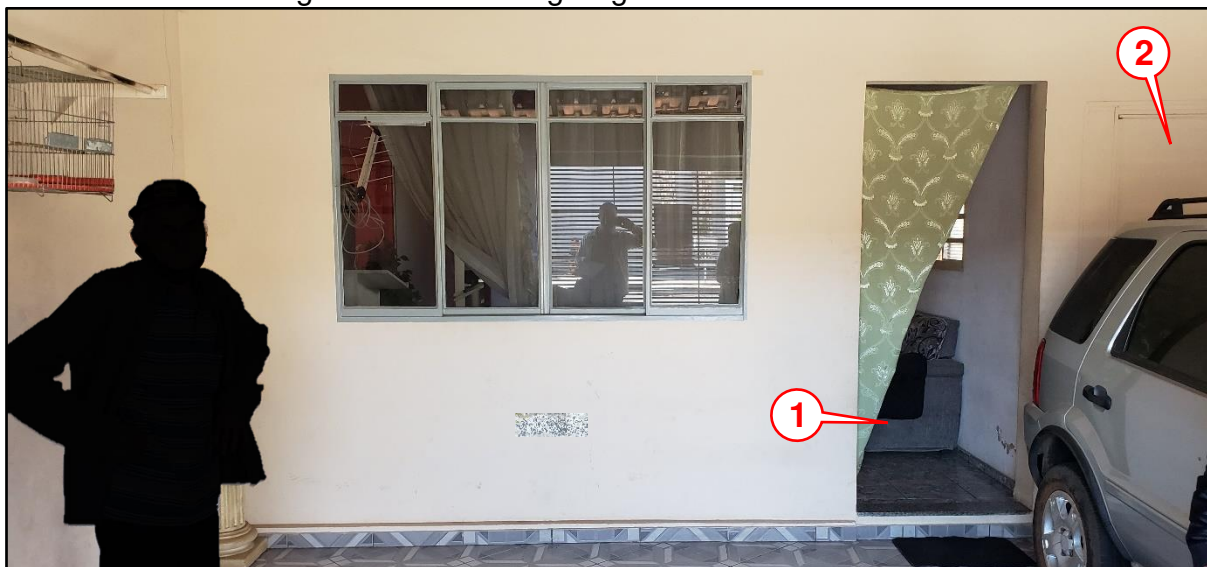
Figura 6 – Vista da garagem com acesso à sala
