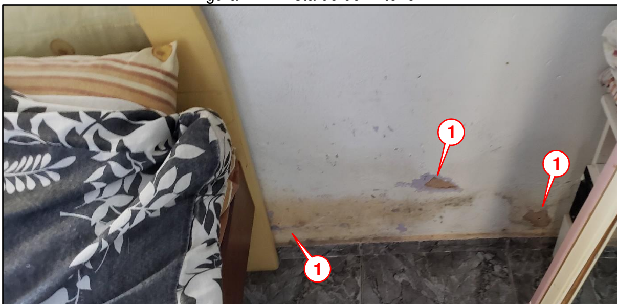
Figura 22 – Vista do dormitório 2
