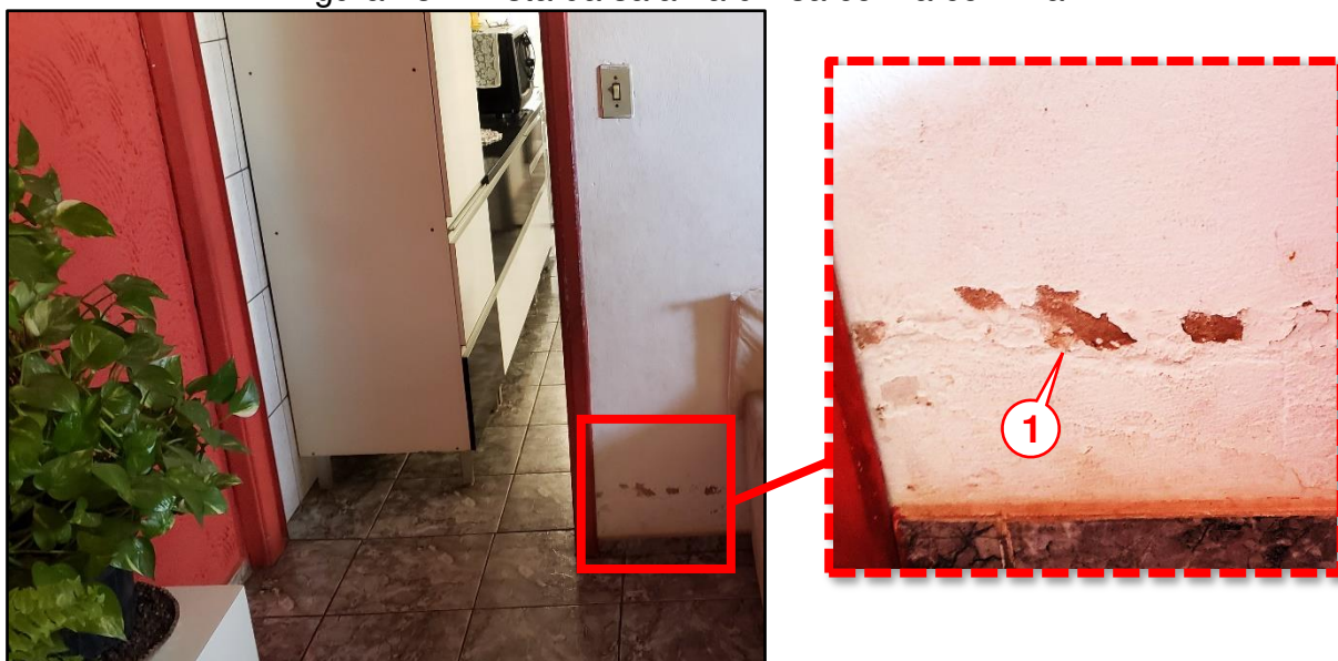
Figura 13 – Vista da sala na divisa com a cozinha
