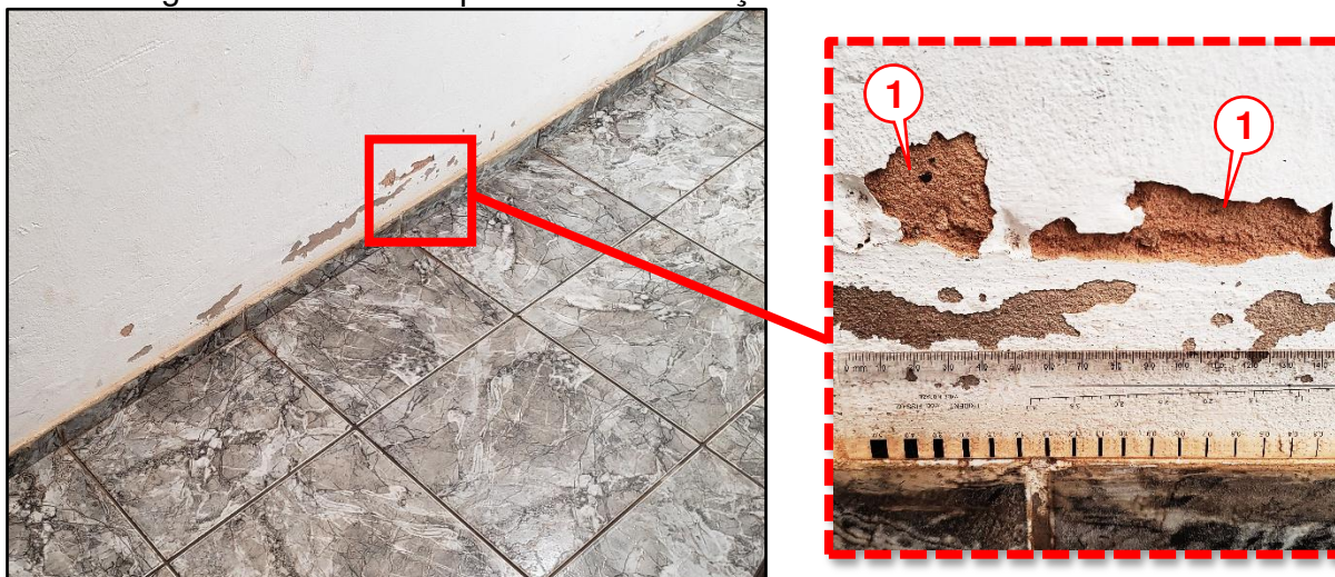
Figura 16 – Vista da parede da circulação interna na divisa do imóvel
