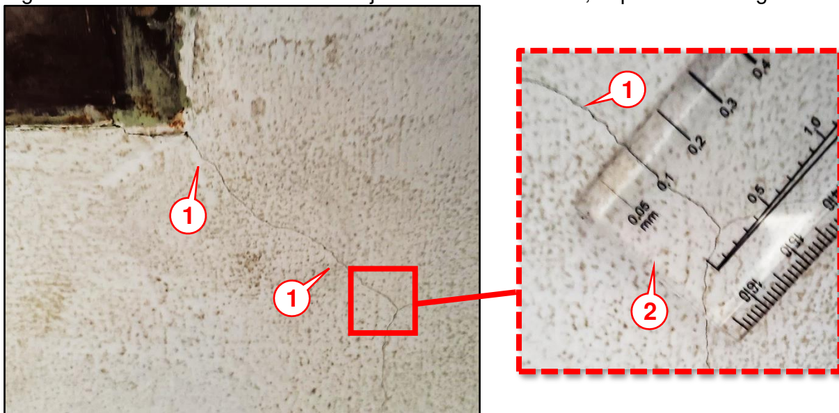
Figura 28 – Fissuras na alvenaria da janela do dormitório 3, espelhada da Figura 29a
