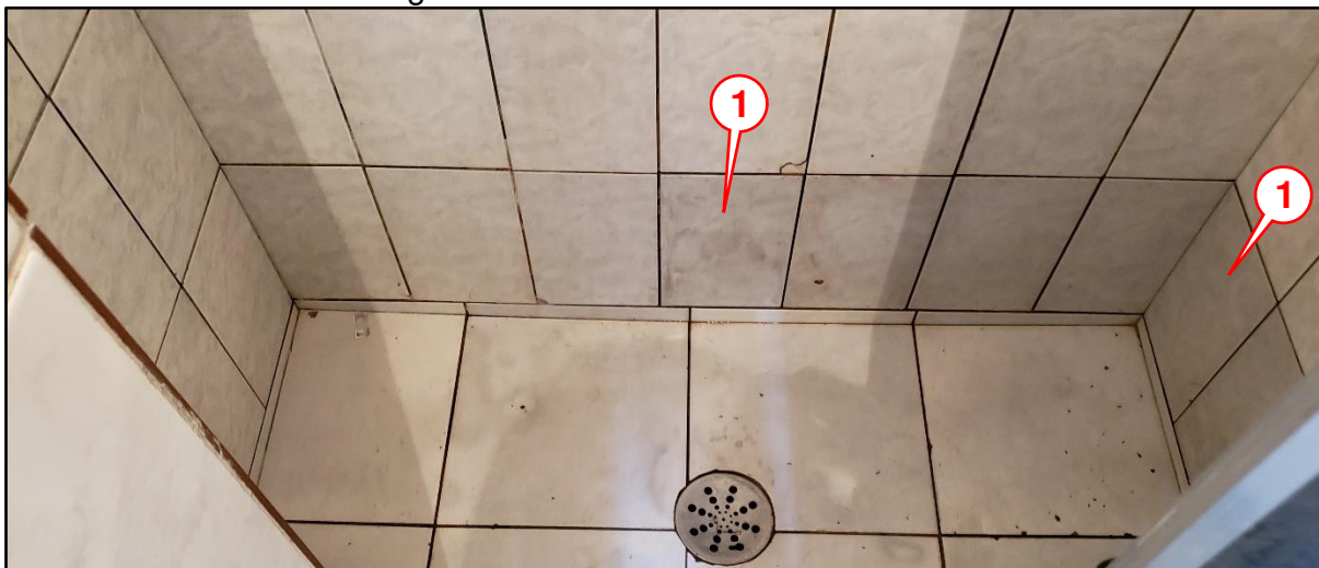
Figura 21 – Vista do box do banheiro
