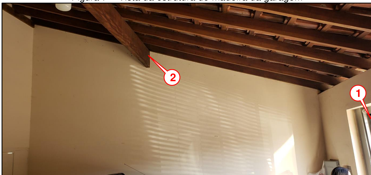
Figura 7 – Vista da estrutura de madeira da garagem
