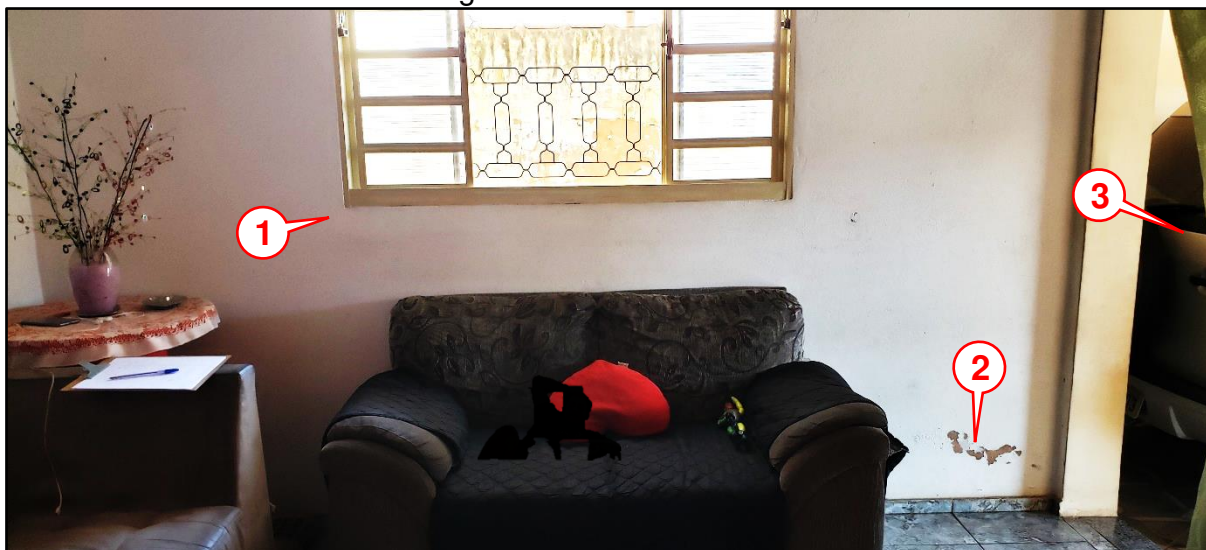
Figura 11 – Vista da sala
