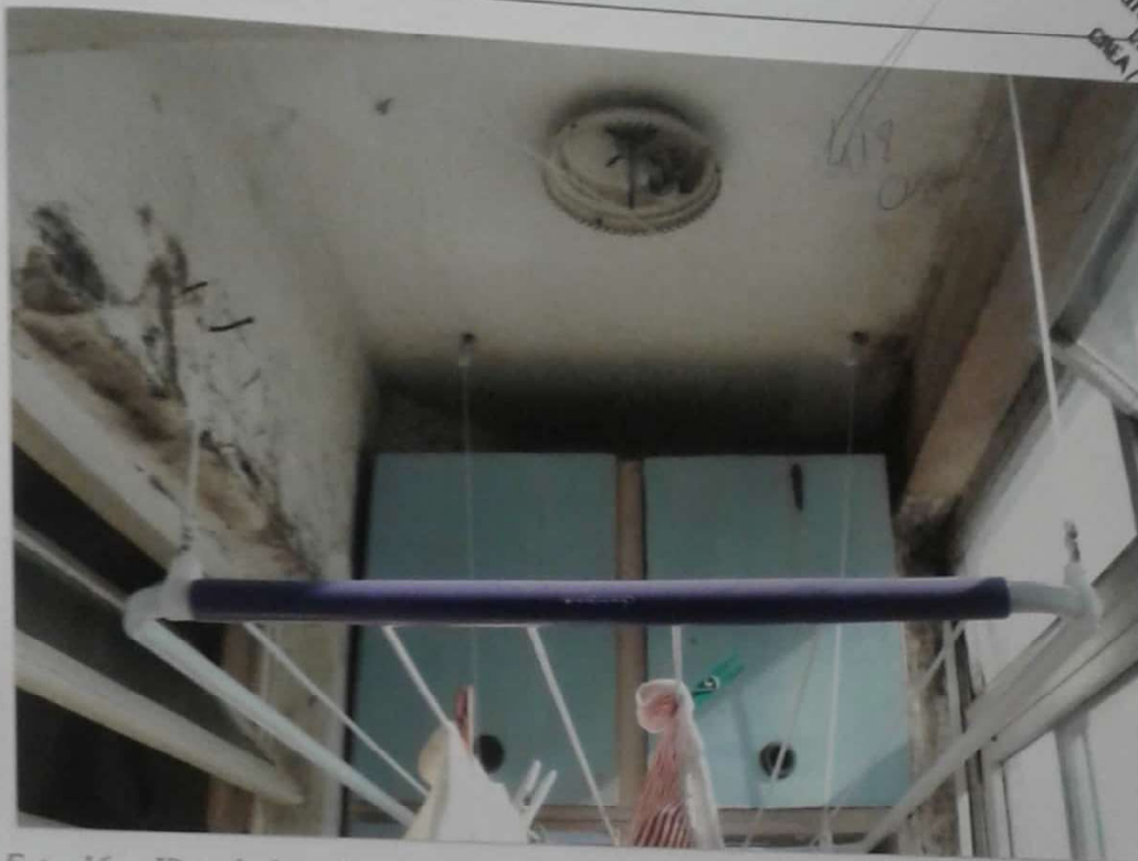
Foto 16 - Vista da área de serviço, com paredes e teto impregnados de umidade, aparentemente não sanada.
