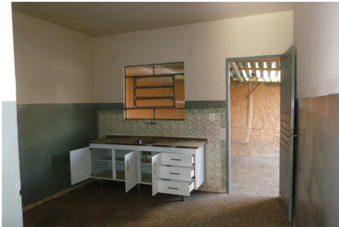
Foto 03 – Vista da cozinha com laje de forro, piso cerâmico comercial e revestimento de azulejos somente na parte da pia em razoável estado de conservação.
