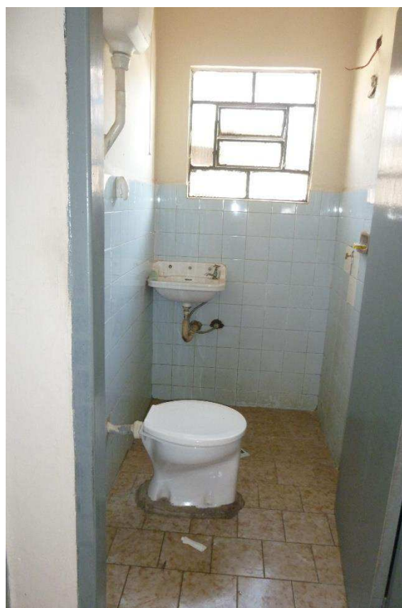
Foto 07 – Vista do único banheiro da casa de acabamento simples, com piso cerâmico e revestimento nas paredes até meia altura.
