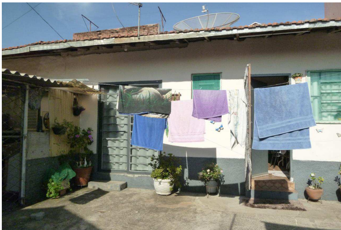
Foto 08 – Vista da construção existente nos fundos do terreno que contém uma sala, um quarto e um banheiro.
