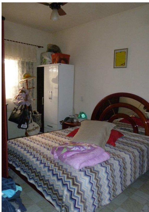
Foto 11 – Vista do único dormitório da casa com piso cerâmico, laje de forro e pintura em razoável estado de conservação.
