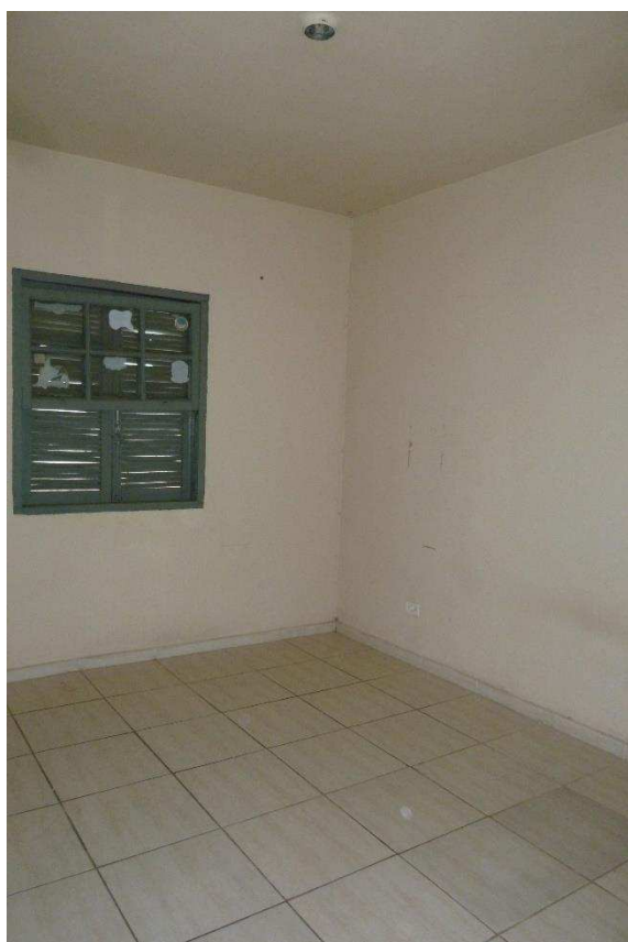
Foto 06 – Vista de um dos quartos com laje de forro, piso cerâmico e pintura em razoável estado de conservação.
